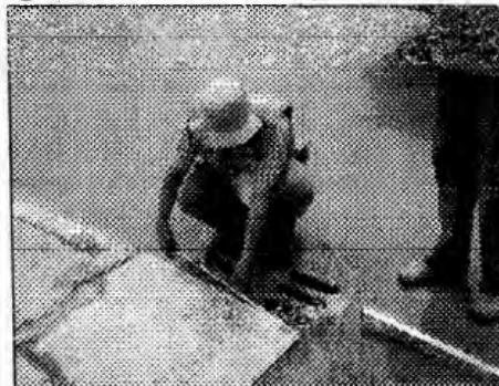
Figura 43. Medición de sumideros
