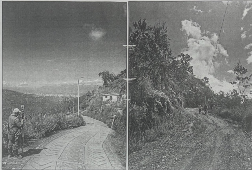
Placa Huella en la Vereda La Capilla
