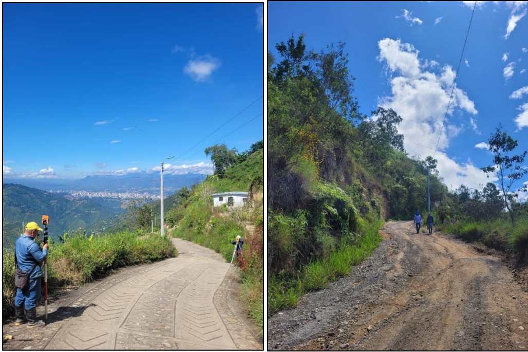
Placa Huella en la Vereda La Capilla
