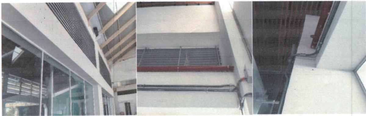
Panorámica General traslado de tubería
