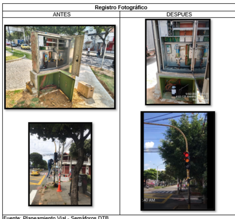
Figura 20. Registro fotográfico antes-después — mantenimiento de equipos de control y postes semafóricos. Fuente: Planeamiento Vial – Semáforos DTB.
