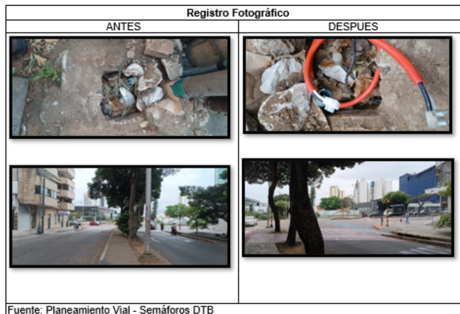
Figura 19. Registro fotográfico antes-después — recuperación operativa de cruces semaforizados. Fuente: Planeamiento Vial – Semáforos DTB.
