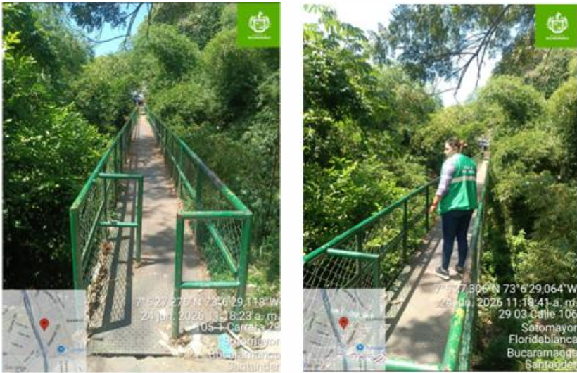
Puente Peatonal sobre quebrada El Macho
