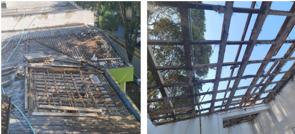
Fotografía No. 2. Retiro total cubierta área de pediatría
