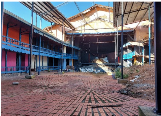
Estado Interior de la edificación.
