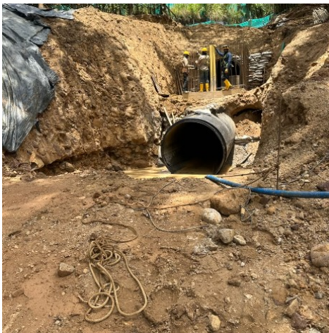
Suministro e instalación de tubería PEAD estructurada Ø1800 mm
