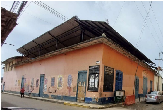
Estado Fachada Actual
