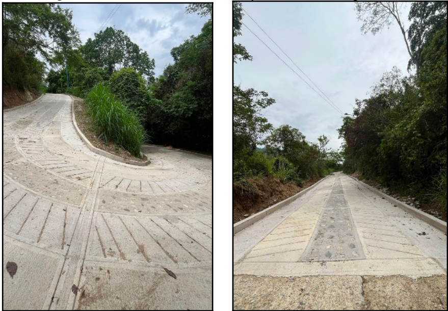
Placa Huella en la Vereda Bolarqui Bajo
