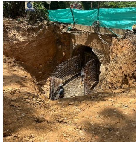
Construcción de estructura de empalme
