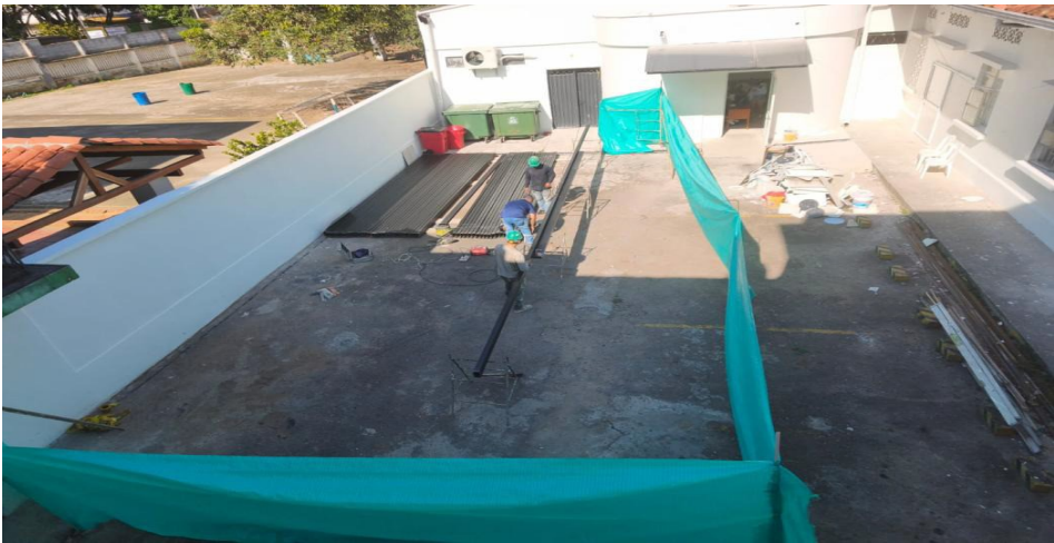
Fotografía No. 5. Zona de alistamiento de elementos para instalación cubierta de rayos X
