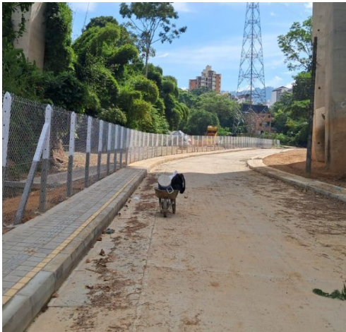
ación Concreto MR41 Paviment
