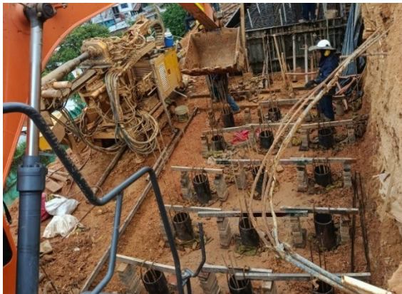
Encamisado para micropilotes
