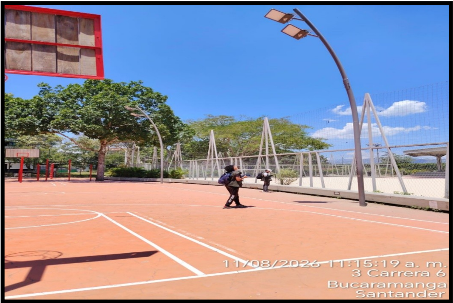
Foto 3. Se revisa por parte de los apoyos técnicos de la supervisión de alumbrado Público, el levantamiento del inventario de los elementos que conforman el sistema de alumbrado público del parque divino porvenir comuna 11
