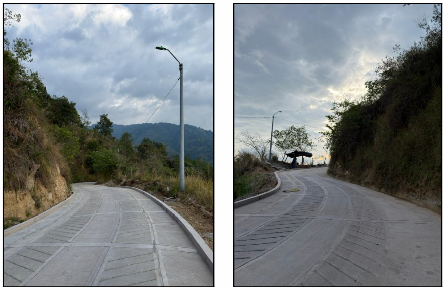
Placa Huella en la Vereda Bolarqui Alto
