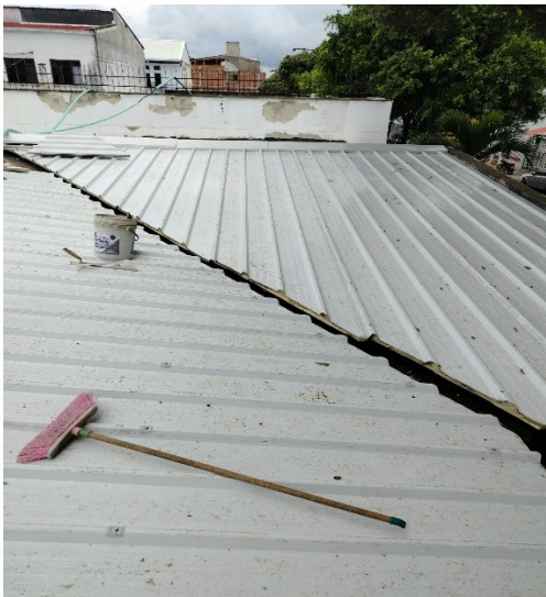
Fotografía No. 4. Instalación de cubierta nueva e impermeabilización de canales
