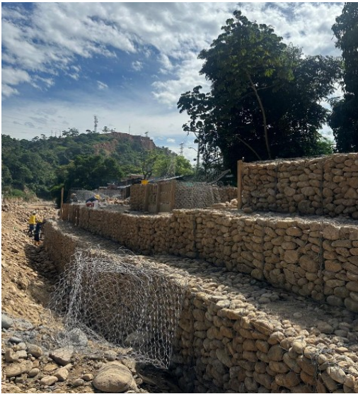
Conformación de gaviones margen derecha Río de Oro
