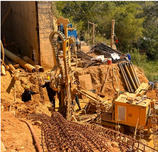
Construcción de micropilotes para cimentación de muro de contención.
