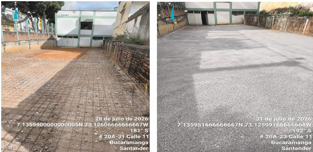
Fotografía No. 1. Endurecimiento zona parqueadero sótano
