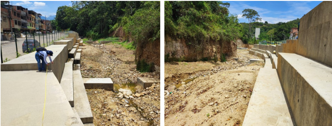
Construcción de muro en gavión
