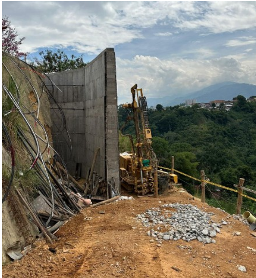
Construcción de Muro de contención que permitirá conformar vía en la parte superior.
