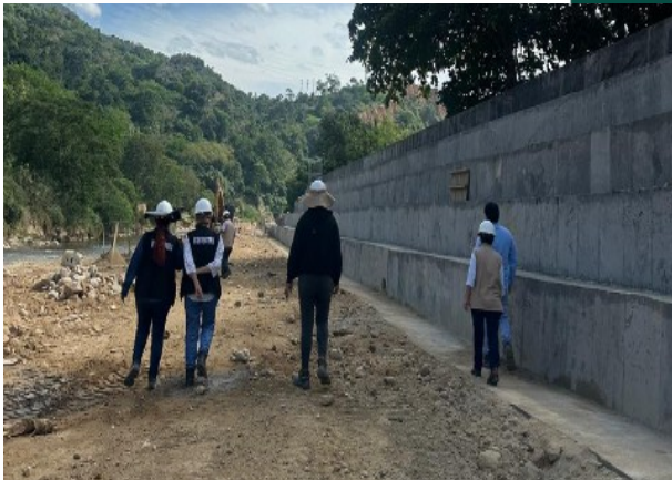
Vista General de gavión construido
