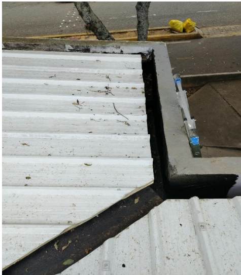
Fotografía No. 4. Instalación de cubierta nueva e impermeabilización de canales
