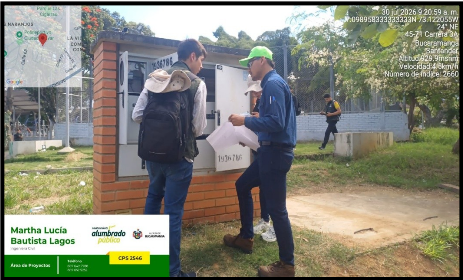
Foto 2. El equipo de apoyo a la supervisión revisa que los elementos cargados en campo a la plataforma coincidan con los respectivos BA de las luminarias (parque Los Canelos, comuna 8 – 30/07/2026).
