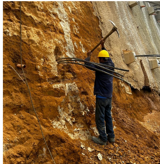
Excavación a mano en descolgado del talud para zapatas
