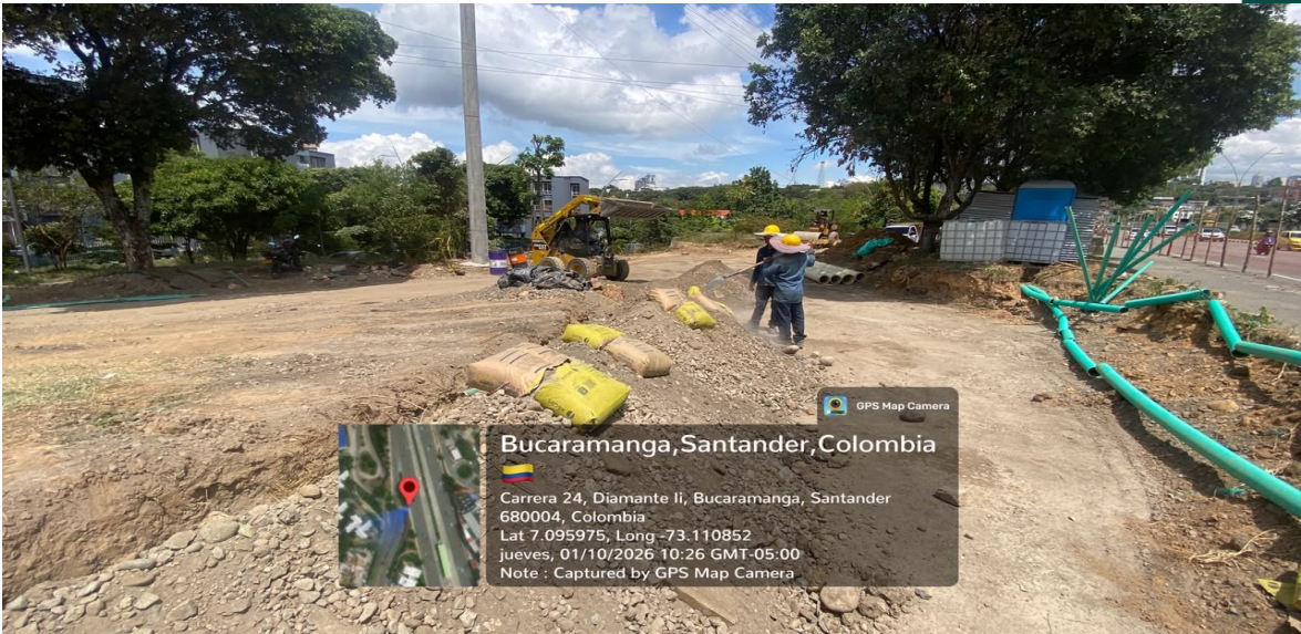
Ilustración 2. Conformación de Banca y relleno en vía de aceleración nueva Cra. 24 con salida a la autopista Bucaramanga - Floridablanca.
