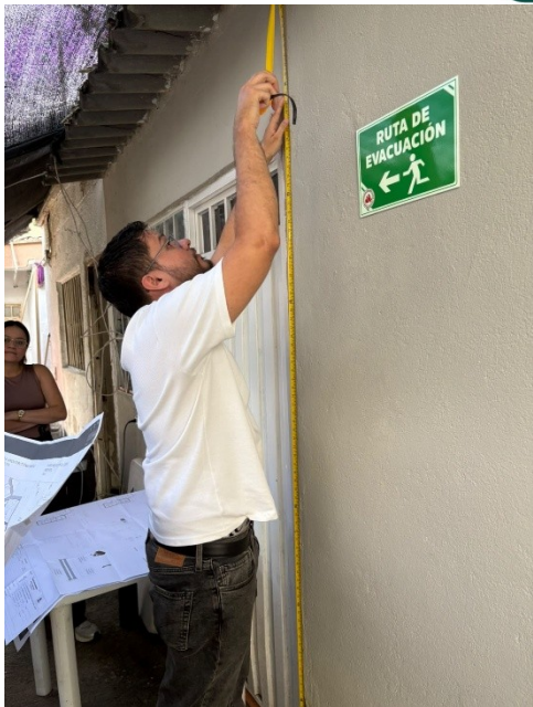
Realizar las mediciones y verificaciones correspondientes en sitio, con base en los planos y especificaciones técnicas.
