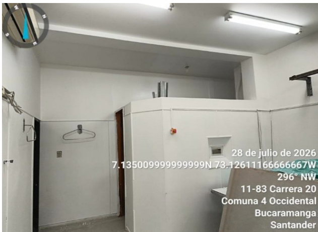
Fotografía No. 3. Intervenciones internas pintura Zona de rayos X.
