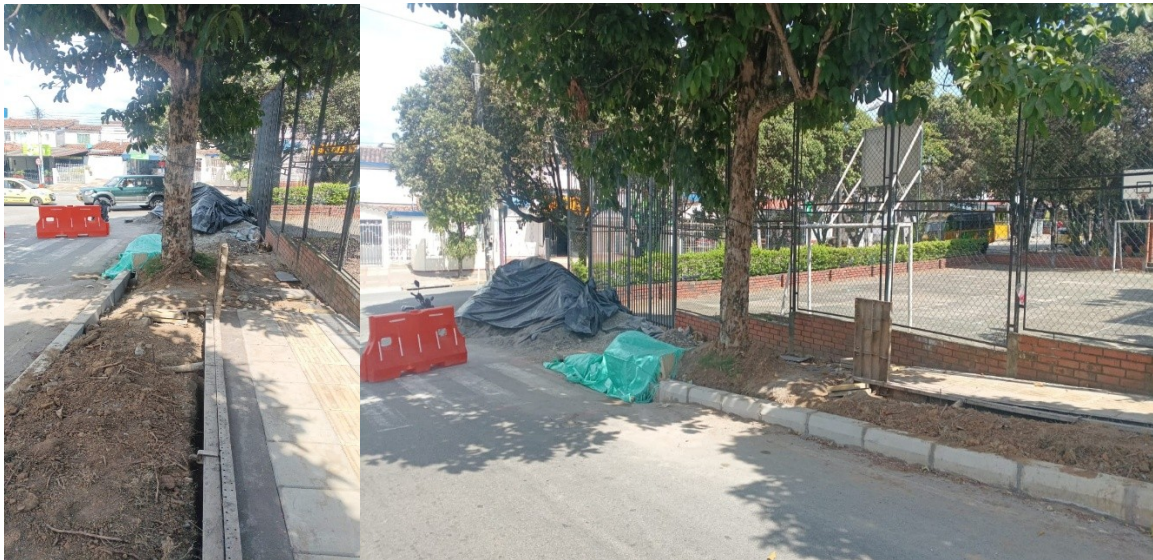
Ilustración 6. Adecuación de espacio peatonal costado izquierda Calle 83 - Barrio D
