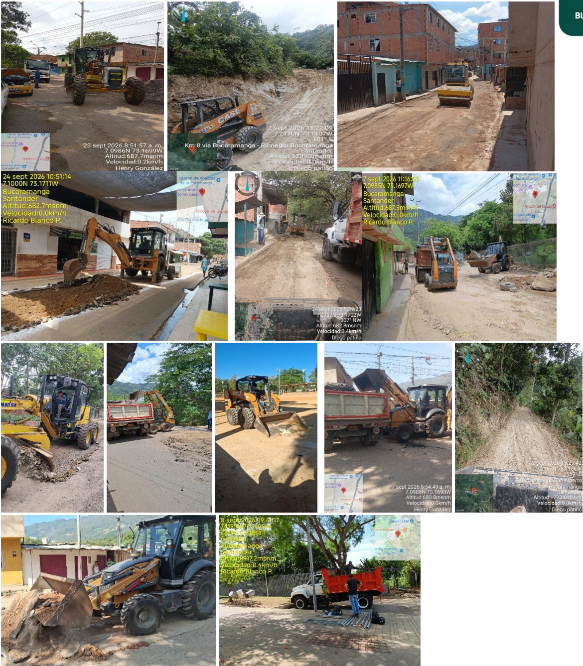
REGISTRO FOTOGRAFICO-GRUPO MAQUINARIA
