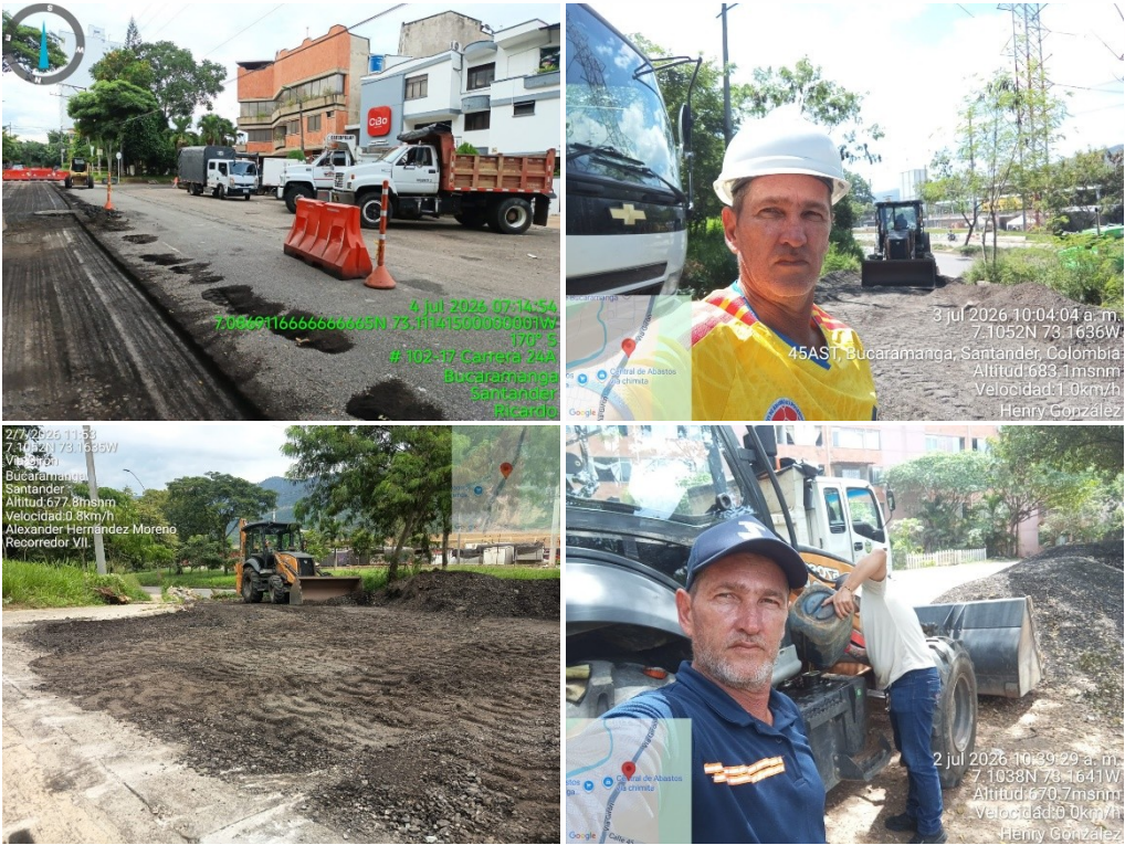
REGISTRO FOTOGRAFICO-GRUPO MAQUINARIA
