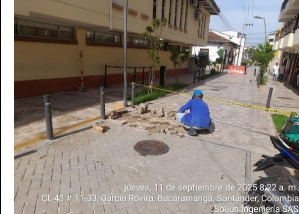
Mantenimiento de adoquín vehicular en travertino calle 41 entre carreras 11 y 12
