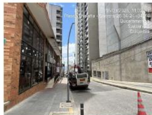
Instalación de luminarias en calle 34 carrera 26.
