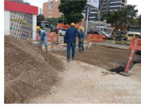
Instalación de base granular en losas A37 y C37 en calle 37 frente a edificio SURA.
