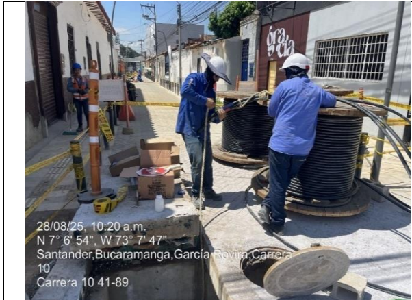
Instalación de cableado para red de MT en la cra 10 entre 42 y 43
