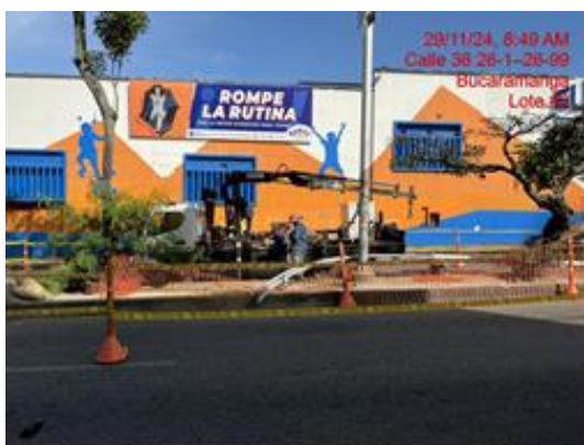
Imagen 1. Instalación de postes
