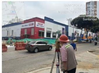
Levantamiento topográfico en calle 36 con carrera 26 en losas A36, B36, C36, D36 y andenes en carrera 26 entre calle 37 y 37, para cuantificar cantidades.
