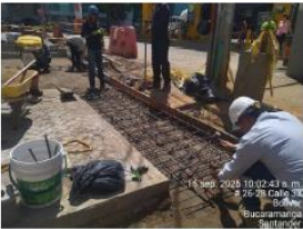
Instalación de acero de refuerzo en losa U37.
