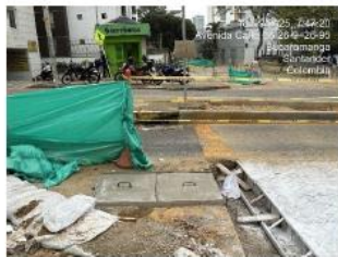
Instalación de concreto MR42 en tapas de cajas de barraje MT en intersección 36.
