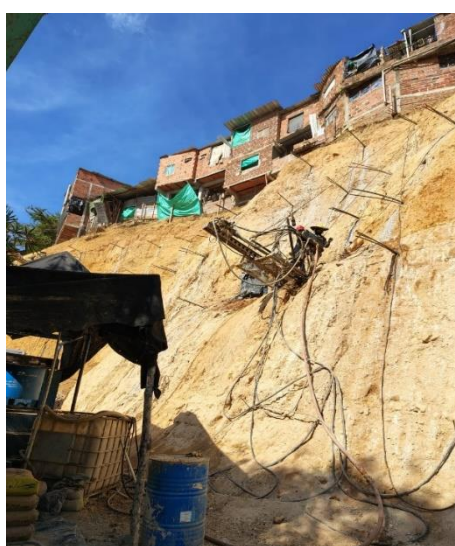
IMAGEN No 2. PERFORACIONES E INSTALACION DE ANCLAJES
