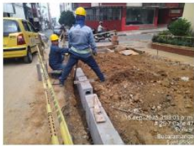
Instalación de sardinel prefabricado en andén costado norte calle 37 # 25 - 09 frente a papelería.
