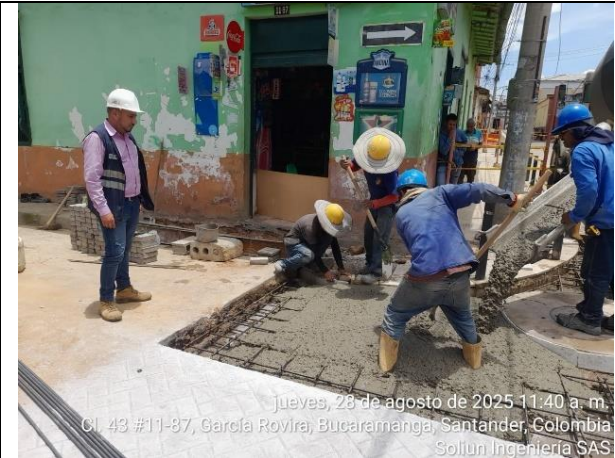
Fundida de losas vehiculares MR42 sobre calzada vehicular
