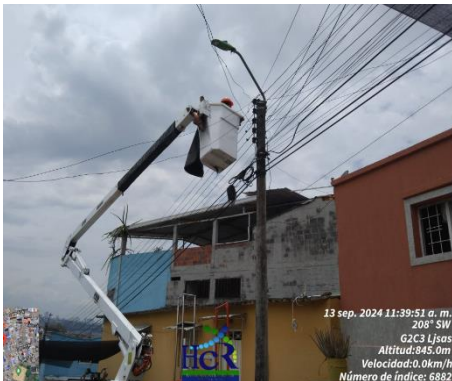
Imagen N°2 Reemplazo de luminaria
