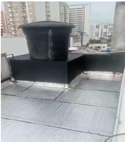
IMAGEN No 1: IMPERMEABILIZACION PLACA DE CUBIERTA
