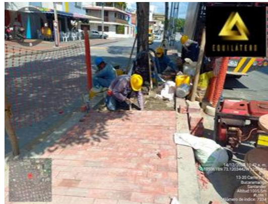
Imagen 2. Instalación de adoquín
