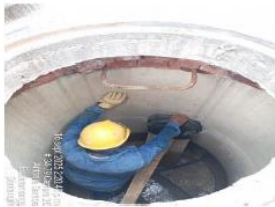
Instalación de charnelas en pozos en carrera 26.
