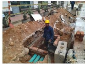
Construcción de caja de comunicaciones en andén costado norte calle 37 # 26 - 15 frente a edificio Parque Central.
