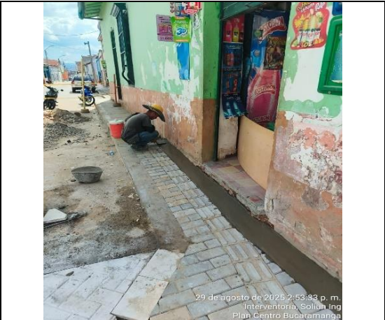
Fundida de franja de ajuste sendero peatonal
