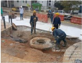
Demolición de corona de pozo con martillo eléctrico en intersección calle 36.
