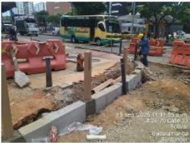
Instalación de bolardos en esquina andén costado norte calle 37 frente a edificio SURA.
