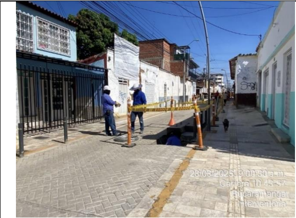
Instalación de cableado para red de MT en la cra 10 entre 42 y 43
