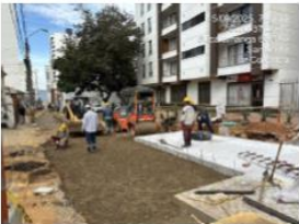
Seriado de base granular en losas U37, W37 y Y37.
