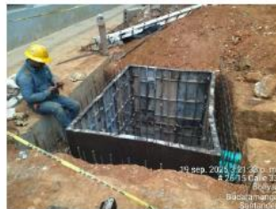
Instalación de formaleta para caja de barraje MT en esquina de DROSAN carrera 26 calle 37.
