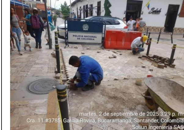
Mantenimiento de adoquín vehicular en travertino cra 11 entre calles 37 y 41
