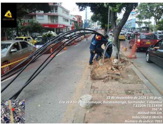
Imagen 2. Tendido de redes
