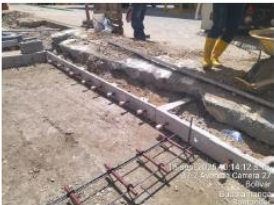
Instalación de pasadores para junta de expansión en losas Q37, S37, U37, W37 y Y37 en calle 37 frente a Daytona.
