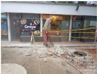
Demolición de pavimento flexible con compresor eléctrico en andén oriental carrera 26 # 36 - 49 frente a edificio Parque Central.
