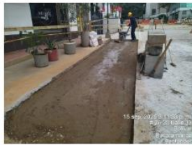
Compactación de base con rana en andén costado norte calle 37 # 26 - 35 frente a edificio Parque Central.
