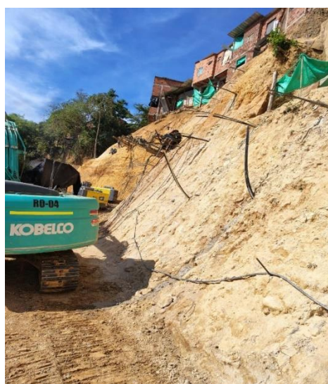
IMAGEN No 2. PERFORACIONES E INSTALACION DE ANCLAJES
