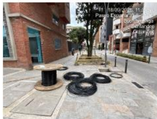
Instalación de cableado para red de alumbrado público en carrera 26 entre calles 34 y 35.
