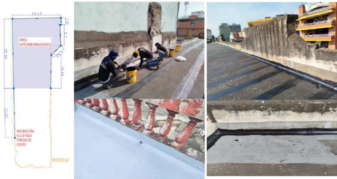
Figura 1- Rehabilitación de impermeabilización mediante sistema BUR de mediacañas, sobre manto asfáltico con el uso de membrana líquida acrílica. Incluye puente de anclaje de impermeabilización existente, limpieza y acondicionamiento de superficie, reparación de dilataciones y zonas deterioradas e instalación completa de impermeabilización
