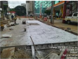
Instalación de concreto MR 42 en losas Q37, S37, U37, W37 y Y37 en calle 37 frente a Daytona.
