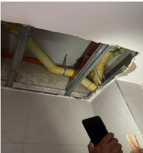
IMAGEN No 2: DEMOLICION CIELO RASO Y REVISION FILTRACIONES
