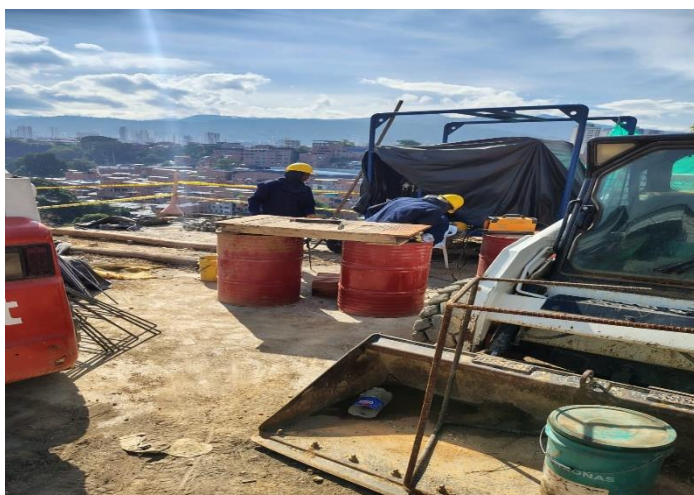
IMAGEN No 1. ELABORACION DE PARRILLAS DE ACERO PARA ANCLAJES
