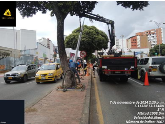
Imagen 1. Instalación de postes
