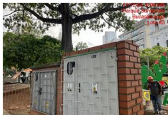
Imagen 2. Construcción de tablero
