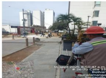
Levantamiento topográfico en calle 37 entre carrera 26 y 27 para cuantificar cantidades ejecutadas en el tramo de losas de la p37 a la y37.
