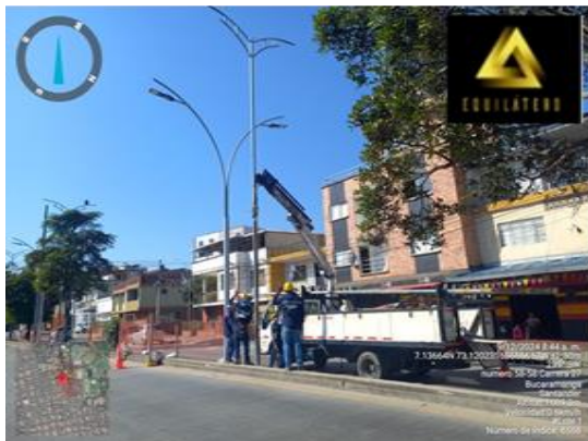
Imagen 1. Instalación de postes
