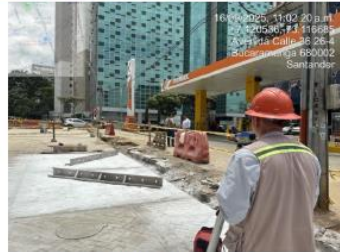
Revisión de niveles en losas MR y accesos a estación de servicio Primax y acceso a Daytona en calle 37 entre carrera 26 y 27.
