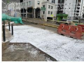
Instalación de concreto MR 42 en losas A36, B36, C36 y D36 en intersección calle 36.
