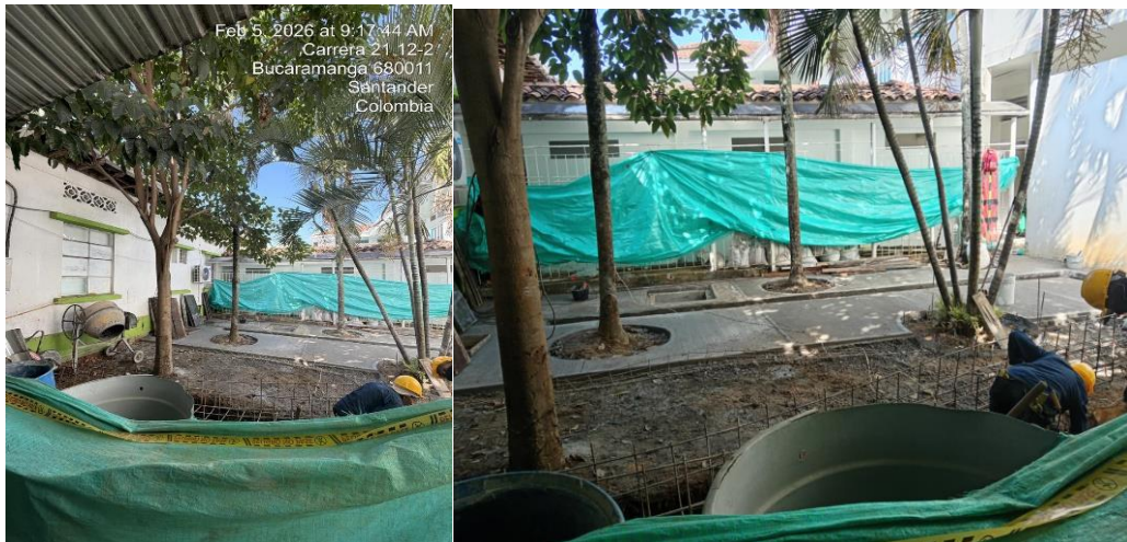
Fotografías 1 y 2. Intervención realizada en zona de jardín interior
