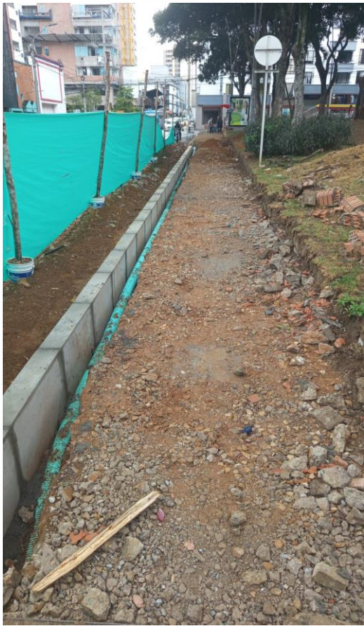
Replanteo e instalación de Sardinel
