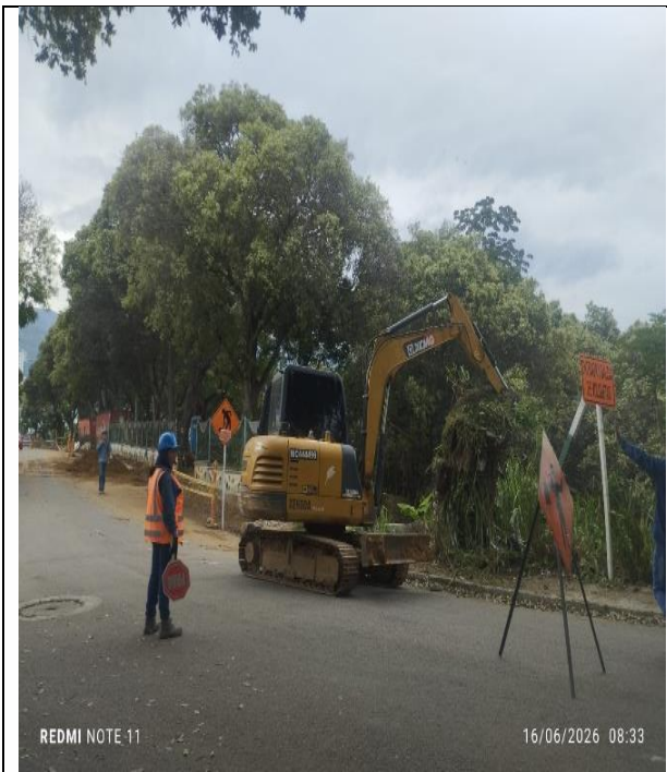
Inicio de intervención en tramo 1
