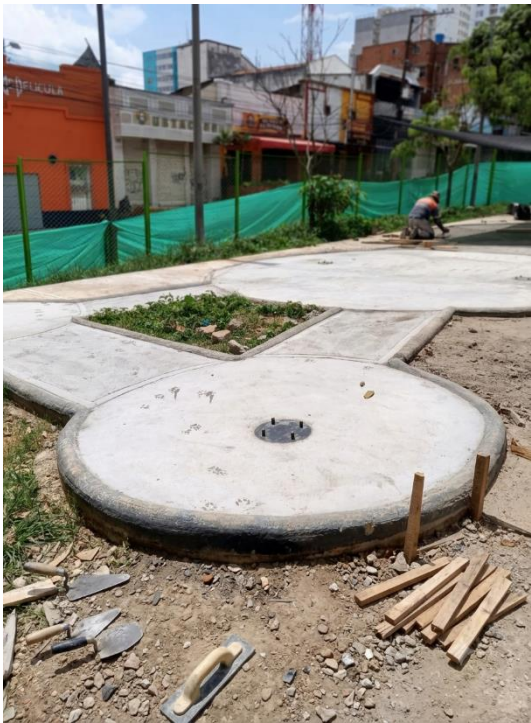
mejoramiento del piso y de las mallas de la zona de gimnasio biosaludable
