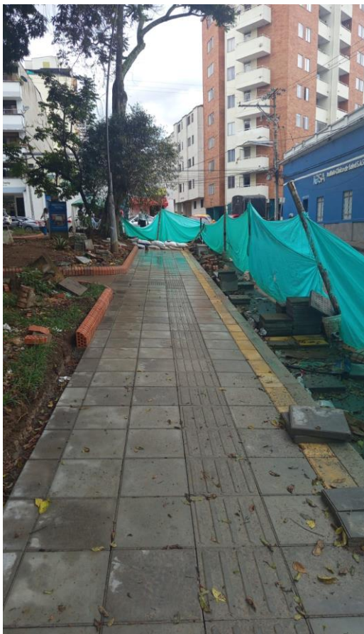
Instalación de anden y bordillo
