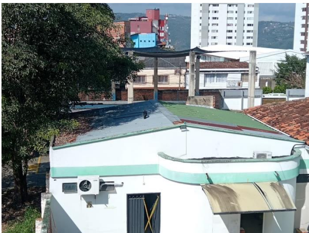
Fotografía 6. Cubierta de la zona de Rayos X.
