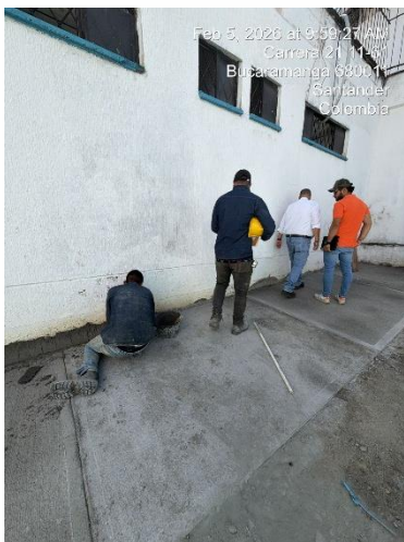
Fotografía 3. Avance en zona de jardín exterior.
