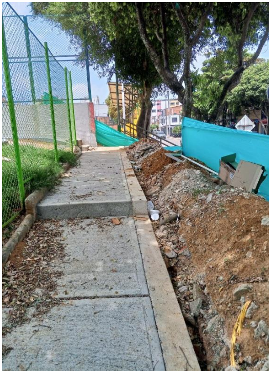
construcción del bordillo y del andén
