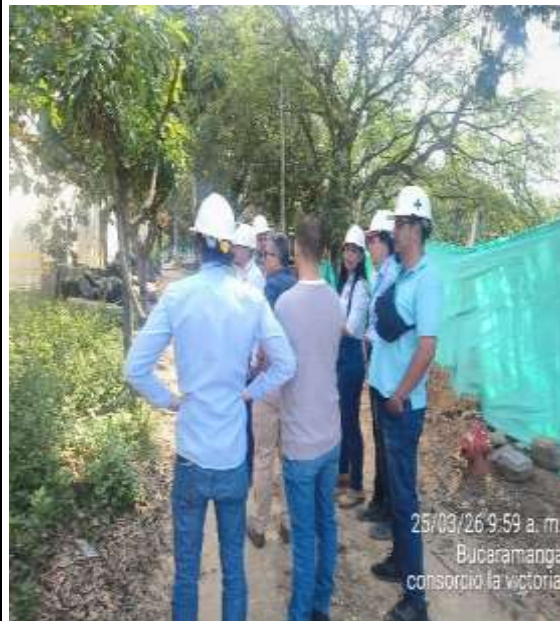
Recorrido de obra
