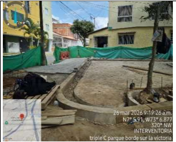
Recorrido de obra
