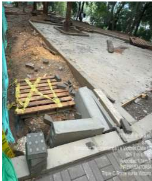
Protección cajas eléctricas tramo 5
