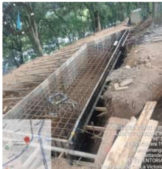
Armado tipo 6 tramo VI
