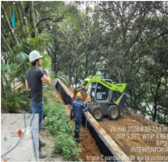
Relleno con material seleccionado, tramo 4
