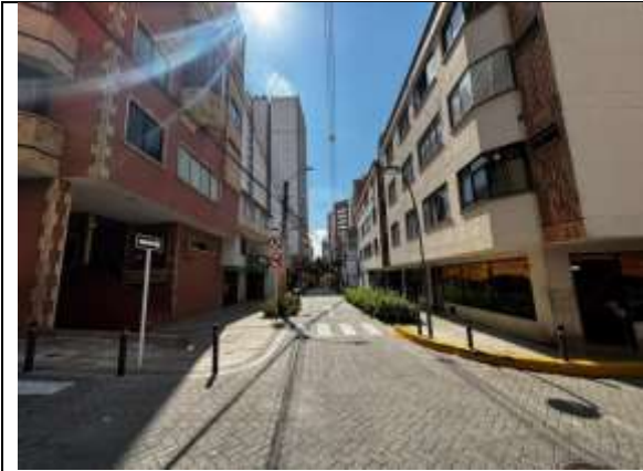
INTERSECCIÓN CARRERA 26 CALLE 33 SENTIDO SUR
