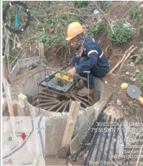
Construccion sendero peatonal
