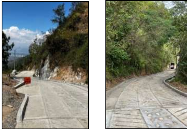
Placa Huella en la Vereda La Capilla
