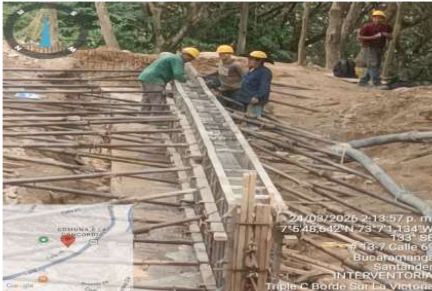
Concreto para vastago, tramo 2
