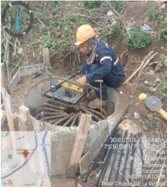
Intalacion platinas de apoyo estructura metalica
