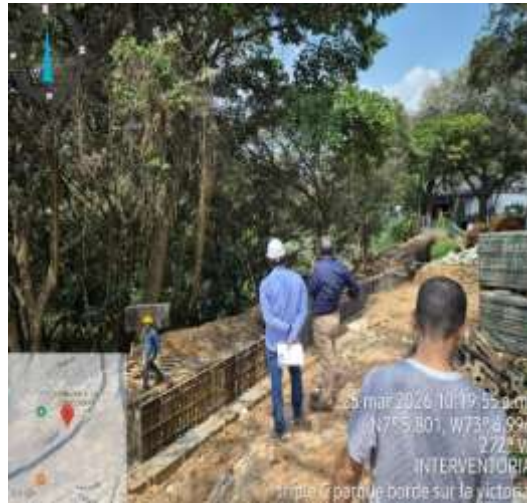
Figurado de acero y encofrado de vastago, tramo 2
