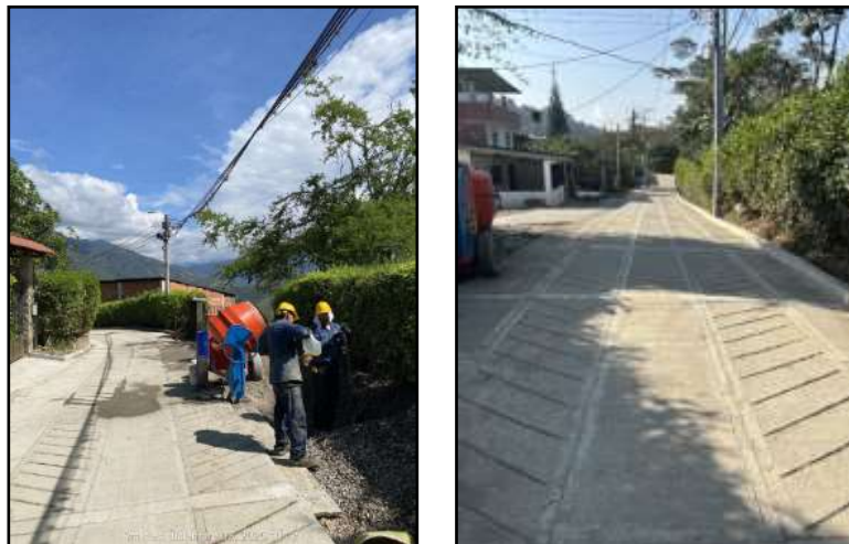
Placa Huella en la Vereda Pedregal
