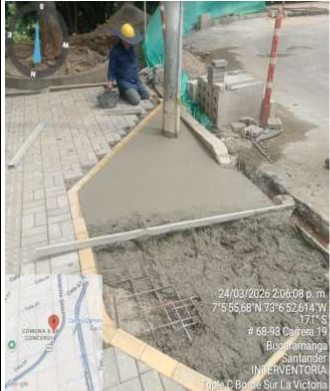
Vaciado concreto vado rampa
