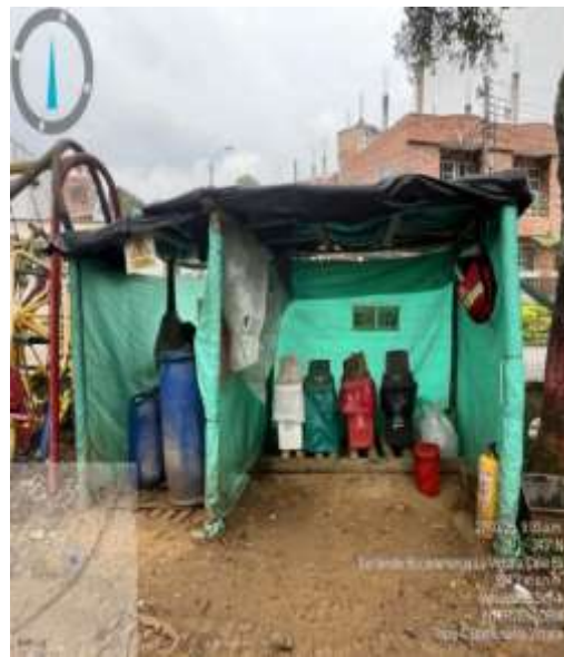
Acopio residuos tramo 2
