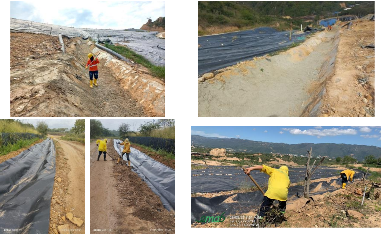
Ilustración 8 Mantenimiento de canales de aguas lluvias, mayo de 2025
