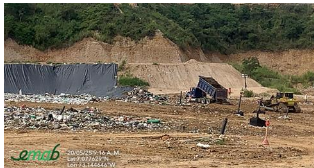
Ilustración 2 Cobertura de residuos sólidos con lona sintética y con material terroso o granular, primer semestre 2025
