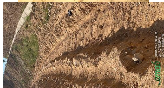
Ilustración 3 Construcción canales para manejo de aguas lluvias y escorrentía, enero de 2025
