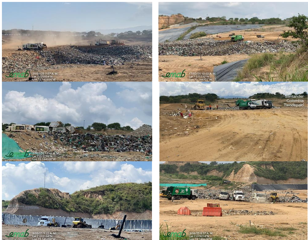
Ilustración 1 Disgregación y compactación de residuos sólidos en la celda actual, primer semestre 2025
