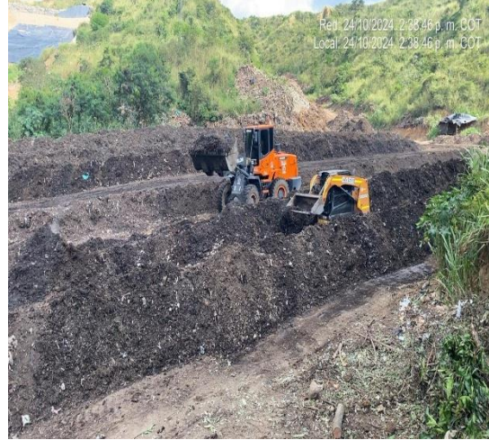
Ilustración 54 Establecimiento de la pila.
