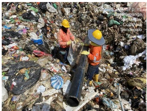
Ilustración 17 Realce y construcción de chimeneas celda actual de disposición.
