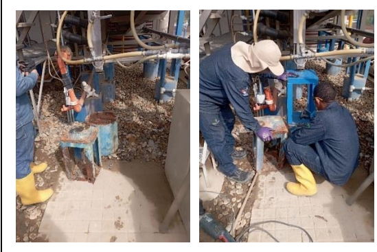
Reemplazo de soportes metálicos del DAF
