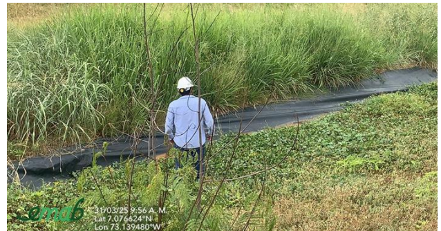
EM4- Canal celda 4 vía malpaso
