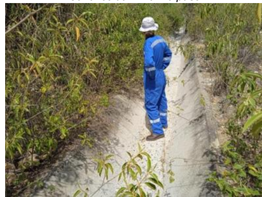
Canal 2 – Zona Sur Etapa 1 parte baja
