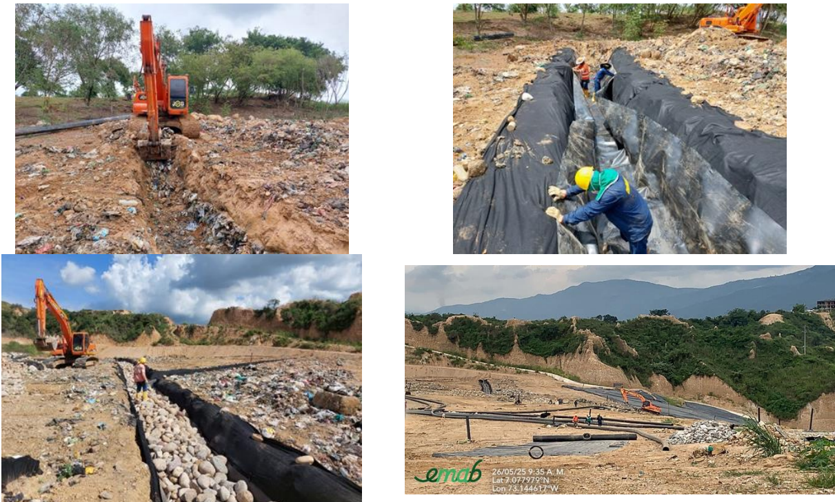
Ilustración 11 Construcción de subdrenes de recolección de lixiviados, mayo 2025
