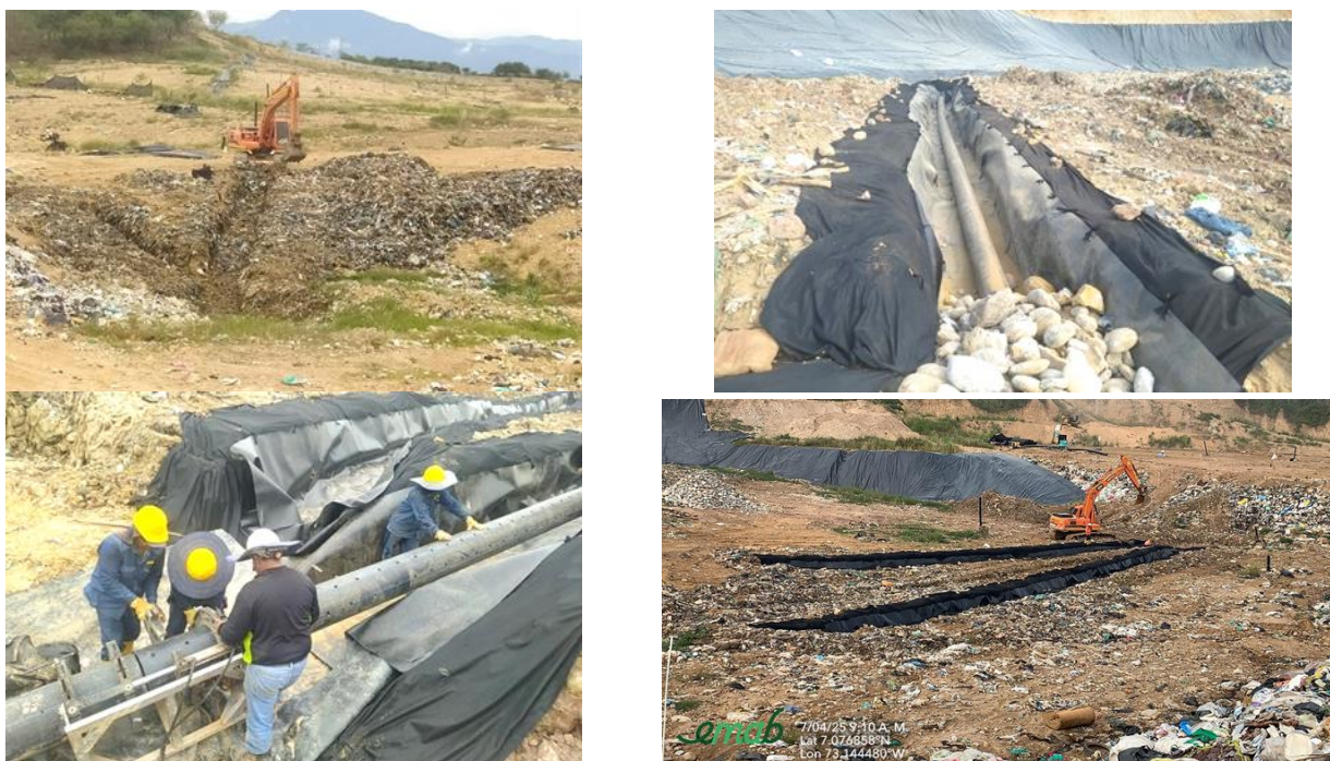
Ilustración 10 Construcción de subdrenes de recolección de lixiviados, abril 2025
