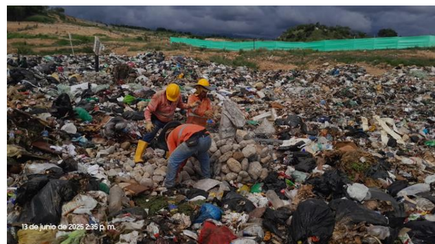
Ilustración 17 Realce y construcción de chimeneas celda actual de disposición.
