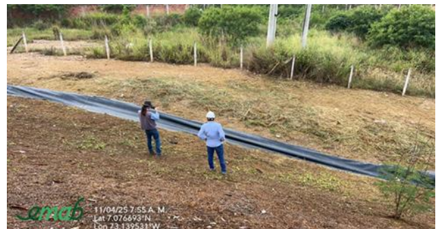
Canal celda 4 vía malpaso
