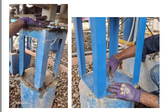
Reemplazo de soportes metálicos del DAF
