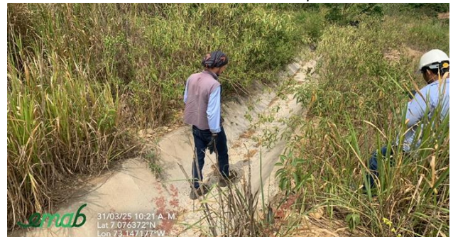
EM8- Canal 2 – Costado sur Etapa 1 parte baja
