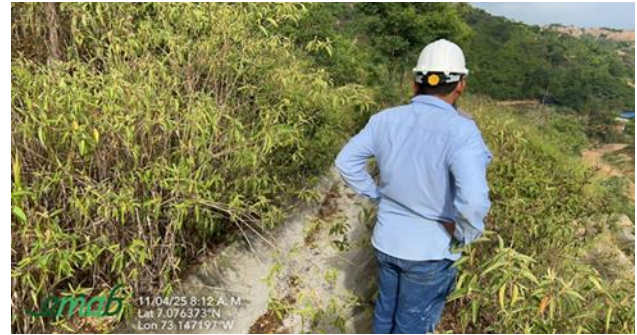
Canal 2 – Zona Sur Etapa 1 parte baja
