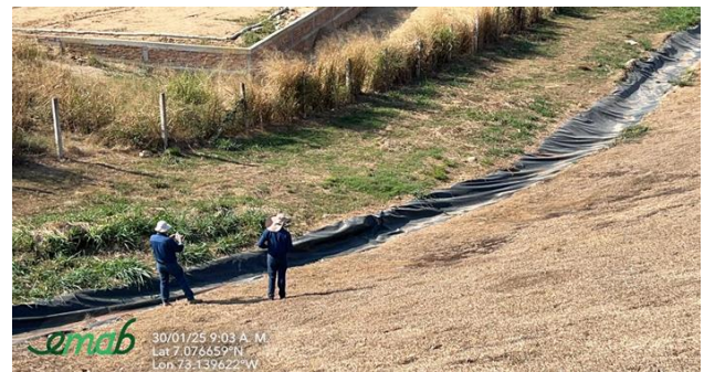
EM4- Canal celda 4 vía malpaso
