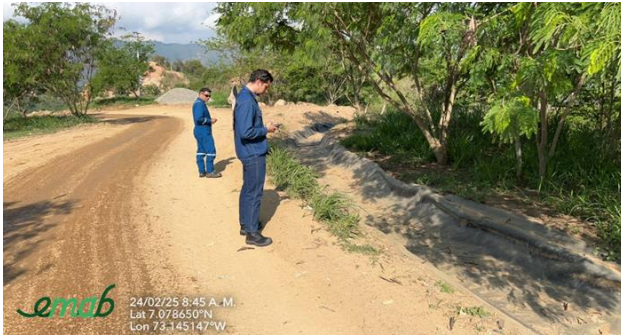
EM5- Canal Celda 1 parte alta
