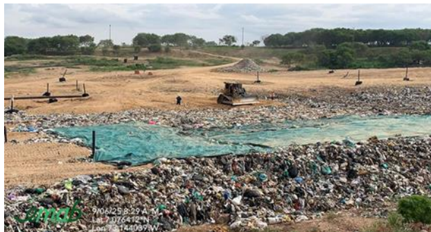
Ilustración 2 Cobertura de residuos sólidos con lona sintética y con material terroso o granular, primer semestre 2025
