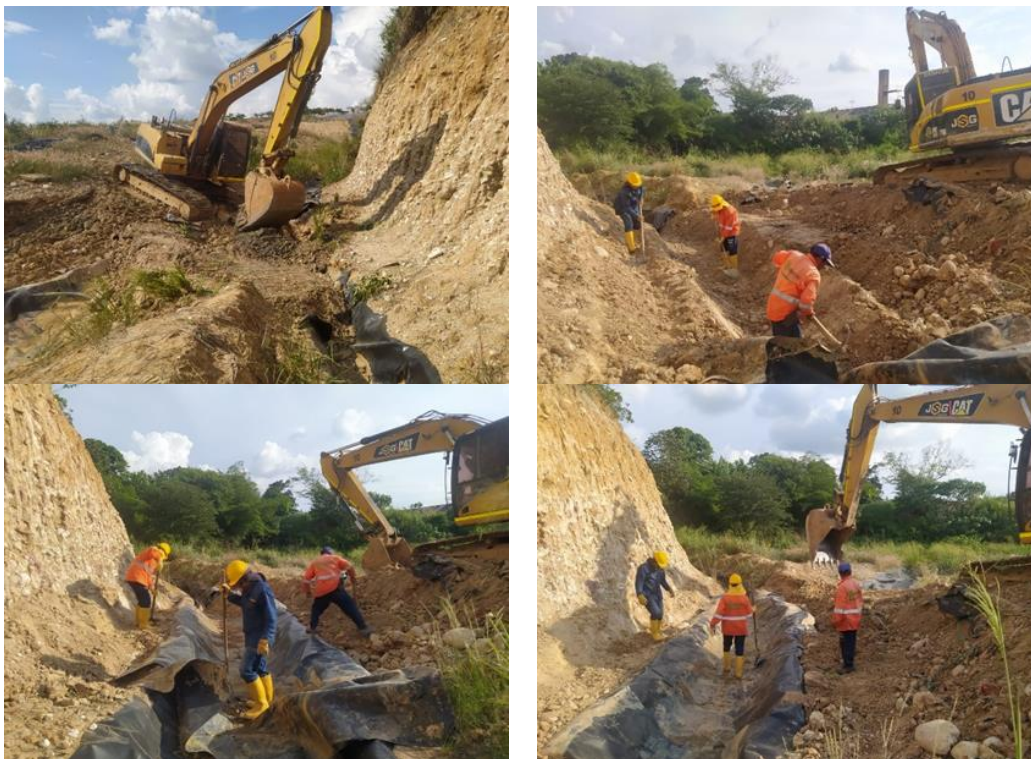
Ilustración 4 Construcción canal de aguas lluvias, marzo de 2025
