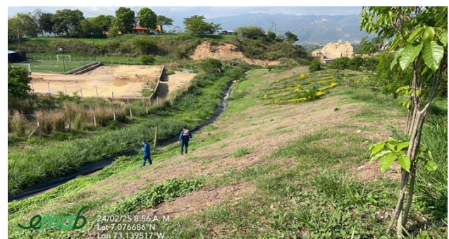
EM4- Canal celda 4 vía malpaso
