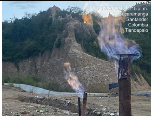
Ilustración 16 Verificación de chimeneas encendidas.
