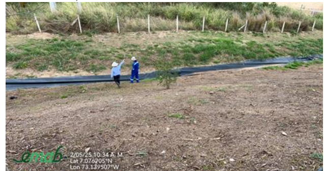
Canal celda 4 vía malpaso
