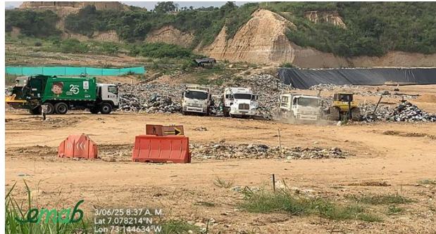
Ilustración Disgregación y compactación de residuos sólidos en la celda actual, primer semestre 2025
