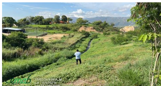
EM4- Canal celda 4 vía malpaso
