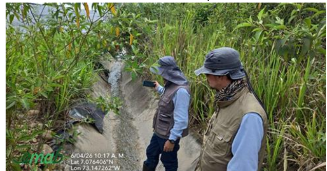
Canal 2 – Zona Sur Etapa 1 parte baja
