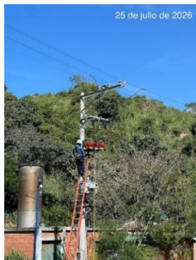
Suministro e instalación PT em transformador 45 kVA
