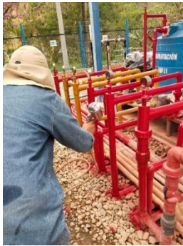
Mantenimiento de tuberías-L2-Recubrimiento con pintura
