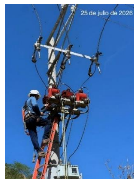
Suministro e instalación PT em transformador 45 kVA
