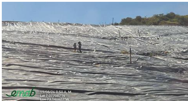
Ilustración 19 Instalación de la geocelda en el talud resultante la subetapa 1G zona Sur y mantenimiento de la geomembrana instalada, agosto de 2026
