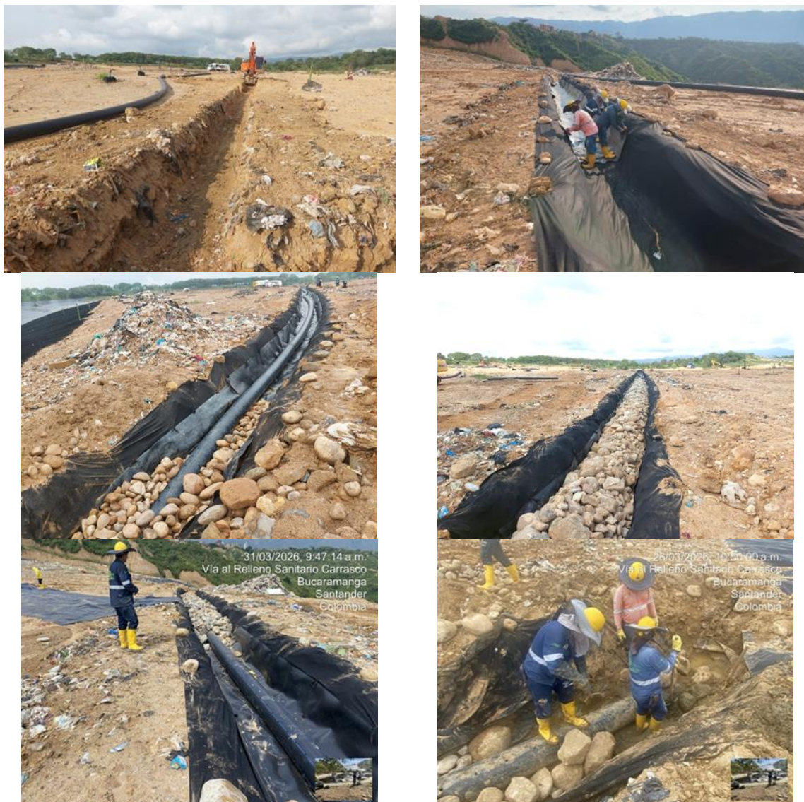
Ilustración 11 Construcción de subdrenes tipo 2, marzo 2026
