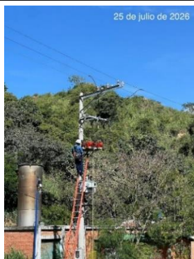
Suministro e instalación PT em transformador 45 kVA
