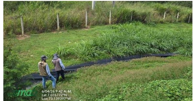
Canal celda 4 vía malpaso
