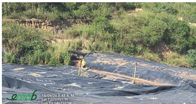
Ilustración 4 Limpieza de los canales de aguas lluvias, enero a septiembre de 2026
