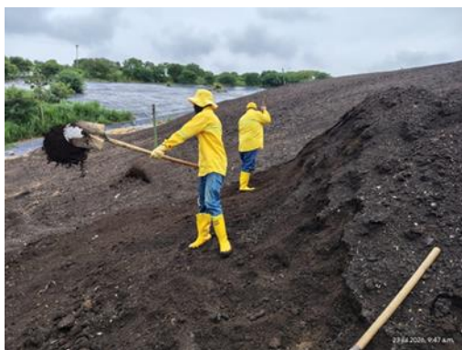
Ilustración 18 Instalación capa de control de la erosión talud resultante subetapa 1G, zona norte, julio de 2026
