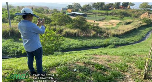
EM4- Canal celda 4 vía malpaso
