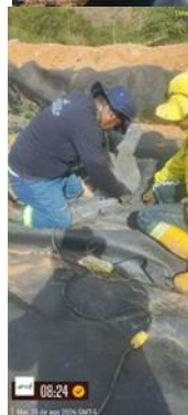
Ilustración 19 Instalación de la geocelda en el talud resultante la subetapa 1G zona Sur y mantenimiento de la geomembrana instalada, agosto de 2026
