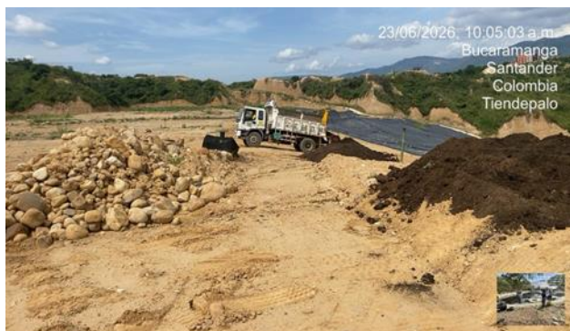
Ilustración 17 Actividades de clausura - Instalación capa de control de compostaje, junio 2026
