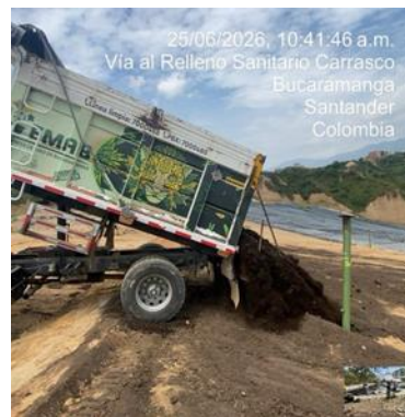
Ilustración 17 Actividades de clausura - Instalación capa de control de compostaje, junio 2026
