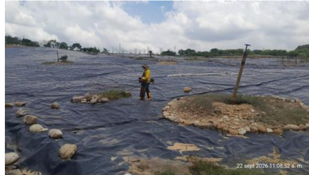
Ilustración 20 Instalación de la geocelda en el talud resultante la subetapa 1G zona Sur y parte alta de la zona norte, e instalación de la capa control de erosión, septiembre de 2026
