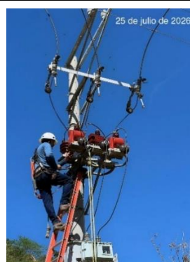
Suministro e instalación PT em transformador 45 kVA
