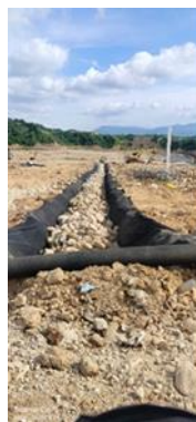
Ilustración 12 Construcción de subdrenes para recolección de lixiviados, abril 2026
