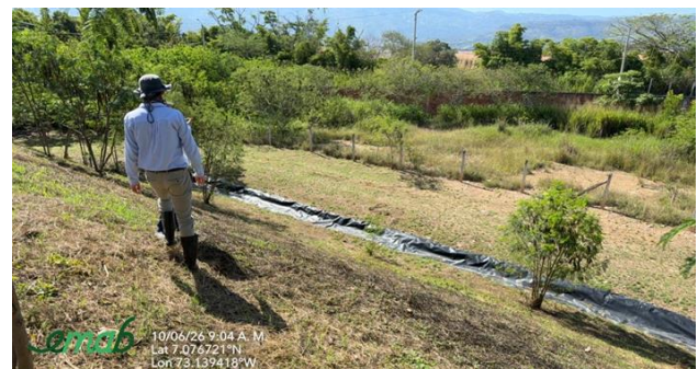
Canal celda 4 vía malpaso
