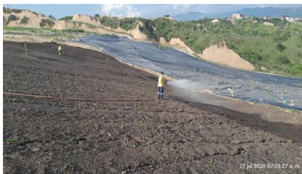
Ilustración 18 Instalación capa de control de la erosión talud resultante subetapa 1G, zona norte, julio de 2026
