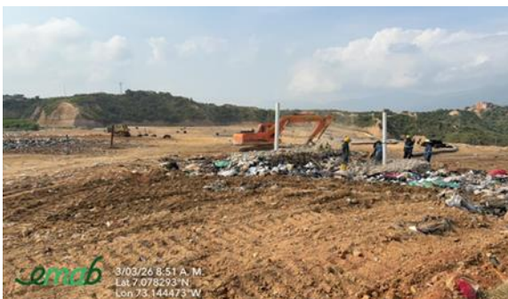
Ilustración 31 Prolongación piezómetro de control PZ3, febrero y marzo 2026
