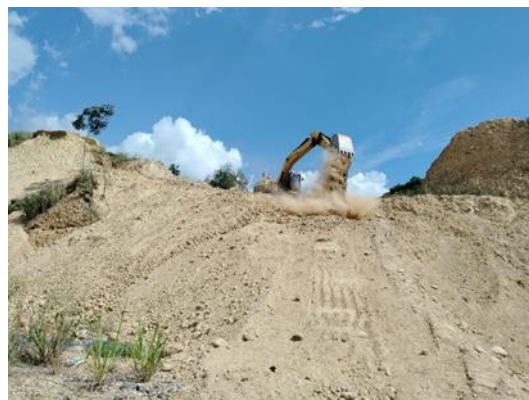
Ilustración 3 Localización, replanteo, corte y conformación de berma del canal de concreto localizado en el costado sur de la celda Etapa 1, junio y agosto de 2026
