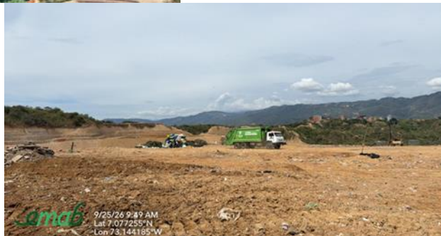
Ilustración 1 Disposición, disgregación y compactación de residuos sólidos en la celda actual, enero a septiembre 2026
