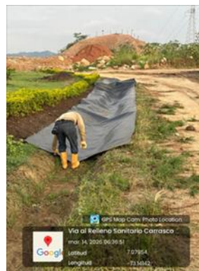
Ilustración 6 Mantenimiento de canales en geomembrana – Celda de Respaldo parte alta, marzo 2026
