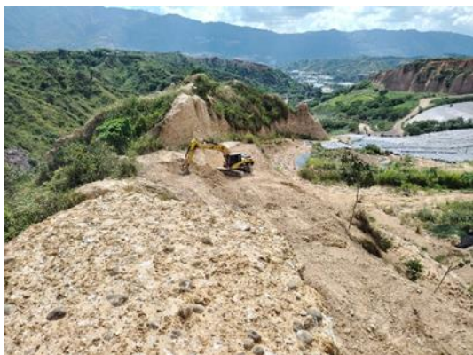
Ilustración 3 Localización, replanteo, corte y conformación de berma del canal de concreto localizado en el costado sur de la celda Etapa 1, junio y agosto de 2026
