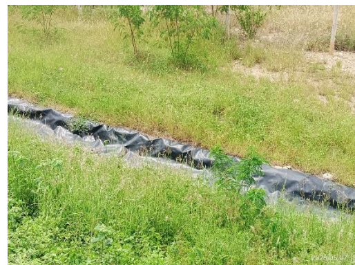
Canal celda 4 vía malpaso
