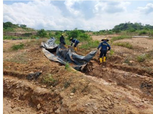
Ilustración 5 Mantenimiento de canales de aguas lluvias, febrero de 2025
