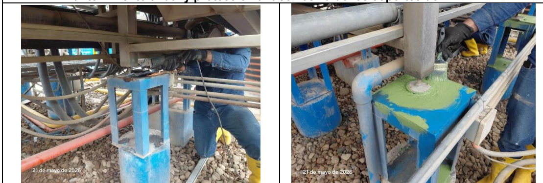
Mantenimiento anual y protección anticorrosiva de los soportes del DAF-L1
