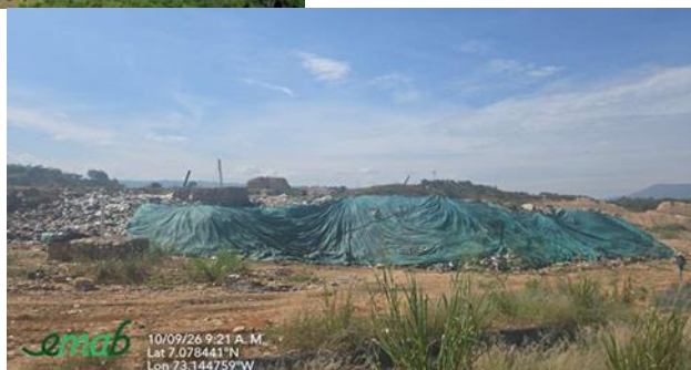
Ilustración 2 Cobertura de residuos sólidos con lona sintética y con material terroso o granular, periodo de enero a septiembre de 2026
