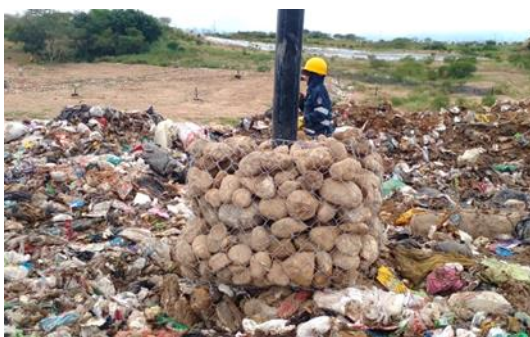
Ilustración 27 Realce y construcción de chimeneas celda actual de disposición e instalación de quemadores, periodo de enero a septiembre 2026
