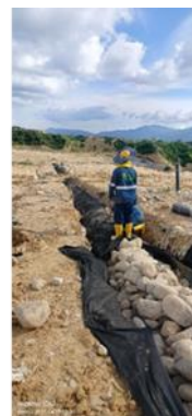
Ilustración 12 Construcción de subdrenes para recolección de lixiviados, abril 2026
