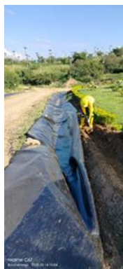
Ilustración 6 Mantenimiento de canales en geomembrana – Celda de Respaldo parte alta, marzo 2026
