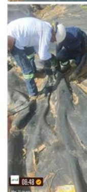
Ilustración 19 Instalación de la geocelda en el talud resultante la subetapa 1G zona Sur y mantenimiento de la geomembrana instalada, agosto de 2026
