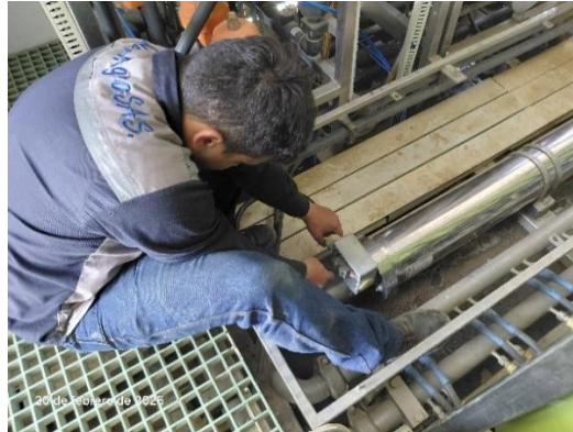
Mantenimiento de tuberías-L2-Recubrimiento con pintura
