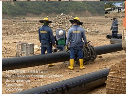
Ilustración 12 Construcción de subdrenes para recolección de lixiviados, abril 2026
