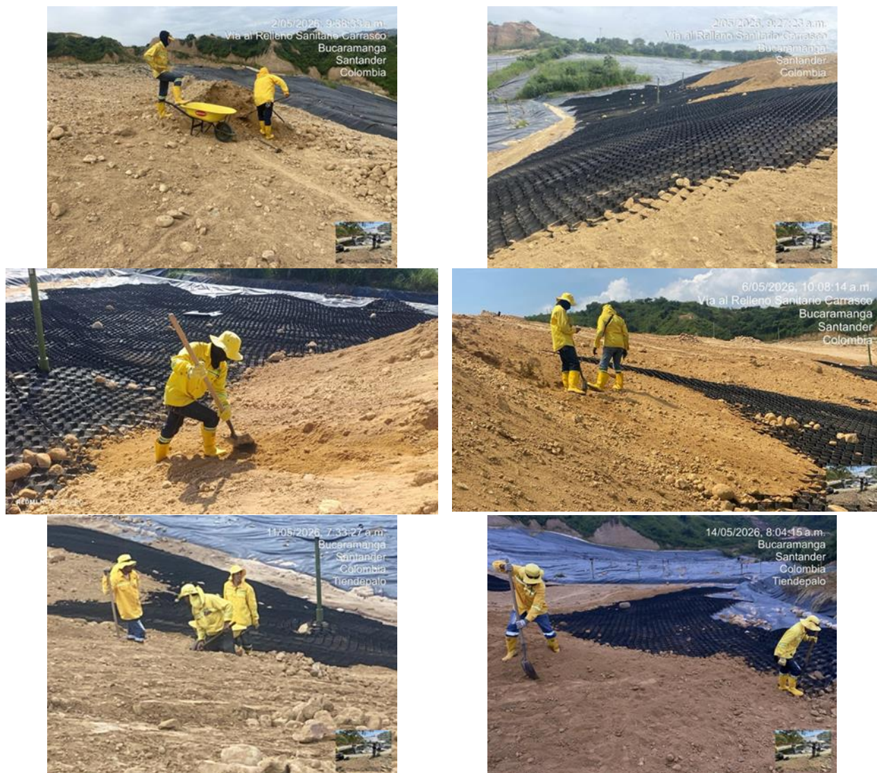
Ilustración 16 Actividades de clausura - Instalación capa de control de la erosión, mayo 2026
