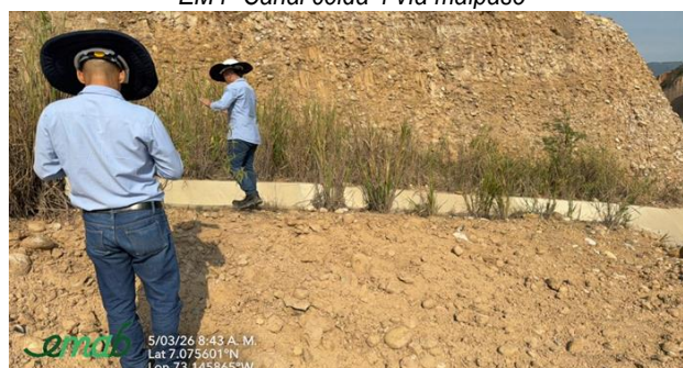
EM8- Canal 2 – Costado sur Etapa 1 parte baja
