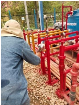
Mantenimiento de tuberías-L2-Recubrimiento con pintura
