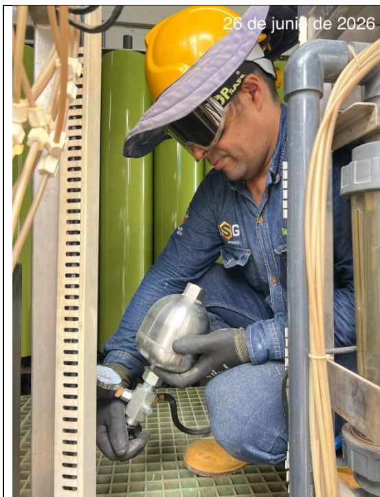
Reemplazo e instalación de bomba dosificadora de ácido de la DTRO
