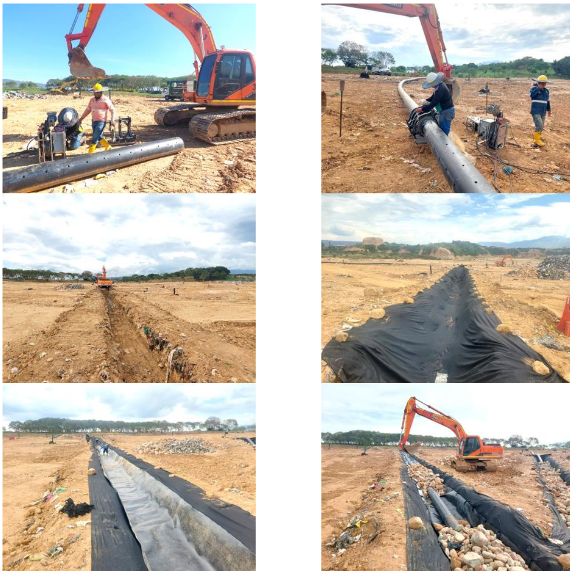
Ilustración 13 Construcción de subdrenes para recolección de lixiviados, junio 2026
