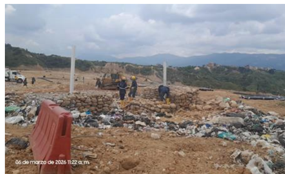
Ilustración 31 Prolongación piezómetro de control PZ3, febrero y marzo 2026
