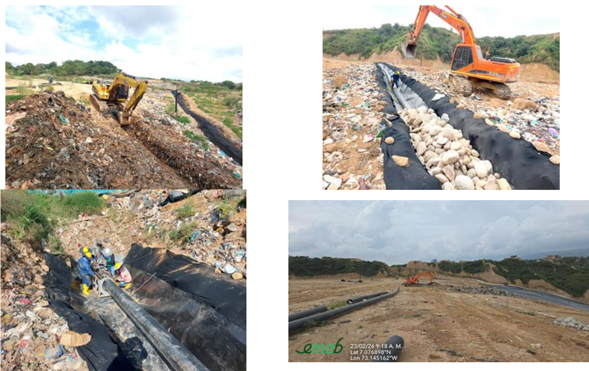
Ilustración 10 Construcción de subdrenes de recolección de lixiviados, febrero 2026
