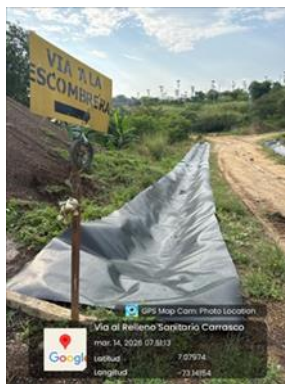
Ilustración 6 Mantenimiento de canales en geomembrana – Celda de Respaldo parte alta, marzo 2026
