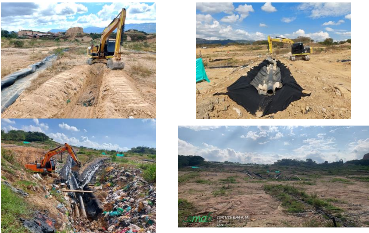
Ilustración 9 Construcción de subdrenes de recolección de lixiviados, enero 2026
