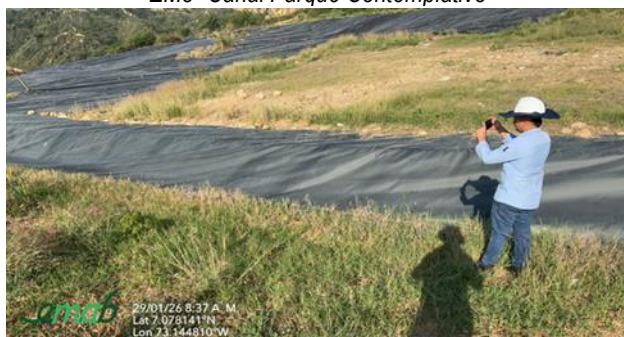
EM5- Canal Celda 1 parte alta
