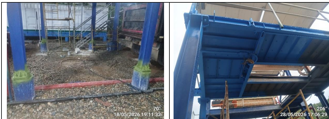
Mantenimiento anual y protección anticorrosiva de los soportes del DAF-L1
