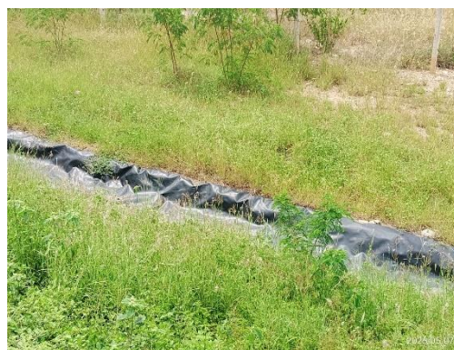
Canal celda 4 vía malpaso
