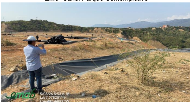
EM7- Canal 1 – Celda de Contingencia
