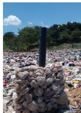
Ilustración. Realce y construcción de chimeneas celda actual de disposición e instalación de quemadores, periodo de enero a junio 2026
