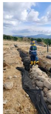
Ilustración. Construcción de subdrenes para recolección de lixiviados, abril 2026
