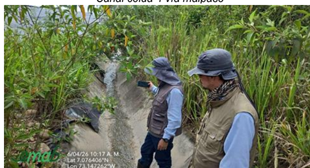
Canal 2 – Zona Sur Etapa 1 parte baja
