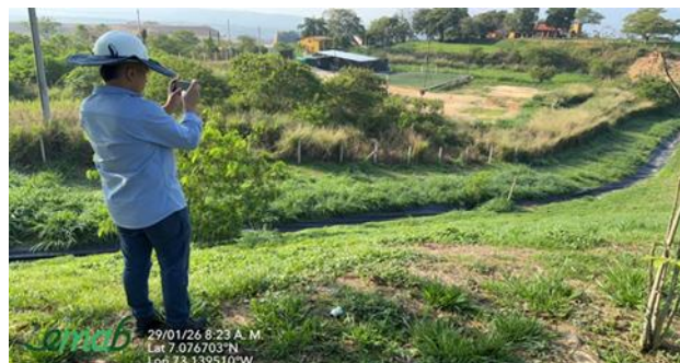
EM4- Canal celda 4 vía malpaso
