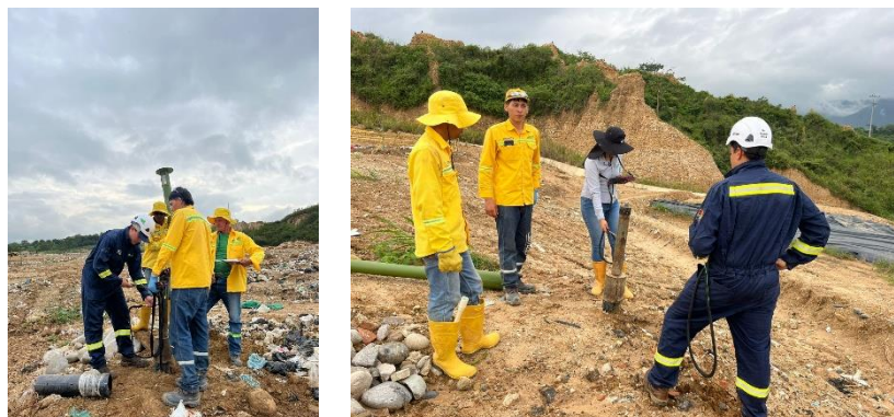
Ilustración. Monitoreo de la composición de biogás y límite de explosividad LEL, marzo 2026
