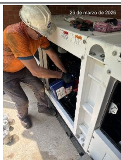
Mantenimiento preventivo grupos electrógenos de 75 kVa y 45kva
