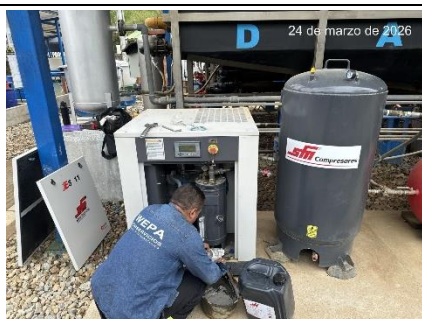
Mantenimiento preventivo compresor de tornillo
