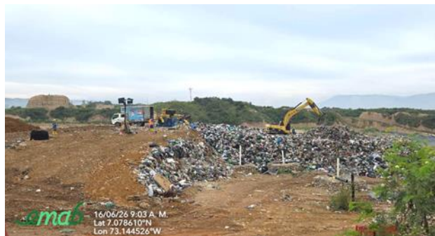
Ilustración. Disposición, disgregación y compactación de residuos sólidos en la celda actual, enero a junio 2026
