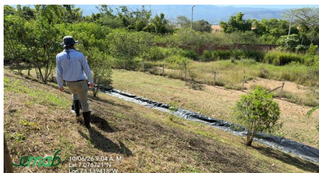
Canal celda 4 vía malpaso
