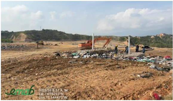
Ilustración. Prolongación piezómetro de control PZ3, febrero y marzo 2026
