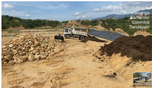
Ilustración. Actividades de clausura - Instalación capa de control de compostaje, junio 2026
