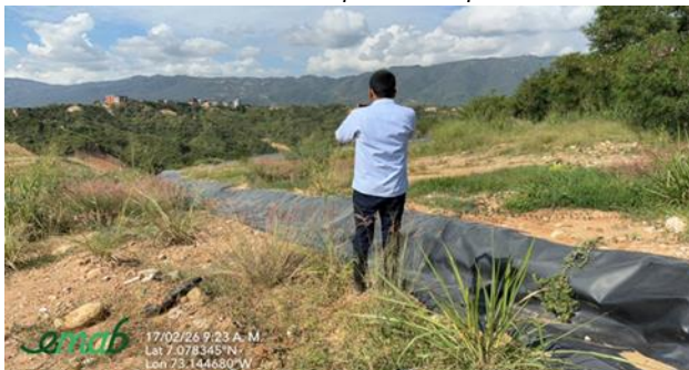
EM5- Canal Celda 1 parte alta
