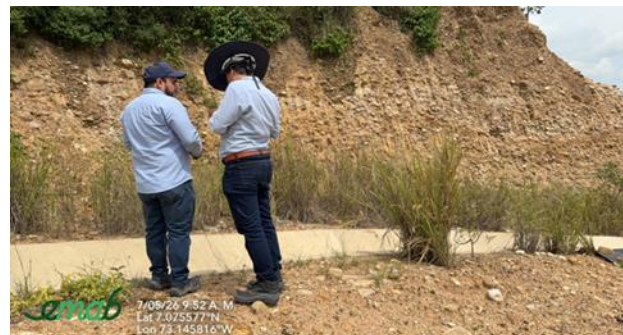
Canal 2 – Zona Sur Etapa 1 parte baja
