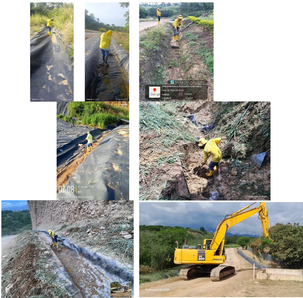
Ilustración. Limpieza de los canales de aguas lluvias, enero a junio de 2026
