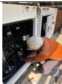
Mantenimiento preventivo grupos electrógenos de 75 kVa y 45kva
