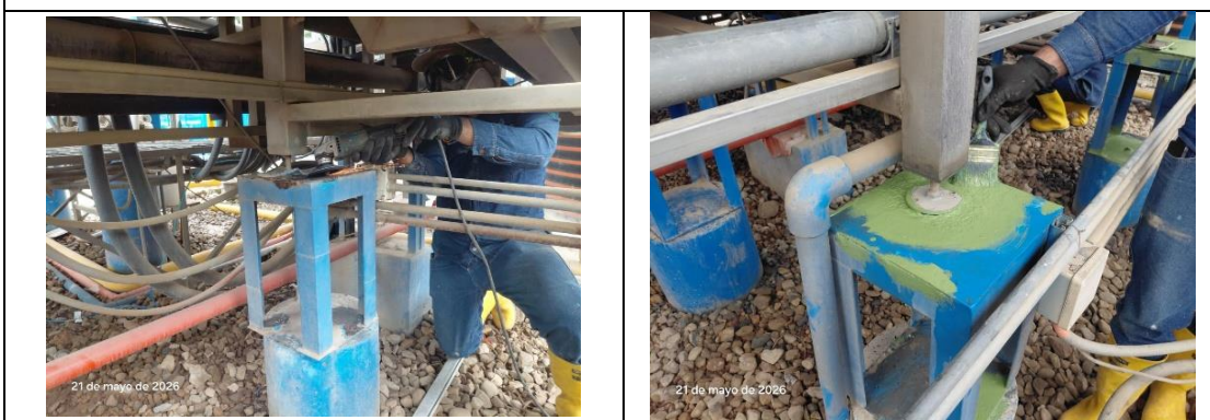
Mantenimiento anual y protección anticorrosiva de los soportes del DAF-L1
