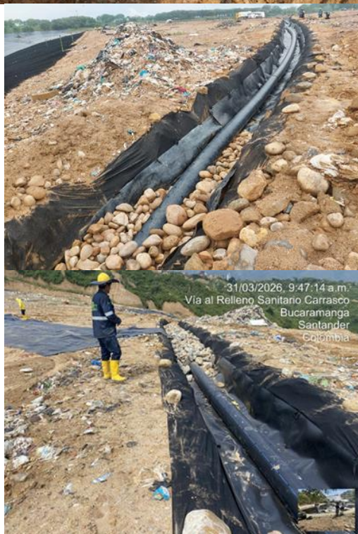
Ilustración. Construcción de subdrenes tipo 2, marzo 2026
