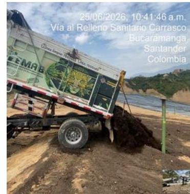
Ilustración. Actividades de clausura - Instalación capa de control de compostaje, junio 2026
