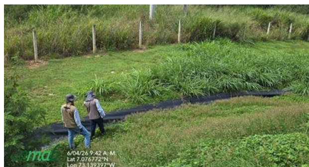
Canal celda 4 vía malpaso
