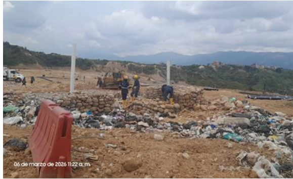
Ilustración. Prolongación piezómetro de control PZ3, febrero y marzo 2026
