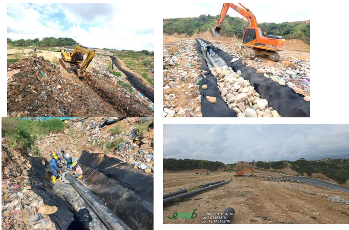
Ilustración. Construcción de subdrenes de recolección de lixiviados, febrero 2026
