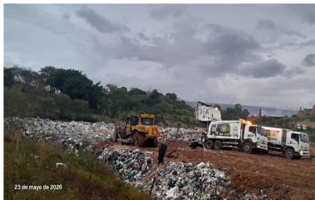
Ilustración. Cobertura de residuos sólidos con lona sintética y con material terroso o granular, periodo de enero a junio de 2026
