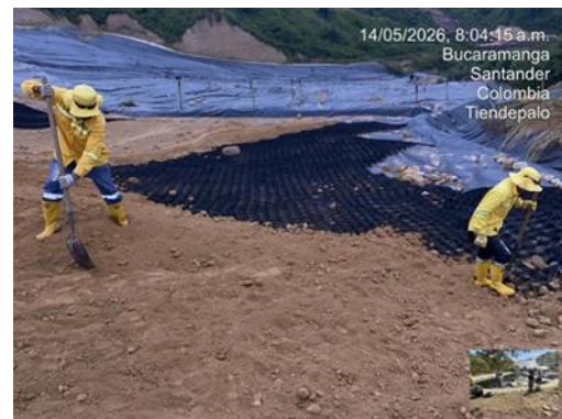
Ilustración. Actividades de clausura - Instalación capa de control de la erosión, mayo 2026
