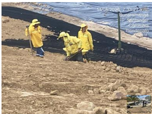
Ilustración. Actividades de clausura - Instalación capa de control de la erosión, mayo 2026
