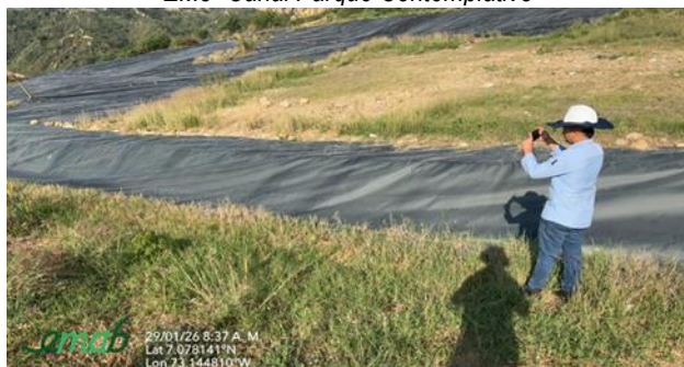
EM5- Canal Celda 1 parte alta
