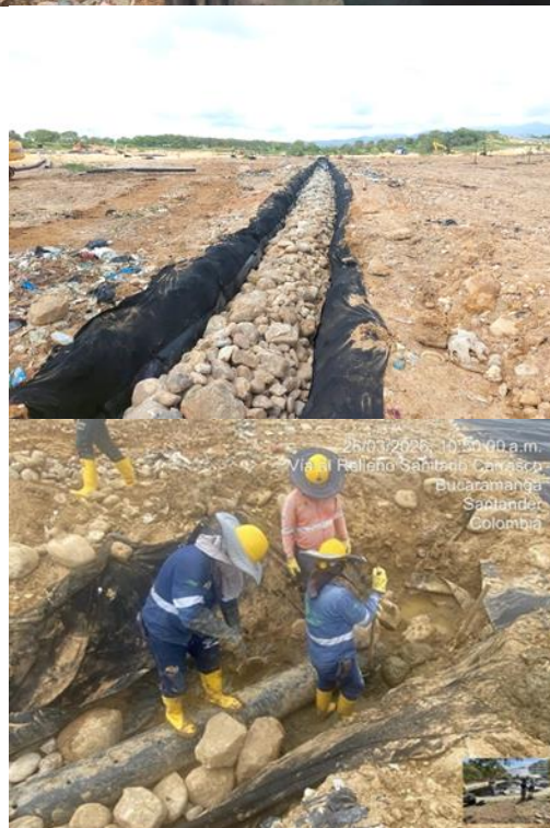
Ilustración. Construcción de subdrenes tipo 2, marzo 2026
