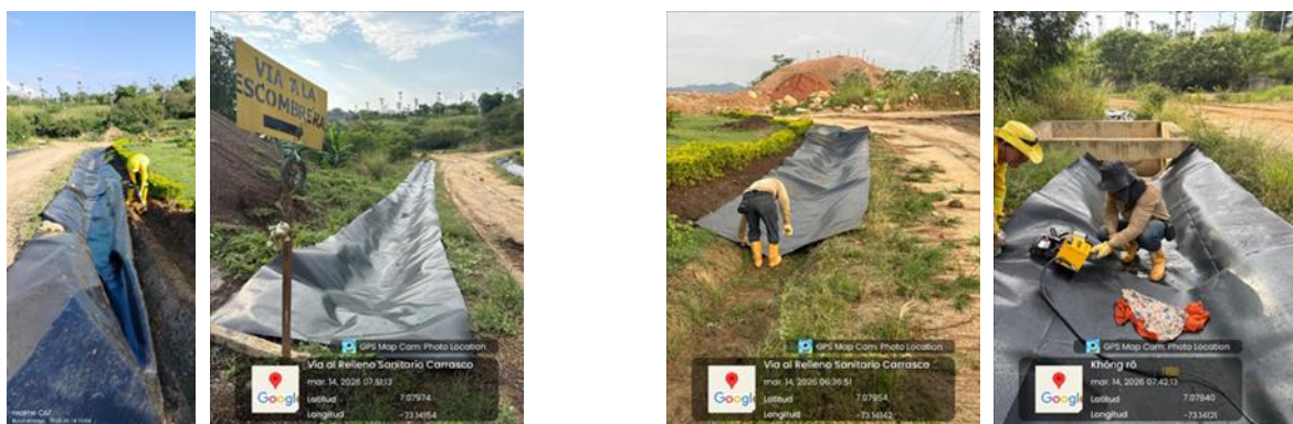
Ilustración. Mantenimiento de canales en geomembrana – Celda de Respaldo parte alta, marzo 2026
