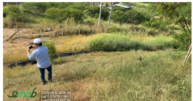
EM4- Canal celda 4 vía malpaso
