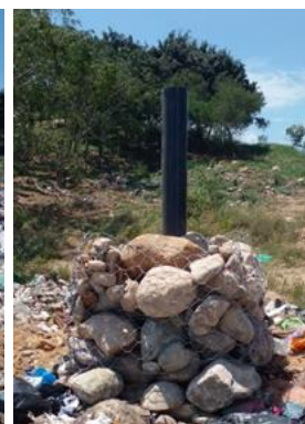
Ilustración. Realce y construcción de chimeneas celda actual de disposición e instalación de quemadores, periodo de enero a junio 2026
