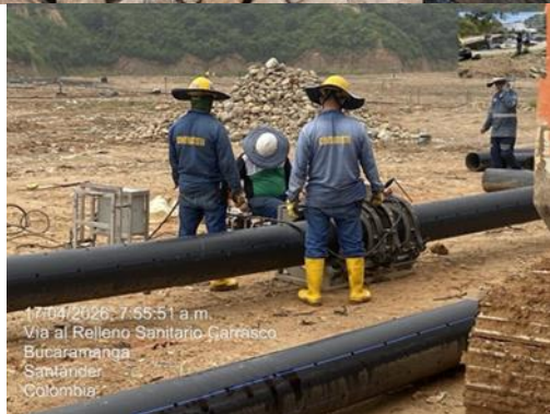
Ilustración. Construcción de subdrenes para recolección de lixiviados, abril 2026
