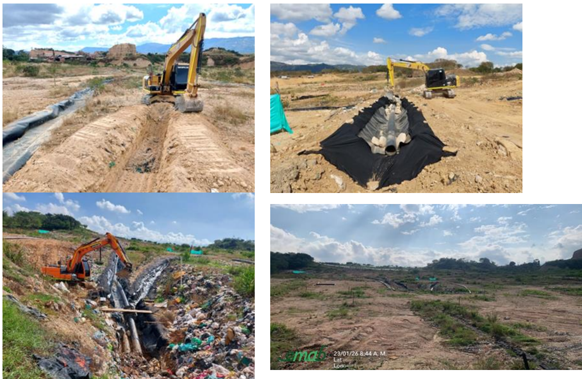
Ilustración. Construcción de subdrenes de recolección de lixiviados, enero 2026
