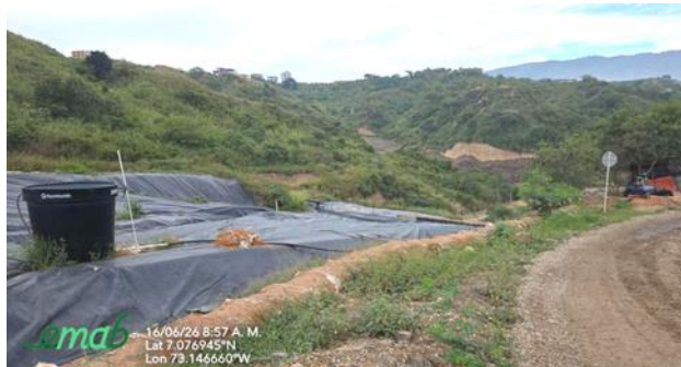
Ilustración. Actividades de extracción forzada de lixiviados, enero a junio de 2026
