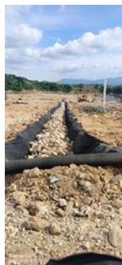
Ilustración. Construcción de subdrenes para recolección de lixiviados, abril 2026
