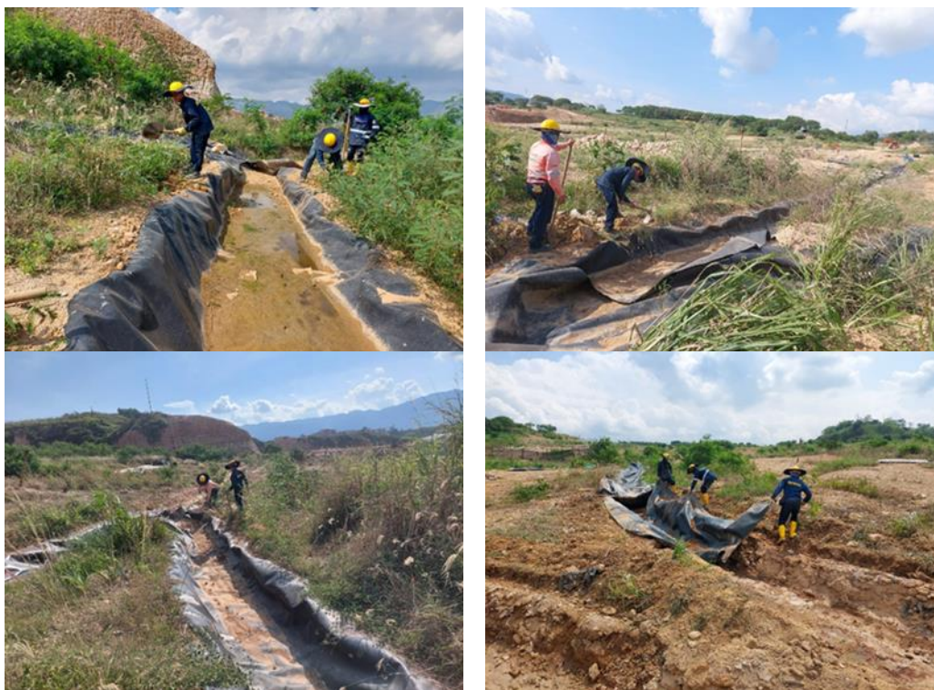
Ilustración. Mantenimiento de canales de aguas lluvias, febrero de 2025
