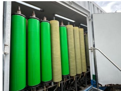
Mantenimiento mayor del sistema DTRO – Sustitución de discos, membranas y vasos de presión
