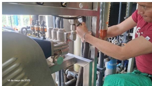
Mantenimiento preventivo de la bomba de pistones de la DTRO
