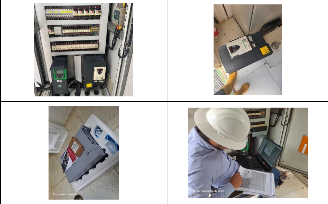
Reactivación de la nueva línea de potencialización de la PTLX
