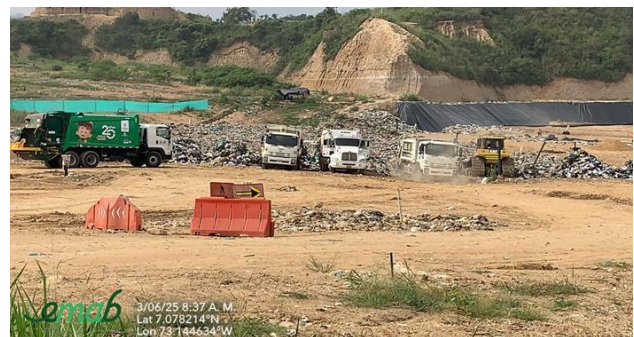
Ilustración Disgregación y compactación de residuos sólidos en la celda actual
