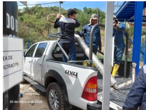
Mantenimiento preventivo de la bomba de alta presión Grundfos – Sistema DTRO
