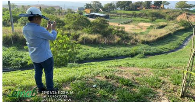
EM4- Canal celda 4 via malpaso
