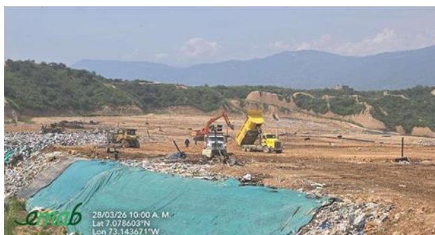
Ilustración 2 Cobertura de residuos sólidos con lona sintética y con material terroso o granular, periodo de enero a marzo de 2026
