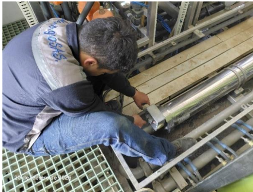
Mantenimiento de tuberías-L2-Recubrimiento con pintura
