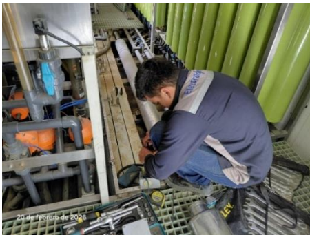
Mantenimiento preventivo de la bomba de alta presión Grundfos – Sistema DTRO
