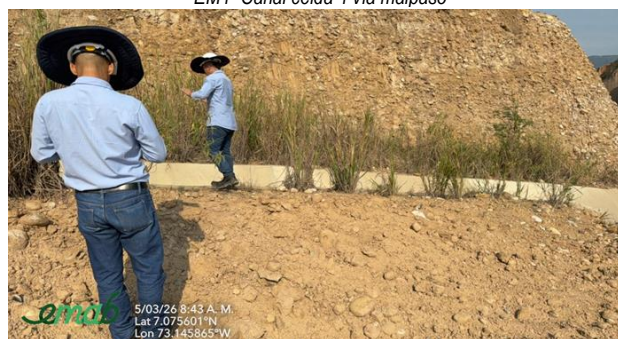
EM8- Canal 2 – Costado sur Etapa 1 parte baja
