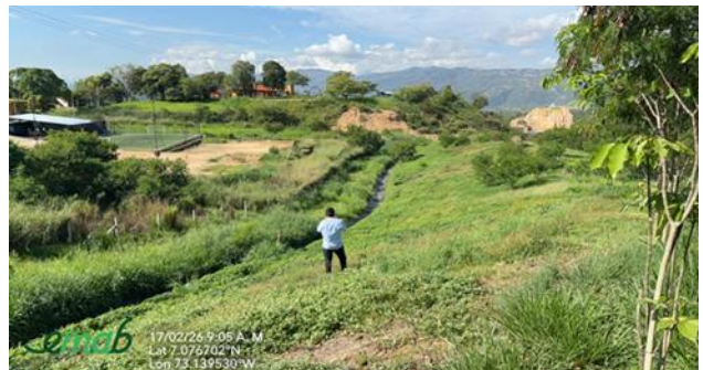
EM4- Canal celda 4 via malpaso
