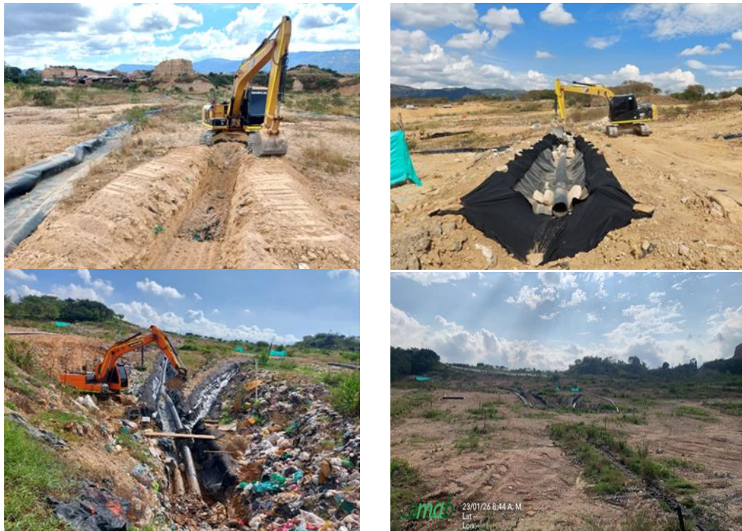
Ilustración 6 Construcción de subdrenés de recolección de lixiviados, enero 2026
