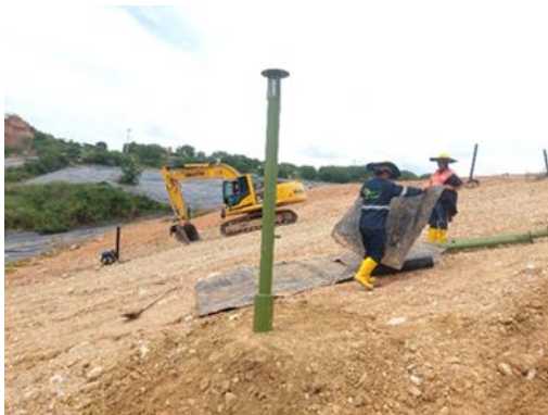
Ilustración 11 Realce y construcción de chimeneas celda actual de disposición e instalación de quemadores, periodo de enero a marzo 2026
