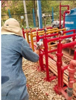
Mantenimiento de tuberías-L2-Recubrimiento con pintura
