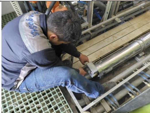
Mantenimiento de tuberías-L2-Recubrimiento con pintura
