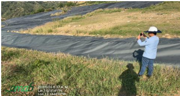
EM5- Canal Celda 1 parte alta
