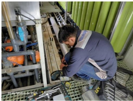
Mantenimiento preventivo de la bomba de alta presión Grundfos – Sistema DTR0
