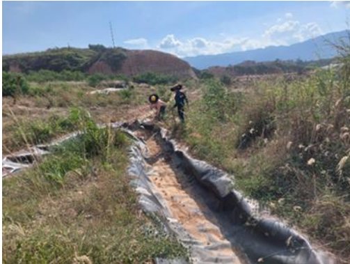
Ilustración 4 Mantenimiento de canales de aguas lluvias, febrero de 2025
