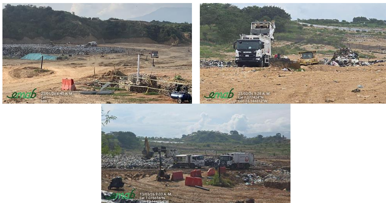
Ilustración 1 Disposición, disgregación y compactación de residuos sólidos en la celda actual, enero a marzo 2026
