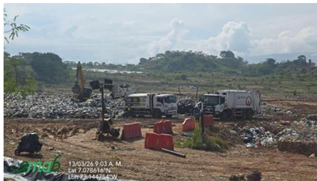
Ilustración Disposición, disgregación y compactación de residuos sólidos en la celda actual, enero a marzo 2026
