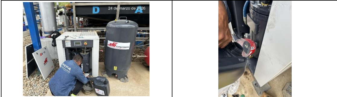
Mantenimiento preventivo compresor de tornillo
