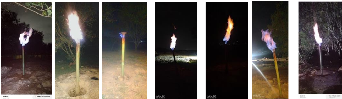
Ilustración 12 Verificación de chimeneas encendidas, enero a marzo 2026
