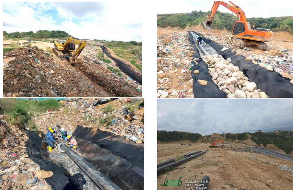
Ilustración 7 Construcción de subdrenes de recolección de lixiviados, febrero 2026
