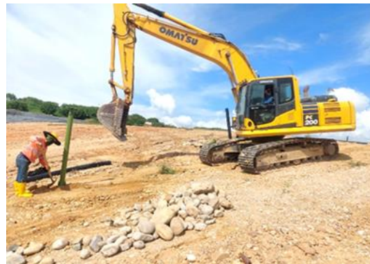
Ilustración 11 Realce y construcción de chimeneas celda actual de disposición e instalación de quemadores, periodo de enero a marzo 2026
