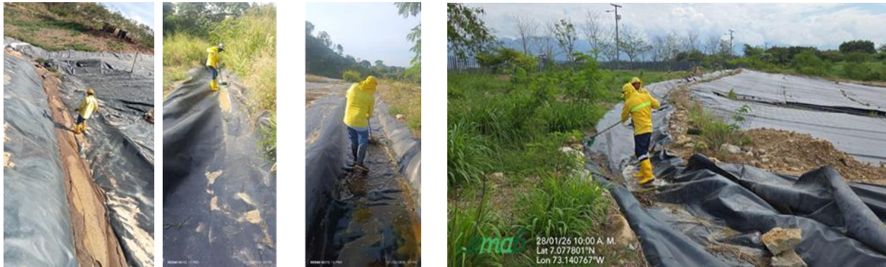
Ilustración 3 Limpieza de los canales de aguas lluvias, enero a marzo de 2026
