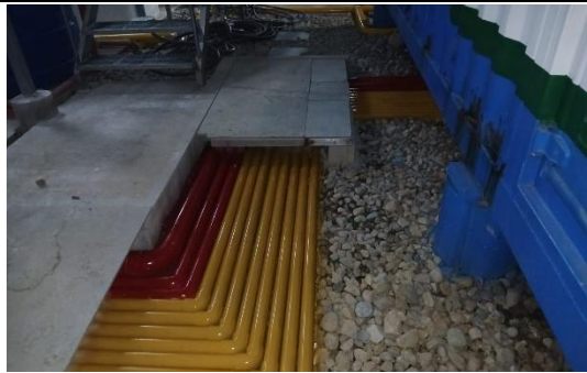
Mantenimiento de tuberías-L2-Recubrimiento con pintura
