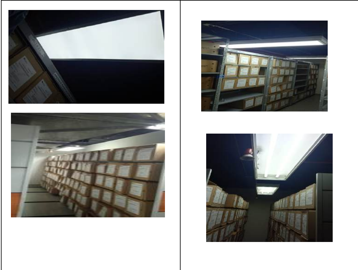
Imagen 2. Cambio de luminarias
