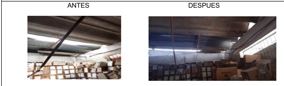
Imagen 8. Arreglo del techo del depósito
