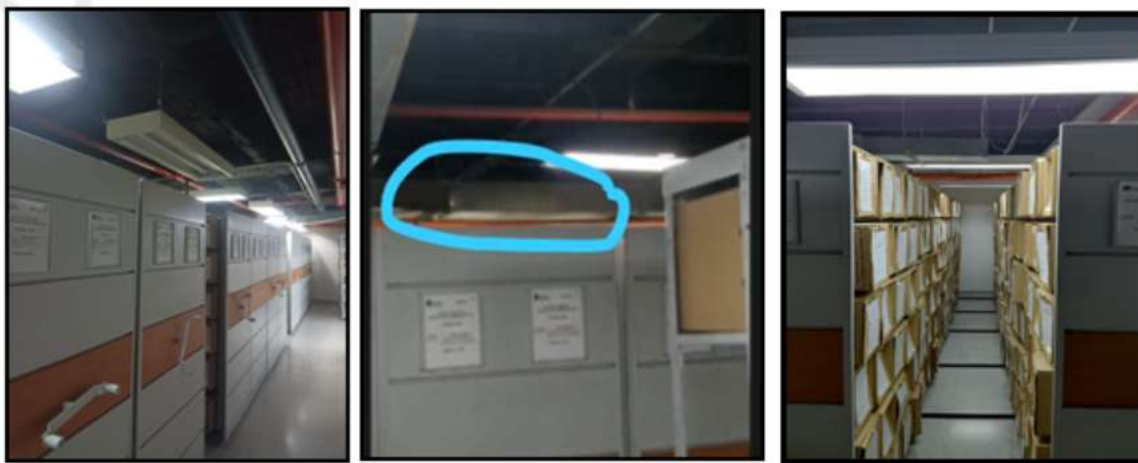
Imagen 8. Cambio de luminaria
