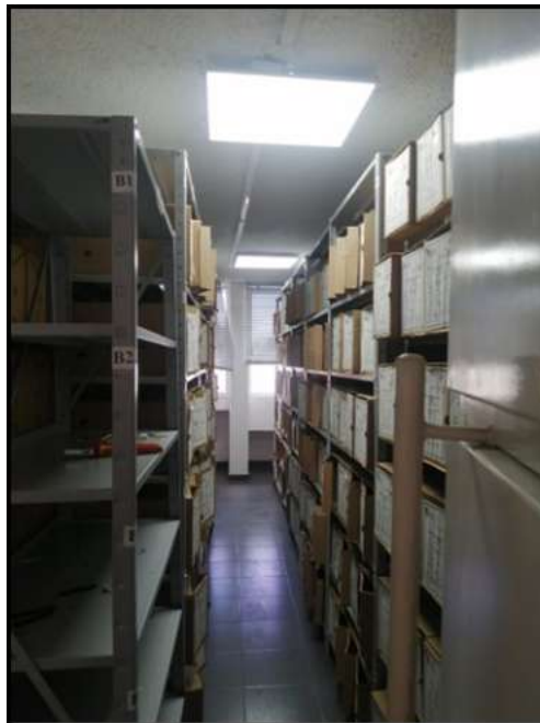
Imagen 6 Cambio de iluminarias
