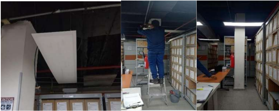
Imagen 7. Cambio de luminaria
