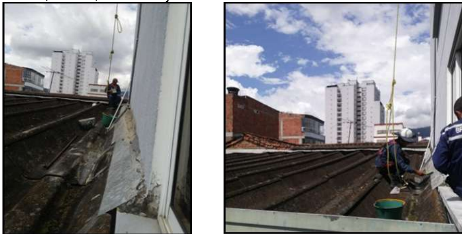
Imagen 10. Limpieza de techo
