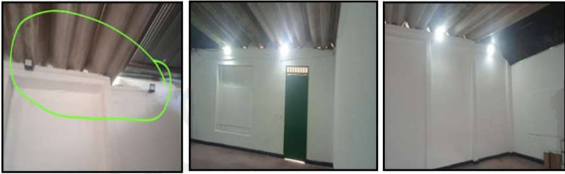
Imagen 5 Instalación reflectores Led
