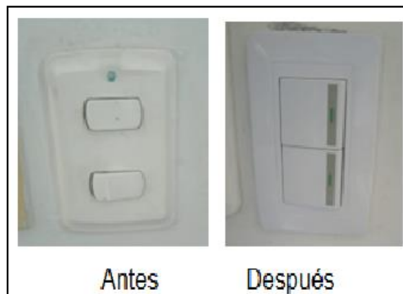
Imagen 3. Cambio de apagador de luz
