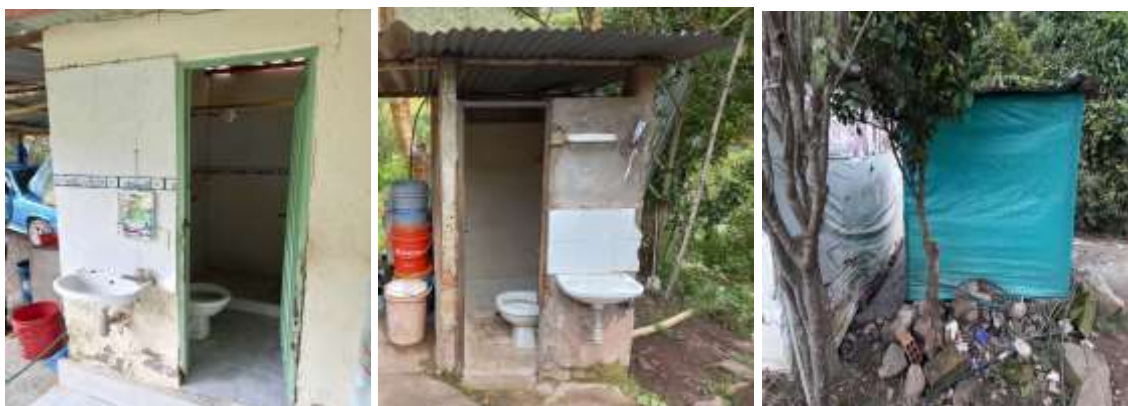
CONDICIONES DE LAS UNIDADES SANITARIA ANTES DE LA INTERVENCIÓN
