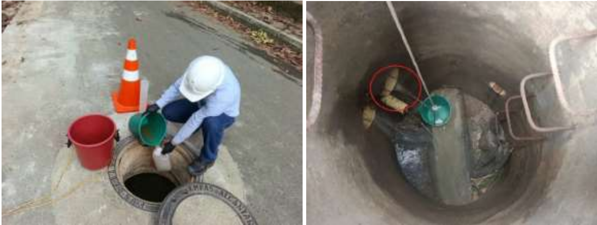
ACTIVIDADES DE VERIFICACIÓN DEL SISTEMA DE ALCANTARILLADO DEL BARRIO EL CRISTAL, MUNICIPIO DE BUCARAMANGA
