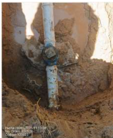
CAMBIO DE VÁLVULAS VEREDA RUITOQUE-PANORAMA
