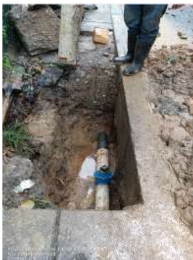
CAMBIO DE VÁLVULAS LA TRANSICIÓN-GIRARDOT
