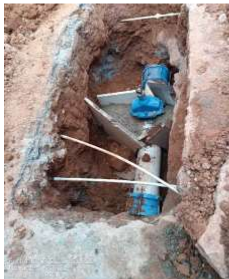
CAMBIO DE VÁLVULAS VEREDA RUITOQUE-PANORAMA
