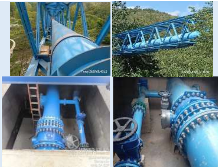
Instalación de tubería de acero - Torqueo de accesorios bridados en cámaras k0+770 y k1+878
