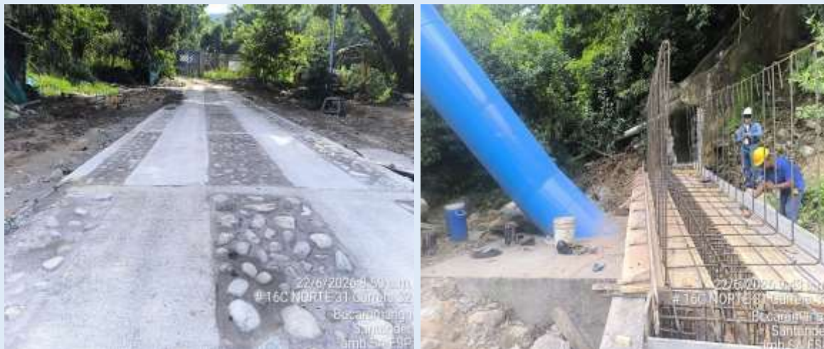
Obras de reposición en áreas intervenidas Placa de protección en Guásimo y canal de aguas lluvias en areneros
