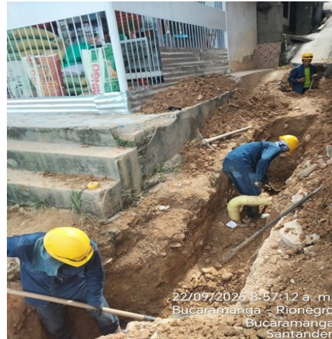
ACTIVIDADES DE EXCAVACIONES E INSTALACIÓN DE TUBERÍAS DE ALCANTARILLADO Y ACUEDUCTO.
