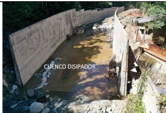
AVANCE MUROS ANCLADOS MARGEN IZQUIERDA Y MARGEN DERECHA
