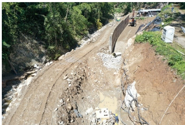
OBRAS CAPTACIÓN Y DESARENADOR PTAP FLORIDABLANCA
