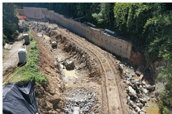
AVANCE MUROS CANTILEVER Y RELLENOS COMPACTADOS ESTRUCTURA DESARENADOR
