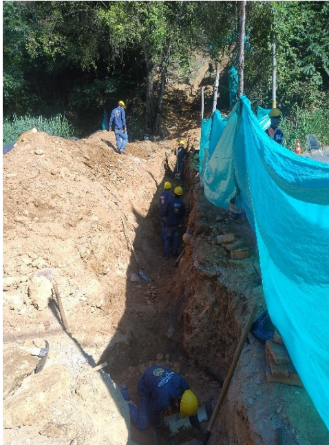
FIGURA 9. SEGUIMIENTO AVANCE DE OBRA - CONSTRUCCIÓN DE LAS REDES DE ALCANTARILLADO DEL BARRIO EL CRISTAL
