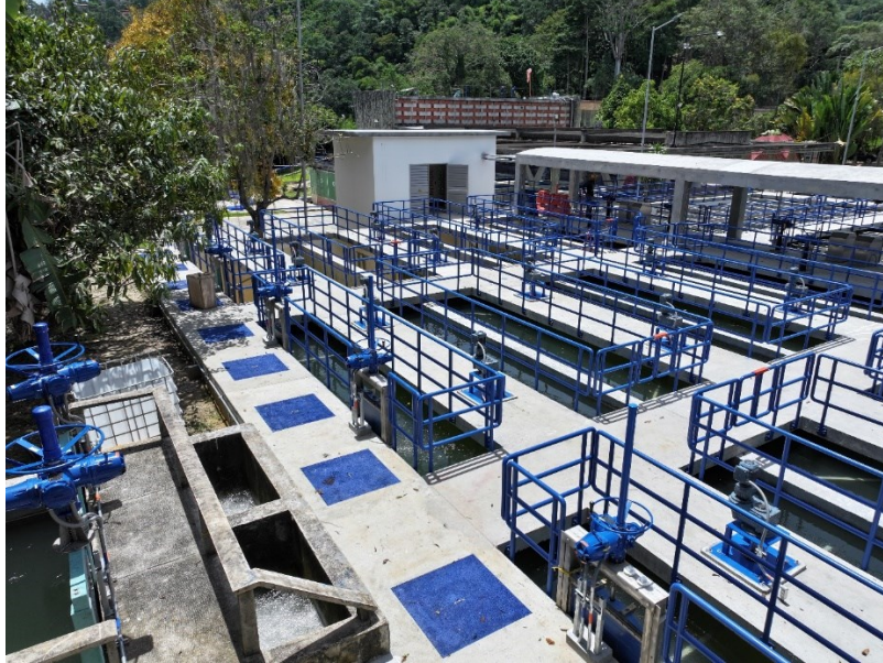
Optimización planta de tratamiento LA FLORA. Puesta en Marcha
