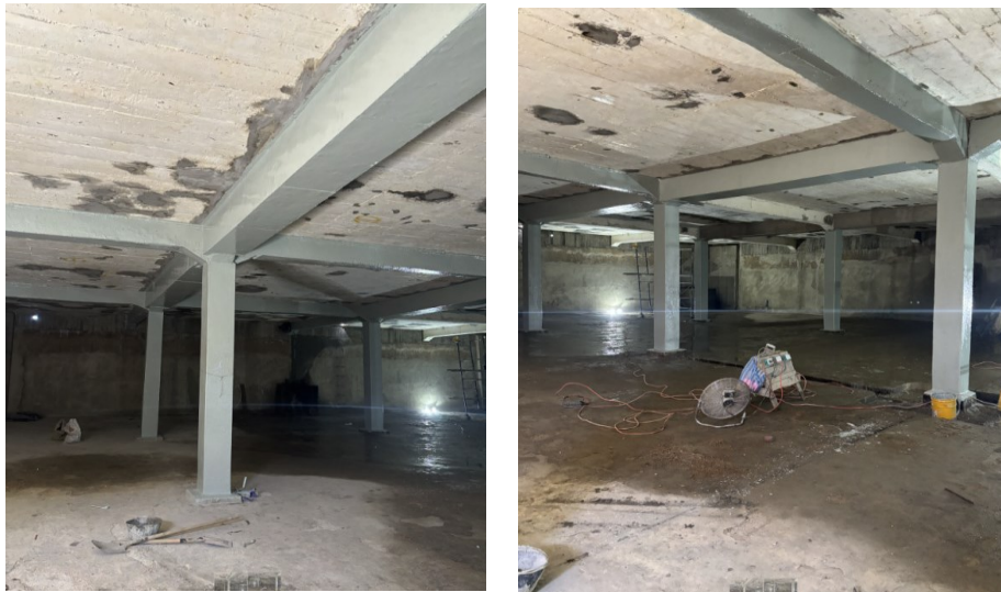
REGISTRO FOTOGRÁFICO RECUBRIMIENTO DE VIGAS LONGITUDINALES EXISTENTES TANQUE #1 MORRO ALTO.
