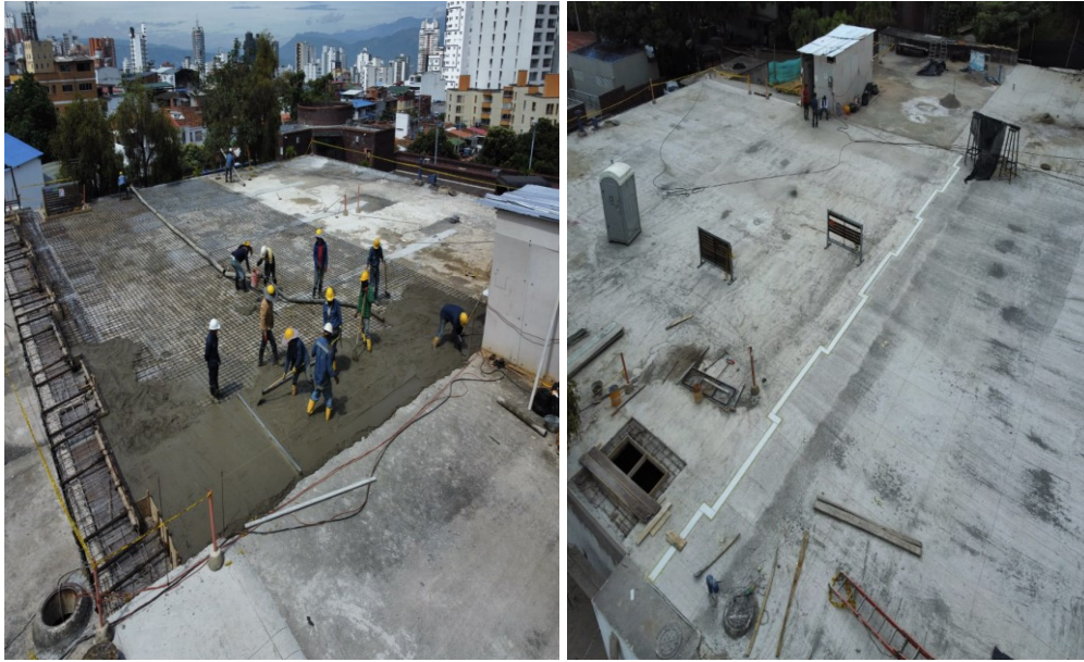
REGISTRO FOTOGRÁFICO REALCE LOSA SUPERIOR TANQUE #1 MORRO ALTO
