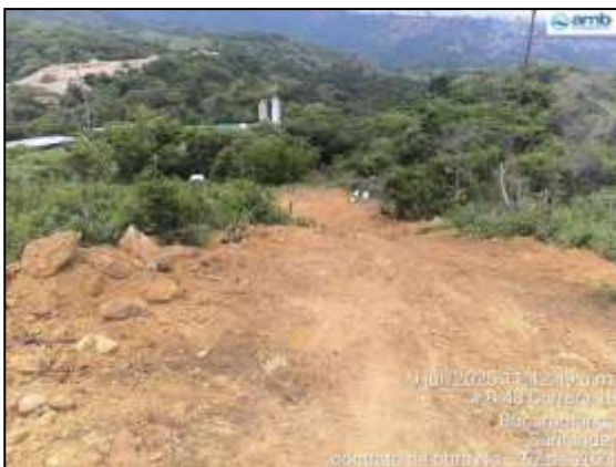
Rellenos de tubería PEAD 355mm y 450mm realizados.
