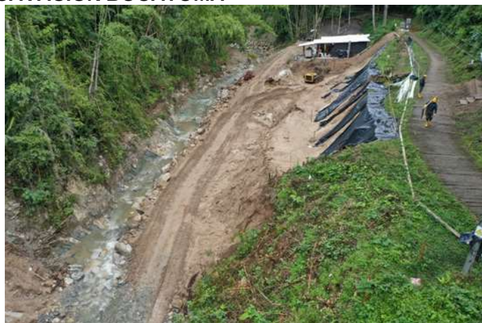
AVANCE EXCAVACIONES DESARENADOR
