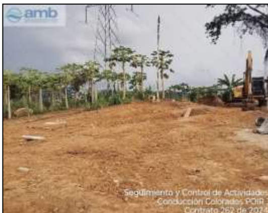
Rellenos de tubería PEAD 355mm y 450mm realizados.
