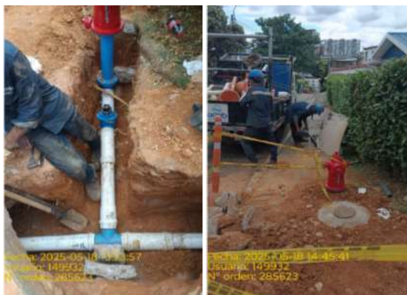
Figura 29. Reposición de redes en el Barrio Los Rosales. Carrera 11B con calle 20
