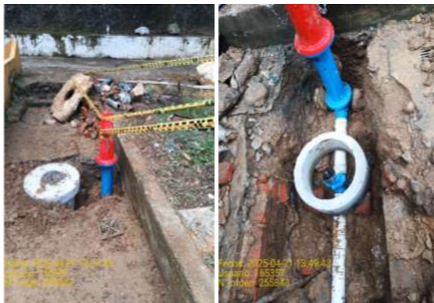
Figura 30. Reposición de redes en el barrio Zapamanga VI. Calle 126 N° 33-33
