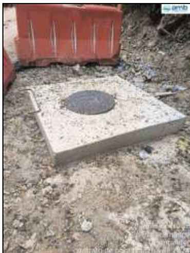
Cámara de ventosa terminada, tubería PEAD instalada e isométrico de cámara de llegada instalado
