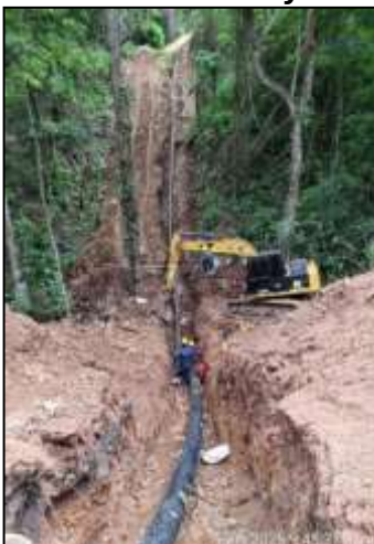
Cámara de ventosa terminada, tubería PEAD instalada e isométrico de cámara de llegada instalado
