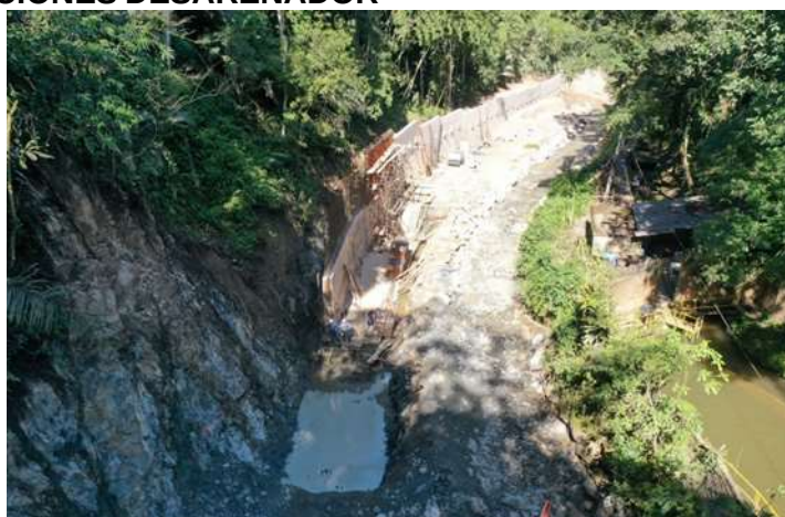
AVANCE BOCATOMA Y MURO IZQUIERDO
