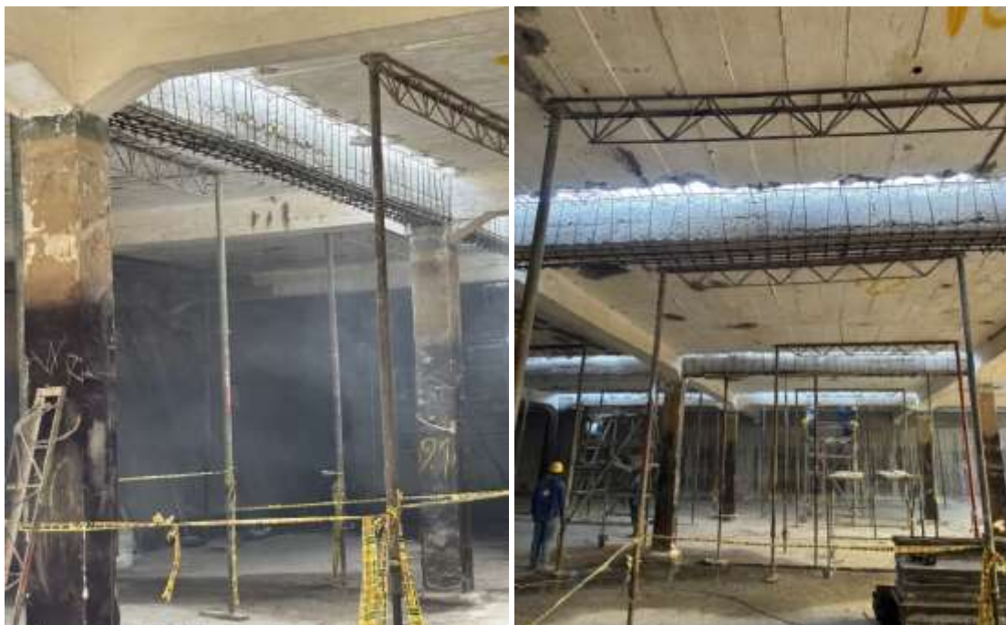
Figura 32. Registro fotográfico reforzamiento de vigas longitudinales existentes Tanque N°1 Morro Alto.
