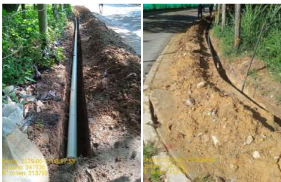
Figura 27. Reposición de redes en el Barrio García Rovira. Carrera 12 entre calles 42 y 43
