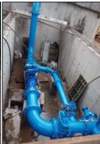
Cámara de ventosa terminada, tubería PEAD instalada e isométrico de cámara de llegada instalado
