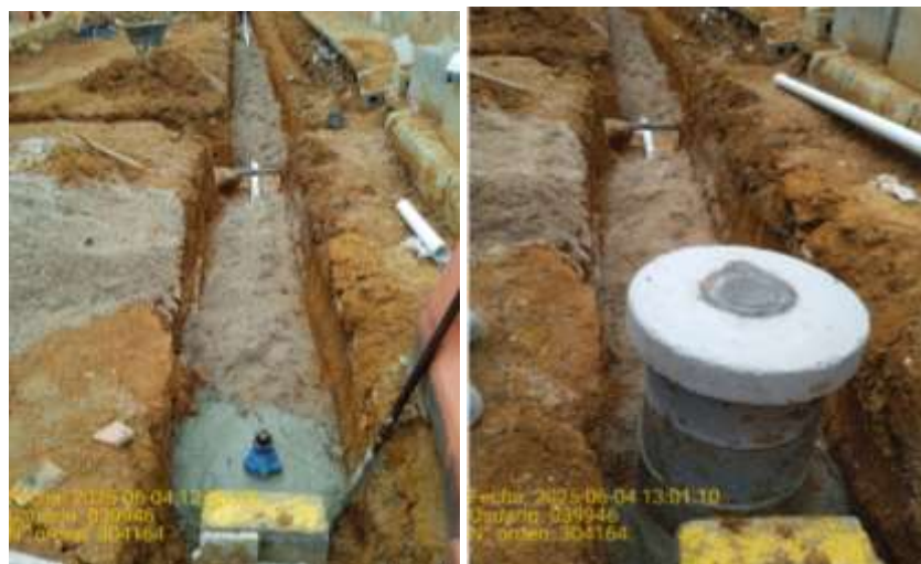
Figura 27. Reposición de redes en el Barrio García Rovira. Carrera 12 entre calles 42 y 43
