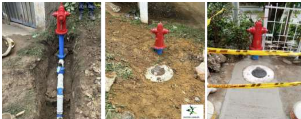
Figura 31. Registro fotográfico Instalación de hidrantes en los municipios de Bucaramanga, Floridablanca y Girón.
