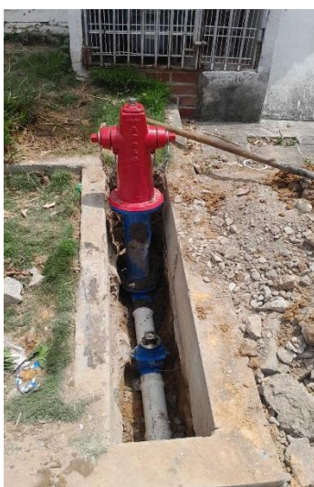
KM 1 VÍA AL MAR 9 -21 FUNDACIÓN ALBEIRO VARGAS Y BARRIO ALARES CALLE 53 CON CARRERA 13 – ACTIVIDADES DE INSTALACIÓN DE HIDRANTE.
