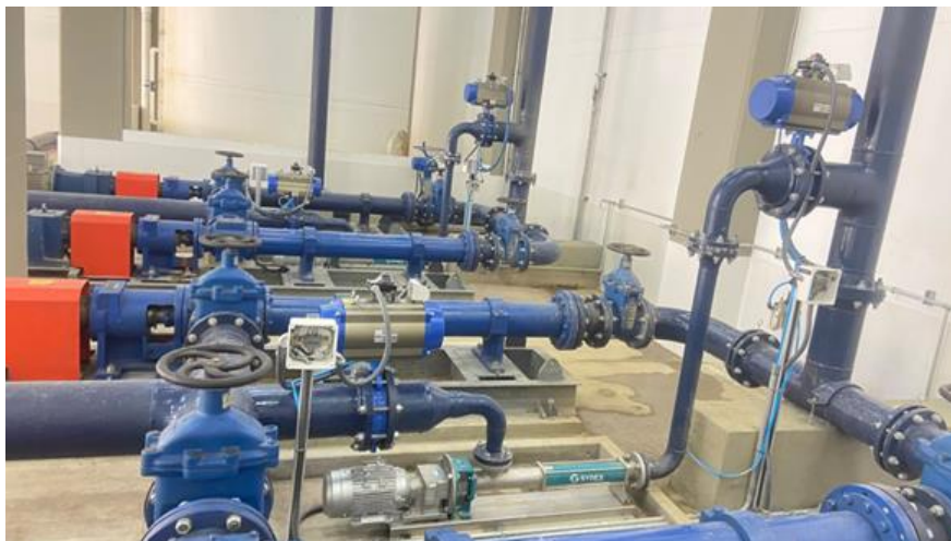
REFORZAMIENTO SISTEMA PTL
