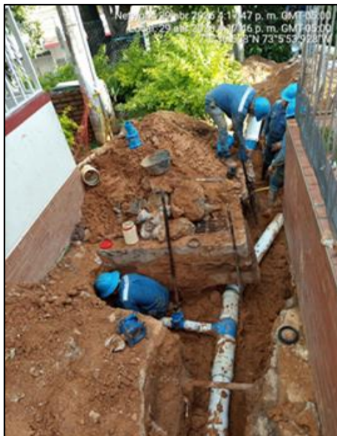
Instalación tuberías de acueducto
