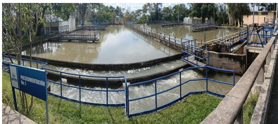
INSTALACIÓN SISTEMAS DE SEGURIDAD PLANTAS
