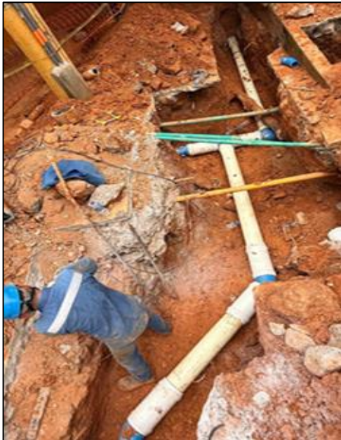
Instalación tuberías de acueducto
