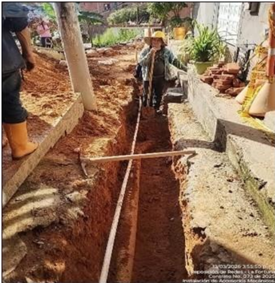
Instalación tuberías de acueducto y alcantarillado
