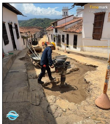
Reconstrucción de pavimentos en piedra bolo.
