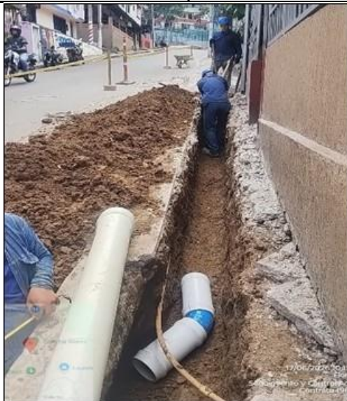
Instalación tuberías de acueducto y Reconstrucción de escaleras y andenes.
