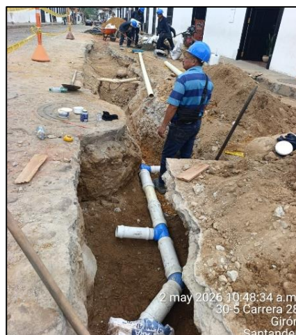
Instalación tuberías de acueducto.
