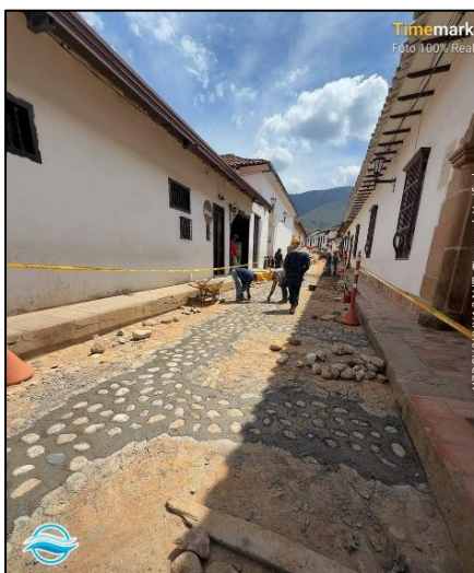
Reconstrucción de pavimentos en piedra bolo.
