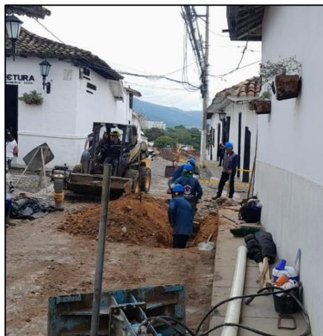
Instalación tuberías de acueducto.
