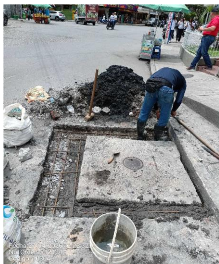
RECONSTRUCCIÓN DE PLACA PARA VÁLVULA. CARRERA 15 # 105-04 B. MALPASO – GIRÓN
