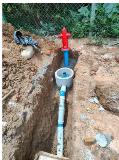
KM 1 VÍA AL MAR 9 -21 FUNDACIÓN ALBEIRO VARGAS Y BARRIO ALARES CALLE 53 CON CARRERA 13 – ACTIVIDADES DE INSTALACIÓN DE HIDRANTE.
