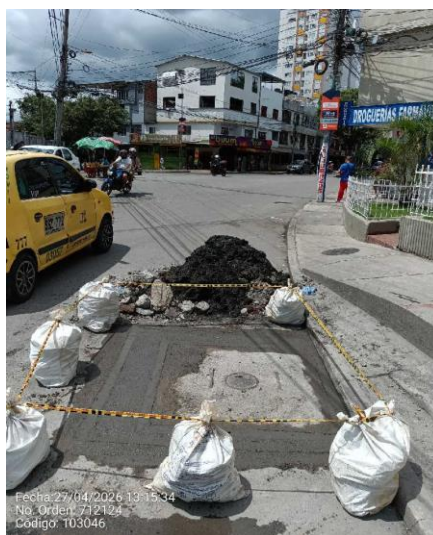
RECONSTRUCCIÓN DE PLACA PARA VÁLVULA. CARRERA 15 # 105-04 B. MALPASO – GIRÓN
