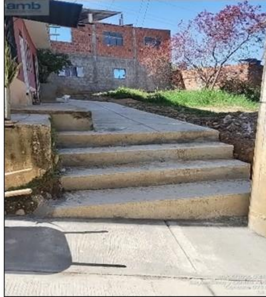
Reconstrucción de escaleras, andenes y pavimento.
