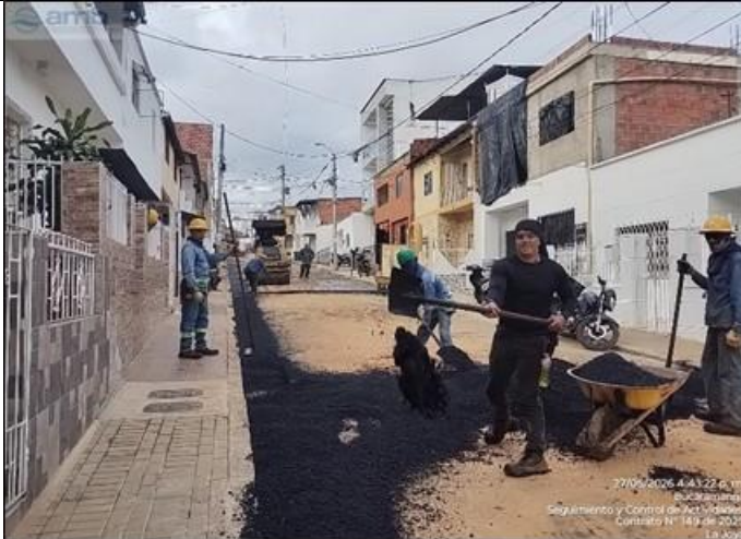
Reconstrucción de andenes y pavimentos
