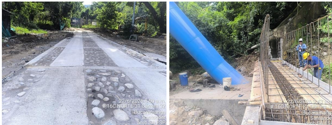
Obras de reposición en áreas intervenidas Placa de protección en Guásimo y canal de aguas lluvias en areneros
