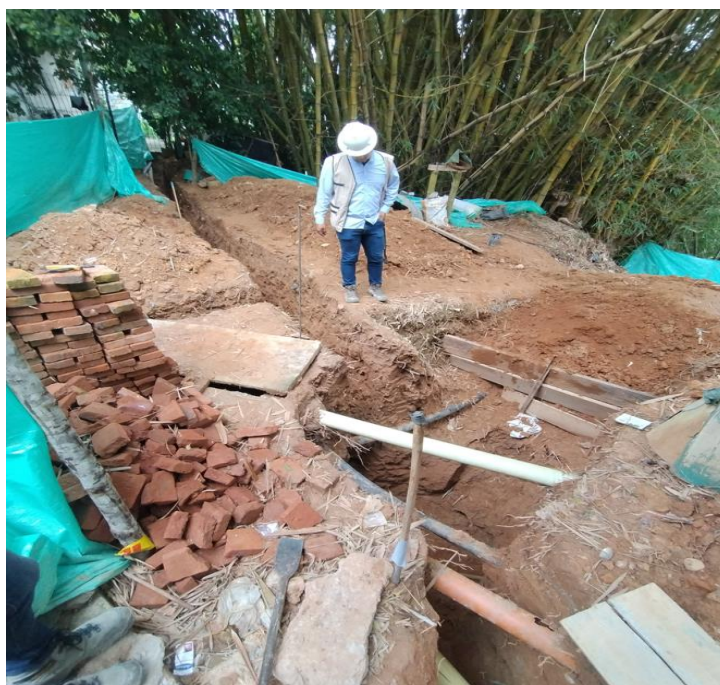
FIGURA 3. SEGUIMIENTO A LAS OBRAS
