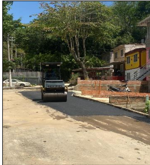
Reconstrucción de pavimento.
