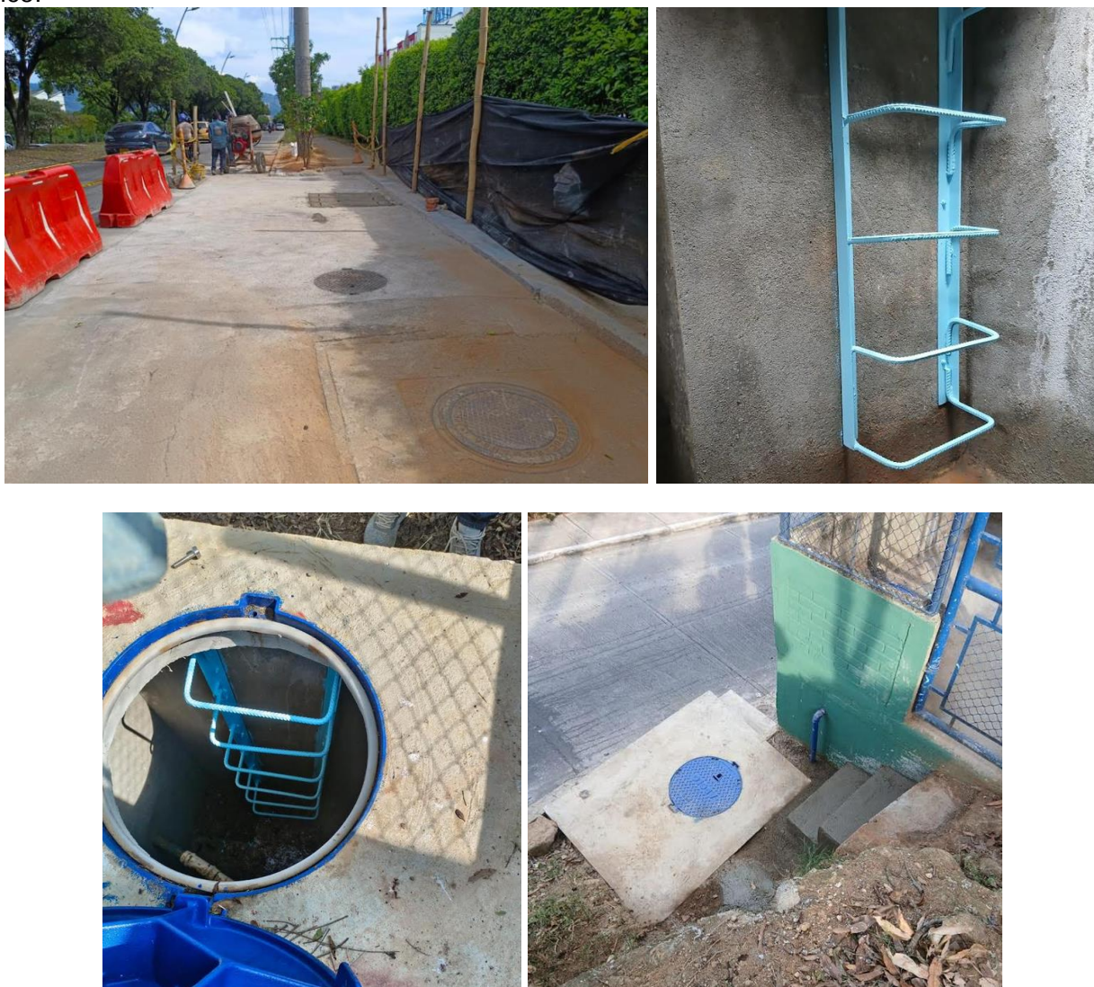
REGISTRO FOTOGRÁFICO DE CONSTRUCCIÓN DE CÁMARA PARA LA INSTALACIÓN DE EQUIPOS ESPECIALIZADOS EN EL CONTROL Y MONITOREO DE PARÁMETROS HIDRÁULICOS EN LAS REDES DE DISTRIBUCIÓN
