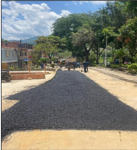
Reconstrucción de pavimento.
