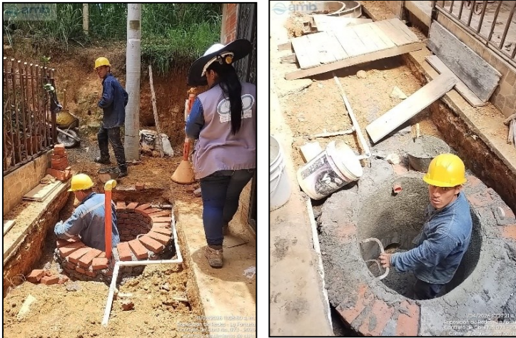
Construcción de Pozo de alcantarillado.
