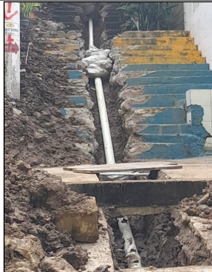
Instalación tuberías de acueducto y Reconstrucción de escaleras y andenes.
