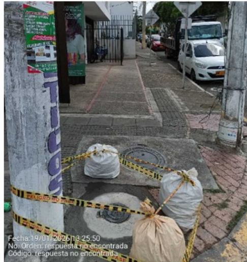
FIGURA 10 CAMBIO DE VÁLVULAS EN MUTUALIDAD CALLE 11 NO. 21-02
