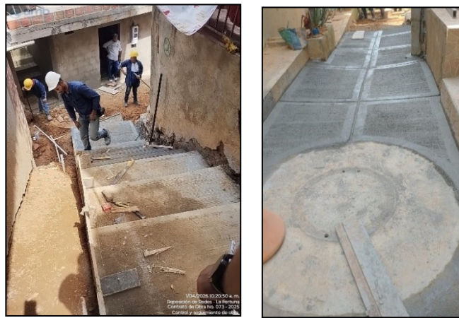
Reconstrucción de escaleras y andenes.
