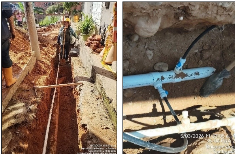
Instalación tuberías de acueducto y alcantarillado.
