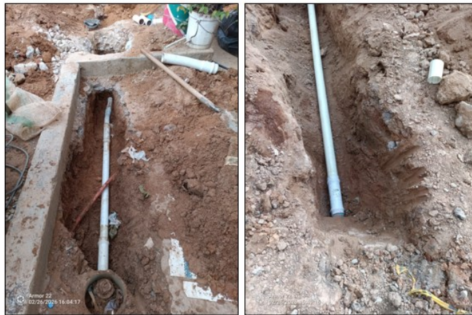
FIGURA 8 LA TRINIDAD REPOSICIÓN REDES CALLE 62 ENTRE CRA. 16 AL 18.
