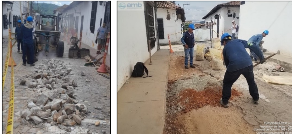
Rotura de pavimento y colocación de suelo cemento.
