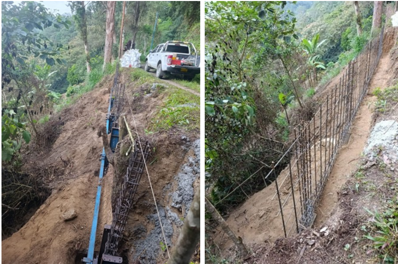
FIGURA 32 CONSTRUCCIÓN DE MUROS K17+ 030 / PANTALLA DEL K11+970 ZONAL MEDIA SISTEMA TONA
