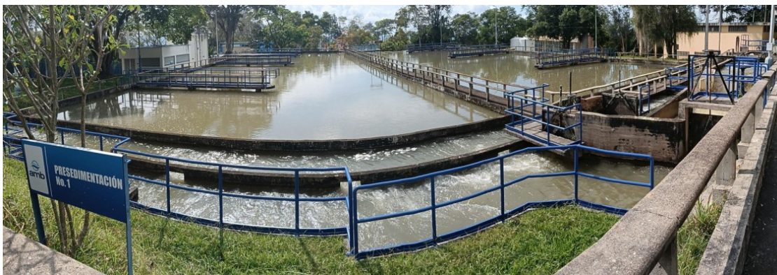
FIGURA 29 AVANCE INSTALACIÓN BARANDAS DE SEGURIDAD PRE-SEDIMENTADORES PLANTA LA FLORA
