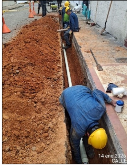
Instalación tuberías de acueducto
