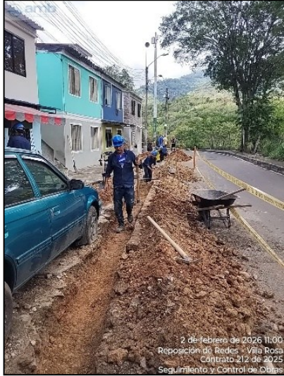
Instalación tuberías de acueducto
