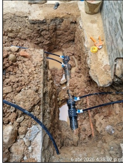
Instalación tuberías de acueducto
