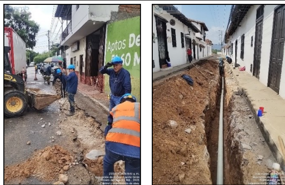
Instalación tuberías de acueducto
