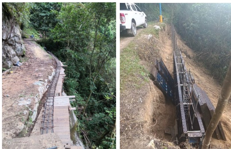
FIGURA 34 CANALES DE DERIVACIÓN / SEGUNDO TRAMO DE MURO K1+335, FIGURADO DE HIERRO
