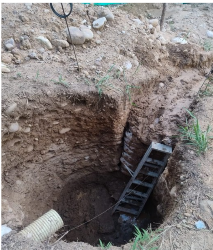
FIGURA 5. SEGUIMIENTO AL AVANCE DE LAS OBRAS DE ALCANTARILLADO – BARRIO EL CRISTAL
