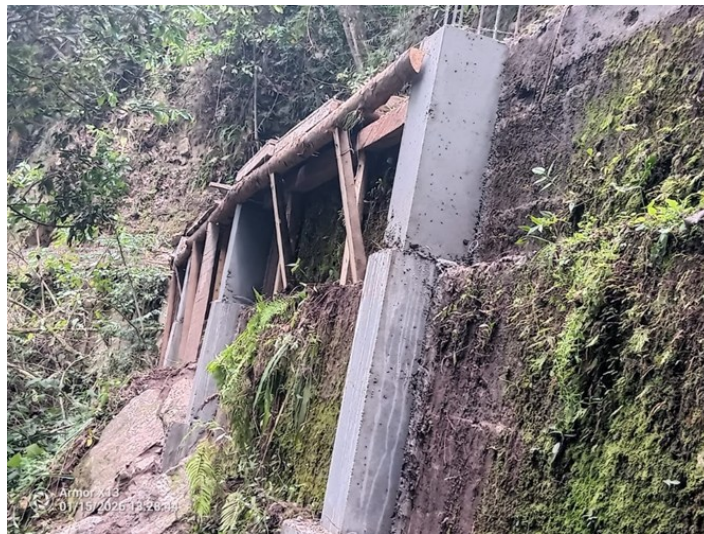
FIGURA 33 BASES DE ESTABILIZACIÓN KM 1+300 AL1+100
