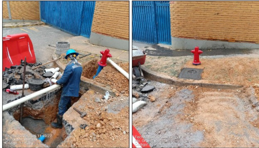
FIGURA 12 B. QUINTA BRIGADA CLL 32 # 44-03 INSTALACIÓN DE HIDRANTE
