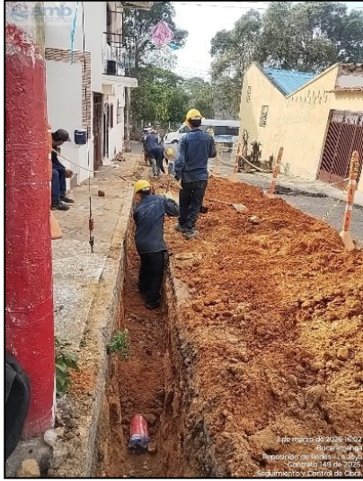
Instalación tuberías de acueducto
