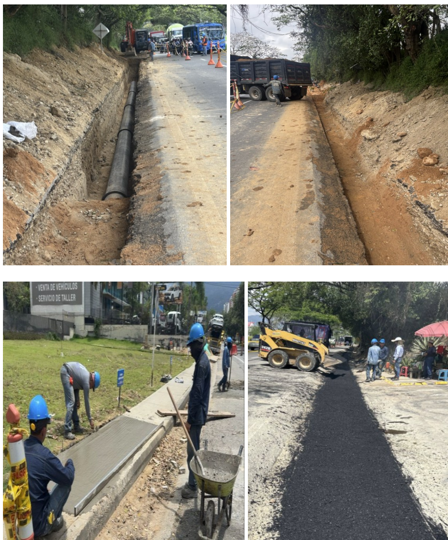
FIGURA 35 REGISTRO FOTOGRÁFICO RELOCALIZACIÓN CONDUCCIÓN PTAP FLORIDA – GIRÓN SECTOR VALMONTI – TRANSVERSAL DEL BOSQUE
