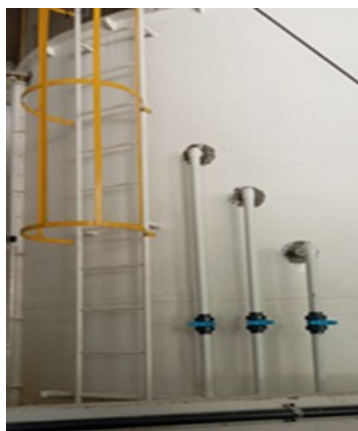
Figura 28 Instalación mirillas
