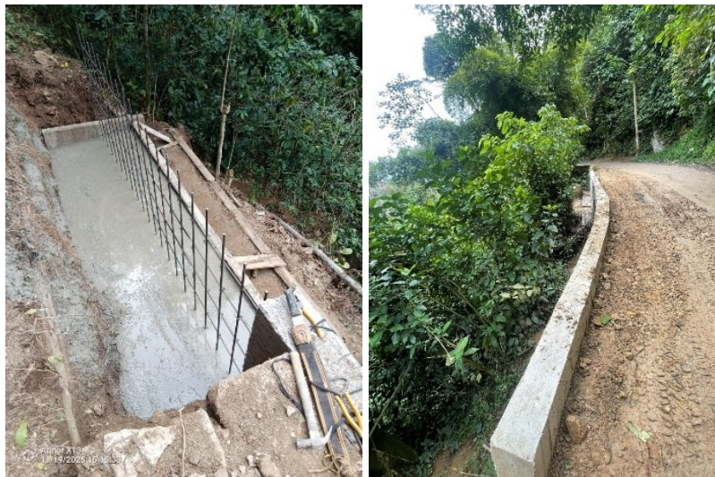
FIGURA 31 CONSTRUCCIÓN DE MUROS K19+700 S TONA Y ZONA BAJA
