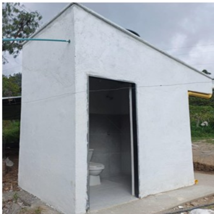
CONSTRUCCIÓN UNIDAD SANITARIA- MUNICIPIO DE SURATÁ
