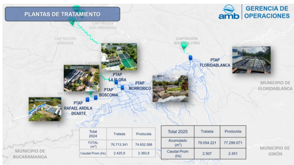
PLANTAS DE TRATAMIENTO DE AGUA POTABLE
