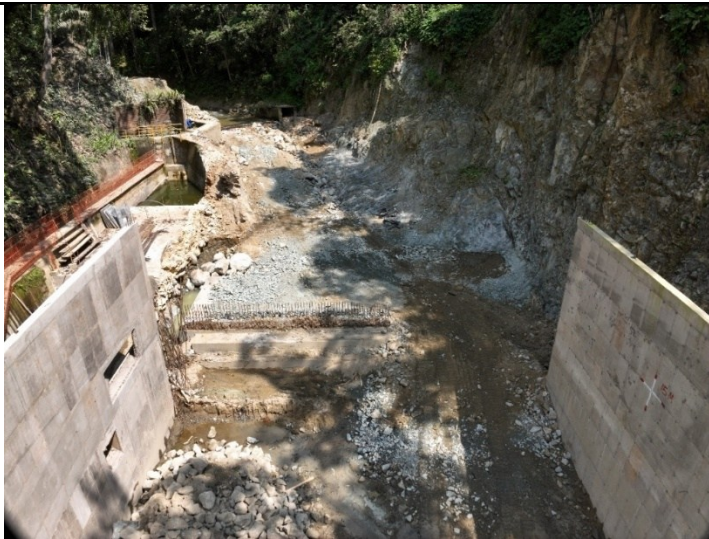
AVANCE CONSTRUCCIÓN MUROS Y ESTRUCTURA DE CAPTACIÓN.
