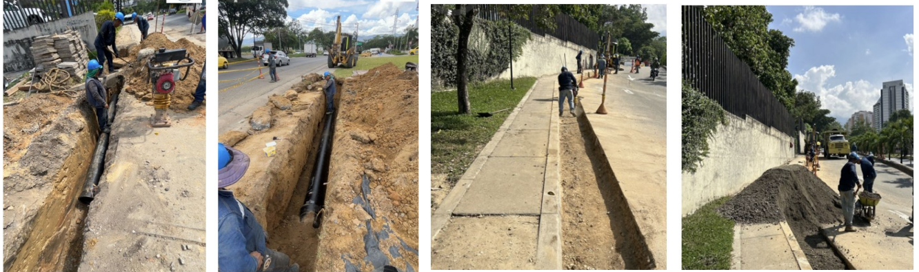
REGISTRO FOTOGRÁFICO RELOCALIZACIÓN CONDUCCIÓN
