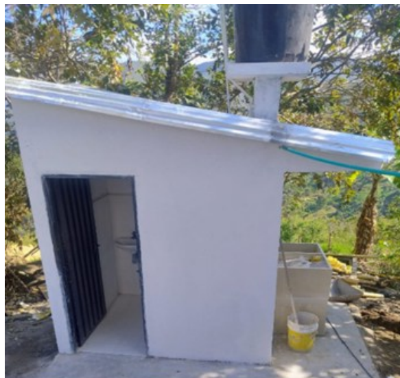
CONSTRUCCIÓN UNIDAD SANITARIA– MUNICIPIO DE CHARTA
