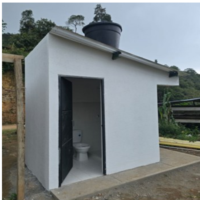
CONSTRUCCIÓN UNIDAD SANITARIA- MUNICIPIO DE MATANZA
