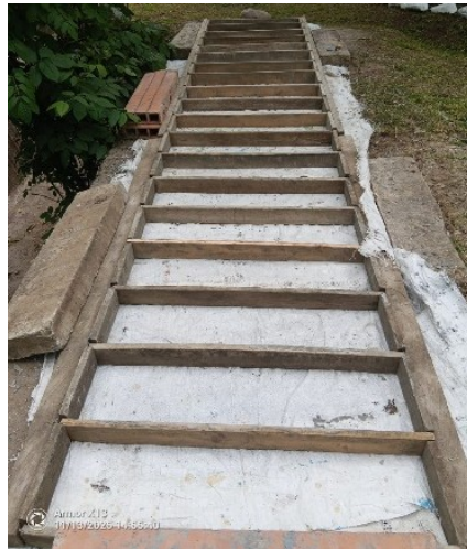
CONSTRUCCIÓN TAPAS PARA REPOSICIÓN DE CANAL DE ADUCCIÓN SISTEMA TONA
