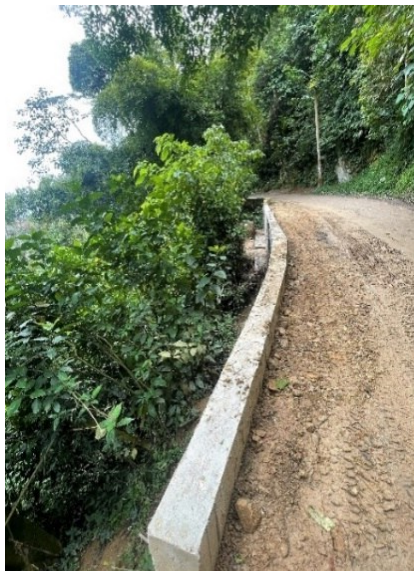
CONSTRUCCIÓN DE MUROS K19+700 S TONA Y ZONA BAJA
