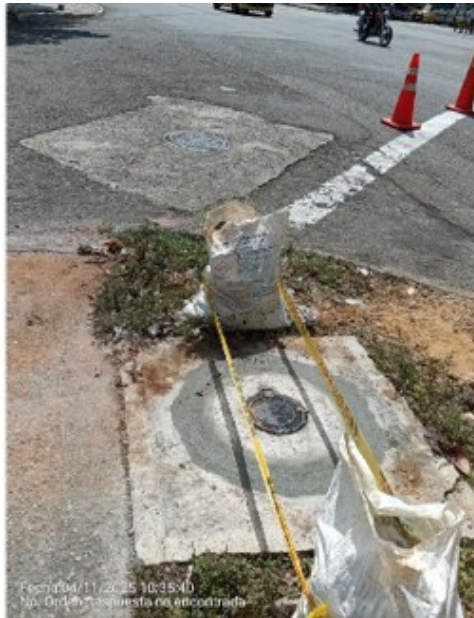
CAMBIO DE VÁLVULAS EN SAN FRANCISCO BV BOLIVAR # 18-59
