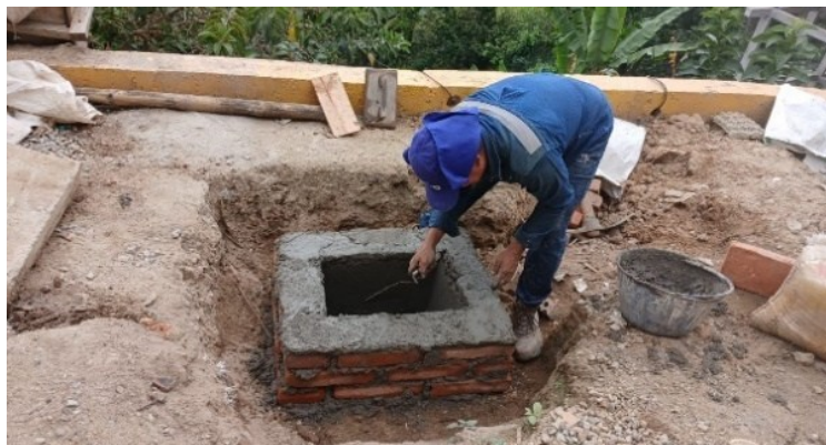
REALCE DE CAJAS DE AGUAS NEGRAS, RECEBADO DE VÍAS Y EVACUACIÓN DE ARENA.
