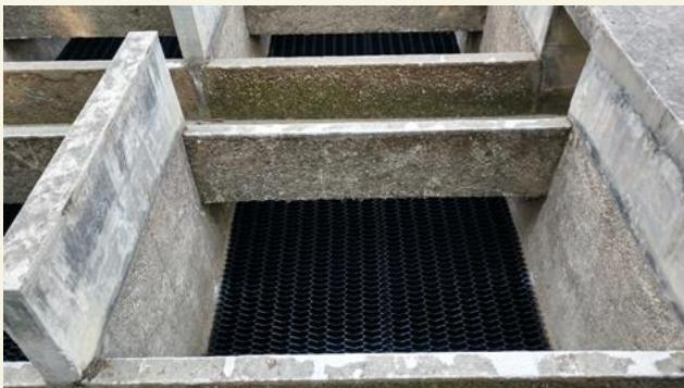
Vista general de un tanque con módulos lamelares
