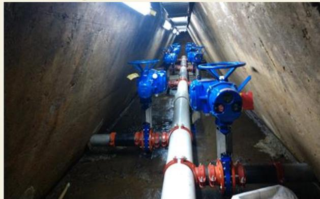
Túnel No. 1 con el sistema de válvulas dobles para los tanques 1 y 2
