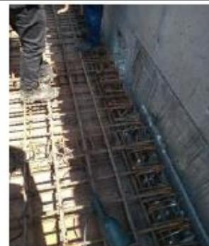
**LOS MUROS DE FILTROS Y LINDERANDO CON EL CANAL DE AGUA CRUDA DE PASO DIRECTO A FILTRACION SE ARMA PERO REQUIERE TRATAMIENTO POSTERIOR EXTERIOR DE HIDRO FUGAS**
