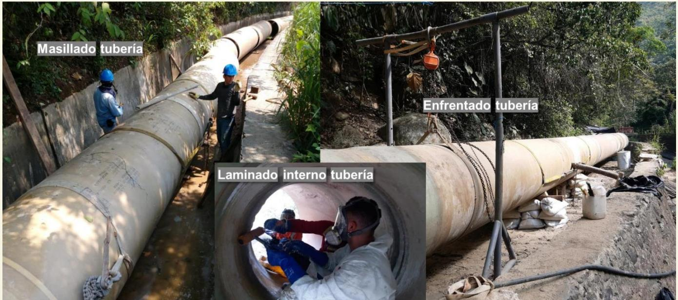
Se aprecia el proceso de instalación de tubería biaxial (transporte, alineación, masillado y laminación) a lo largo de la antigua estructura del canal de conducción de la PCH Zaragoza.
