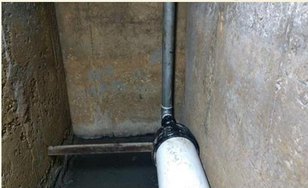
Instalación de la línea de lavado en acero
