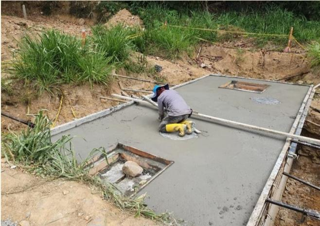
Reposición de Redes El vivero (Construcción de Cámara de entrada tanque Norte Bajo)
