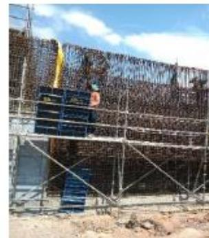
**LOS SEDIMENTADORES AVANZAN EN EL SEGUNDO Y TERCER NIVEL DE MUROS EXTERNOS EN LA ZONA ALEDAÑA A EDIFICIO ADMINISTRATIVOS MODULOS 2 ; EN LA ZONA CERCANA A FILTROS, MODULO 1 LOS MUROS ESTAN ARMADOS Y SE FORMALETAN PARA FUNDIDA A NIVEL SEGUNDO**
