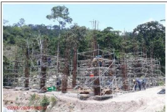
ARMADO ACERO COLUMNAS EDIFICIO DESHIDRATACIÓN
