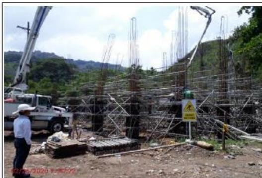
VACIADO DE CONCRETO COLUMNAS EDIFICIO DE DESHIDRATACIÓN
