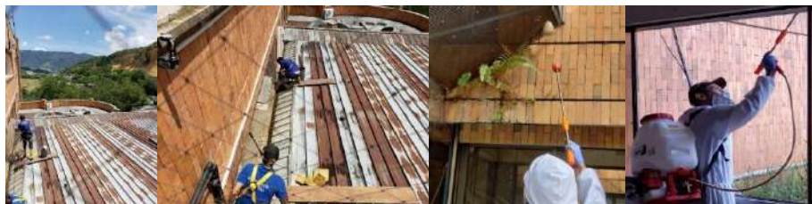
Ilustración 11 Control de plagas y lavado de techos.
