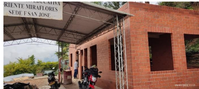
Sede Educativa Miraflores Remodelada
