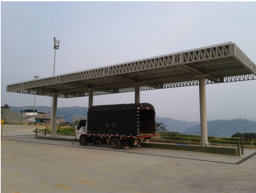
CONSTRUCCION DE ZONA DE ABASTECIMIENTO DE COMBUSTIBLES UBICADO EN PATIO TALLER DE OPERACIONES
