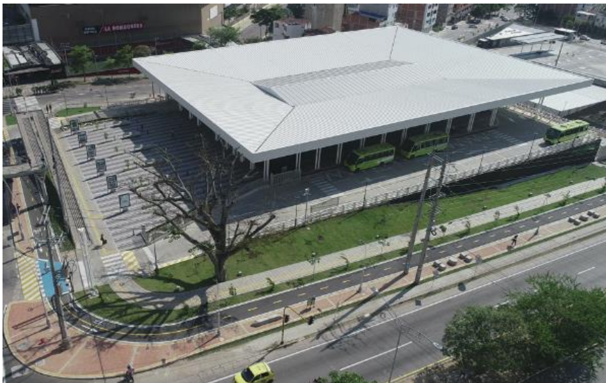
Estación de Transferencia en Operación.
