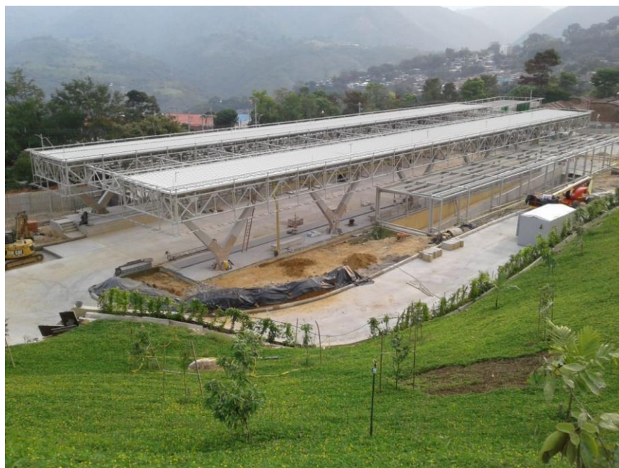
CONSTRUCCION DE CUBIERTA TIPO SANDWICH PARA PLATAFORMAS SUR Y NORTE EN ESTACION DE TRANSFERENCIA
