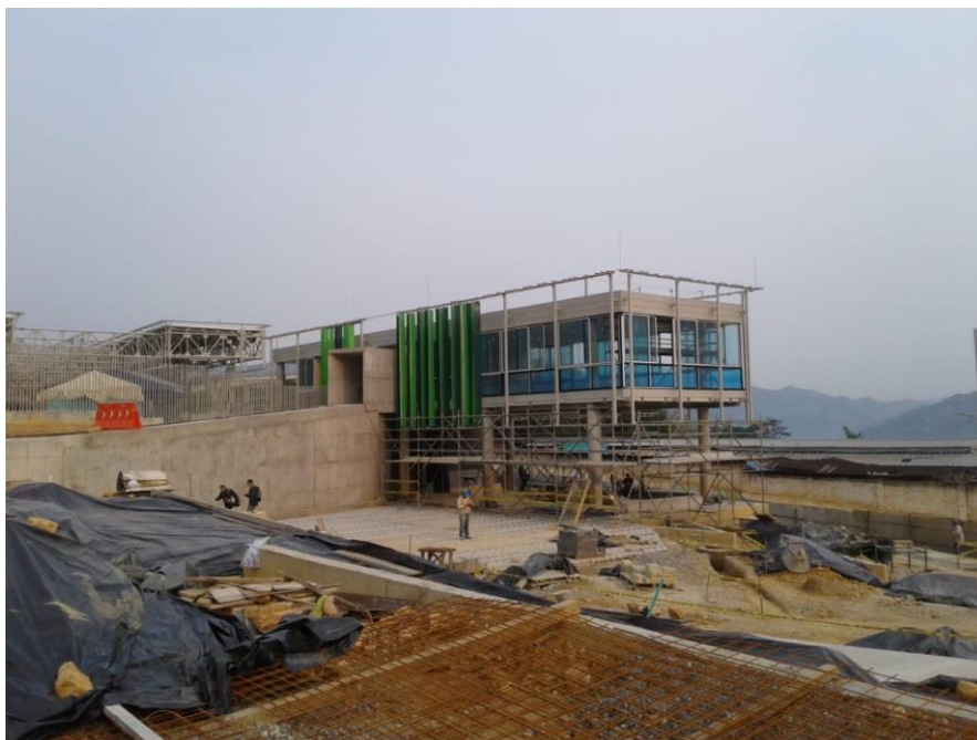
SUMINISTRO E INSTALACION DE PANELES VERTICALES EN FACHADA DEL EQUIPAMENTO
