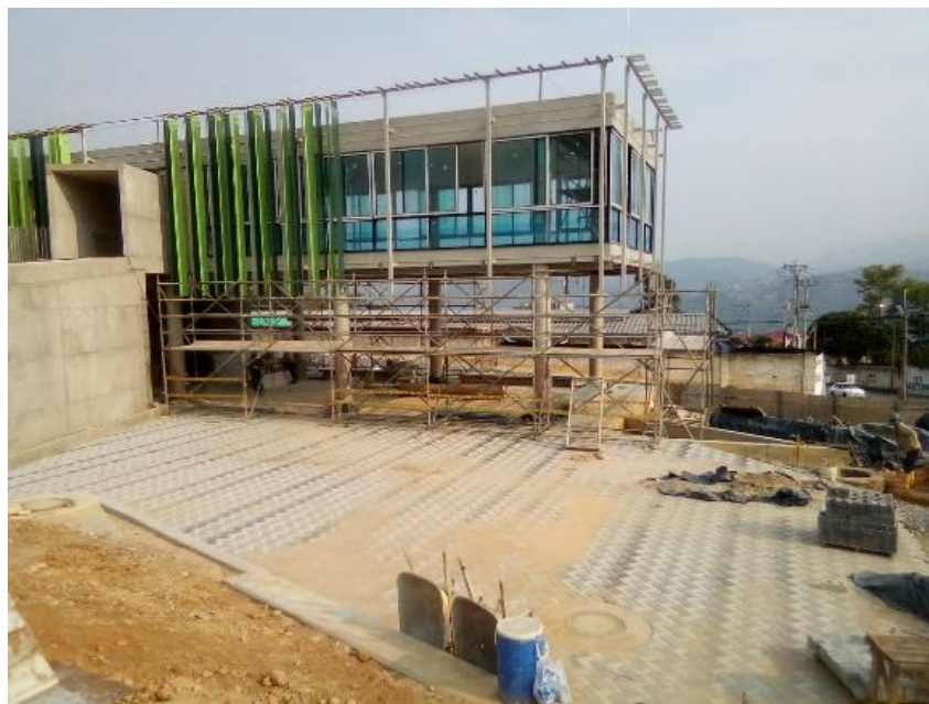
INSTALACION CUBIERTA TIPO SANDWICH PLATAFORMA NORTE
