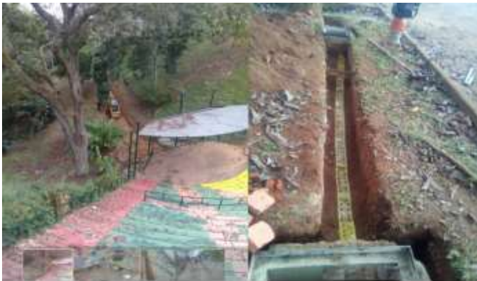
DEMOLICIONES DE ANDENES PARA BANCOS DE DUCTOS, TENDIDO DE BANCOS DE DUCTOS Y CONSTRUCCIÓN DE CAJAS DE HALADO.
