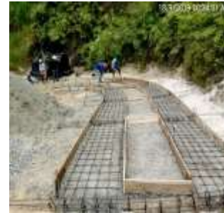
INICIO DE ARMADO PARILLA PARA PLACA HUELLA DE MIRADOR
