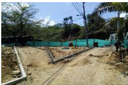
CONSTRUCCION DE BORDILLO Y SARDINELES
