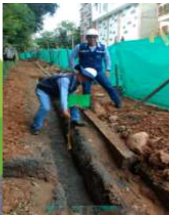
EXCAVACIONES PARA BANCOS DE DUCTOS COSTADO ORIENTAL PARQUE.
