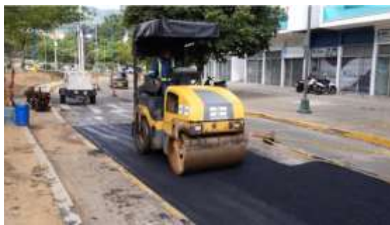
Calle 105 (Occ-Or) Desde Cra 26 hasta el puente Provenza
