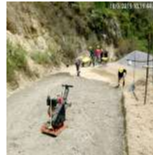
COMPACTACION DE BASE EN CURVA CUCHARAL
