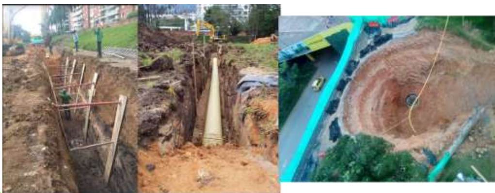
Construcción de Red y pozos de alcantarillado
