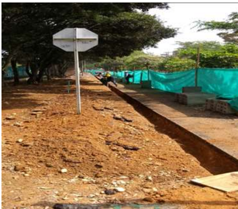
EXCAVACIONES PARA BANCOS DE DUCTOS, CERRAMIENTOS Y REPLANTEO DEL PROYECTO.
