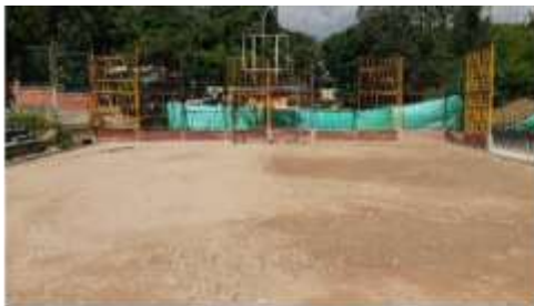
CANCHA MULTIPLE BARRIO VILLA ROSA SECTOR 4, 5 Y 6
