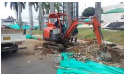
EXCAVACIONES PARA BANCOS DE DUCTOS FRENTE A LA PLAZOLETA DE LA DEMOCRACIA
