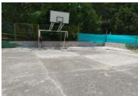
CANCHA MULTIPLE B. VILLA ROSA SECTOR 4, 5 Y 6
