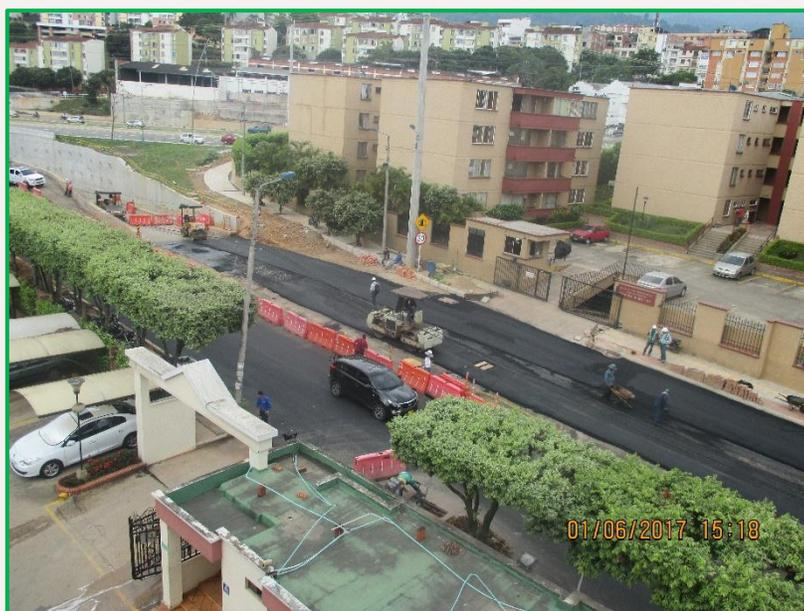
**Foto 2:** Instalación de mezcla densa en caliente MDC-2 modificado en la salida del Barrio Diamante (Sentido Sur – Norte).
