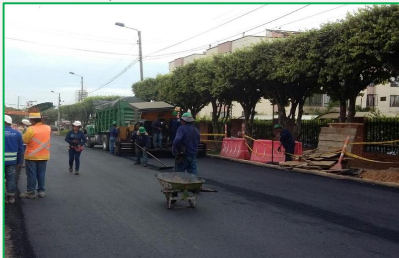
**Foto 1:** Instalación de mezcla densa en caliente MDC-2 modificado en la entrada al Barrio Diamante.
