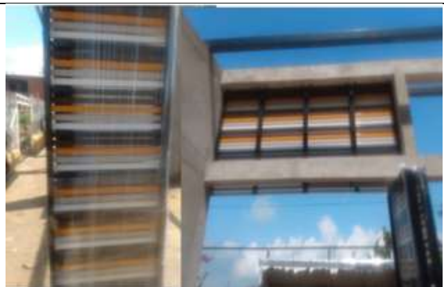
Instalación Módulos Fachada Flotante
