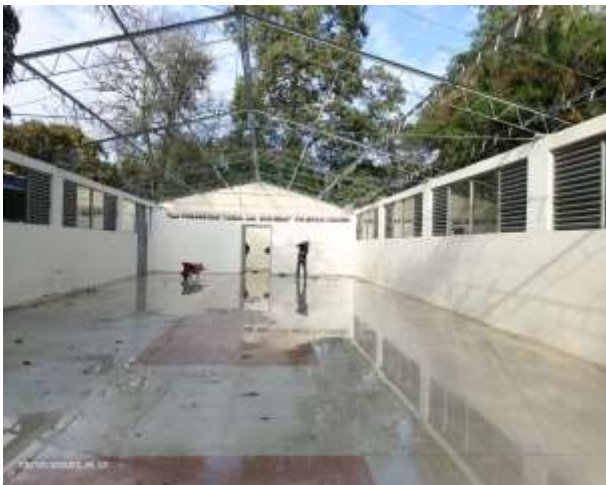
Desmonte de Cubierta y aparatos sanitarios
