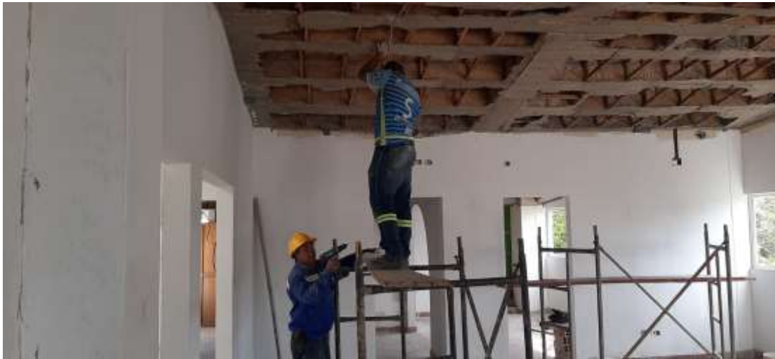
DESINSTALACION DE CIELO RASO EXISTENTE Y ADJACION PARA NUEVO CIELO RASO
