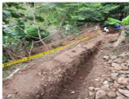
Foto 4. Excavación tubería
