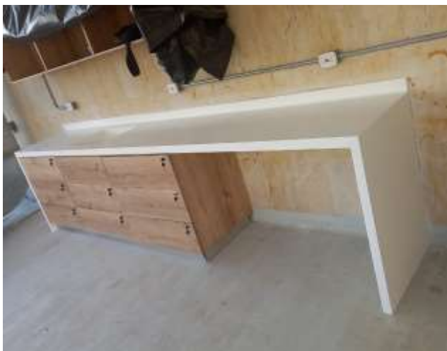
Suministro e instalación de meson y patas en Corian
