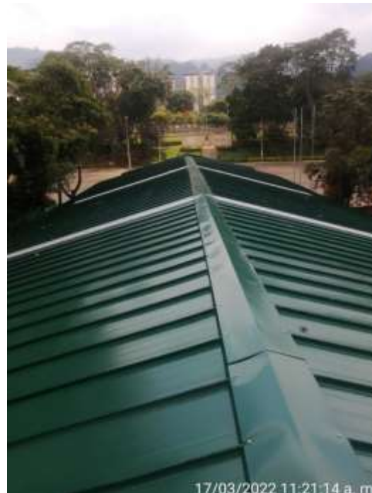
Mantenimiento de Estructura, Suministro e Instalación de Cubierta Tipo DSS
