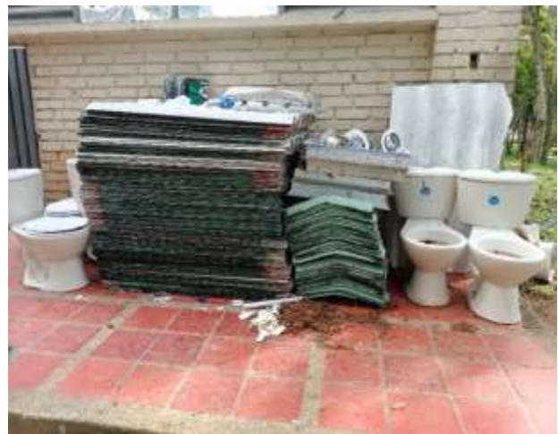
Desmonte de Cubierta y aparatos sanitarios
