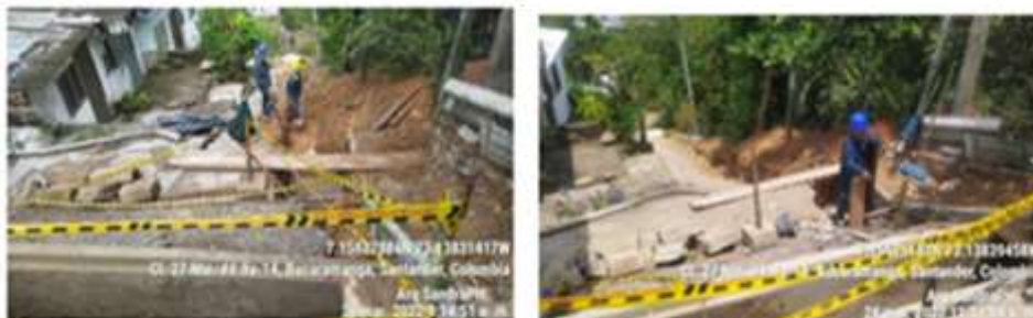
HAMACAS 1 - CONSTRUCCION DE GRADAS
