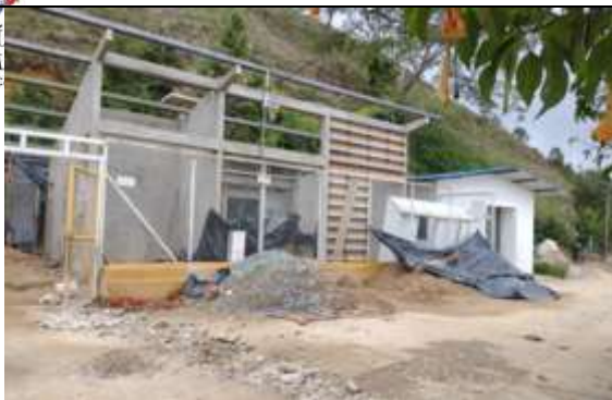
Proceso de Instalación Fachada flotante y montaje estructura cubierta
