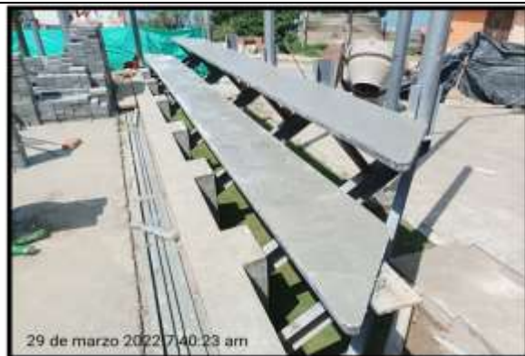
AHORA: CONSTRUCCION GRADERIA FUNDIDA EN SITIO
