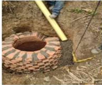
Foto 2. construcción pozo de absorción.
