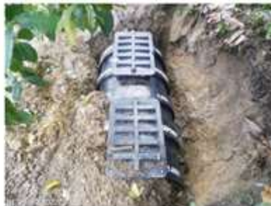
Foto 4. Tanque Séptico
