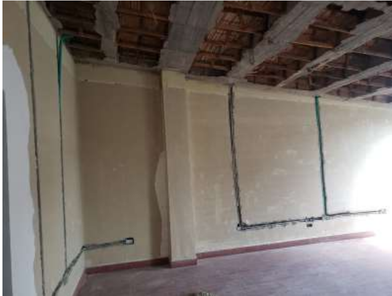
REPARACIONES DE VIGAS Y ADECUACION PARA CIELO RASO
