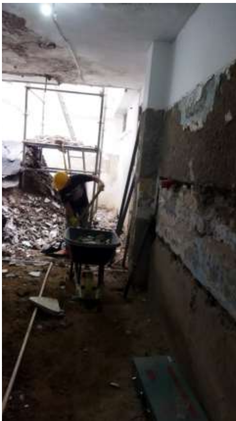
DEMOLICIONES DE ENCHAPES
