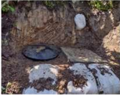
Foto 1. Caja de inspección y trampa de grasas.
