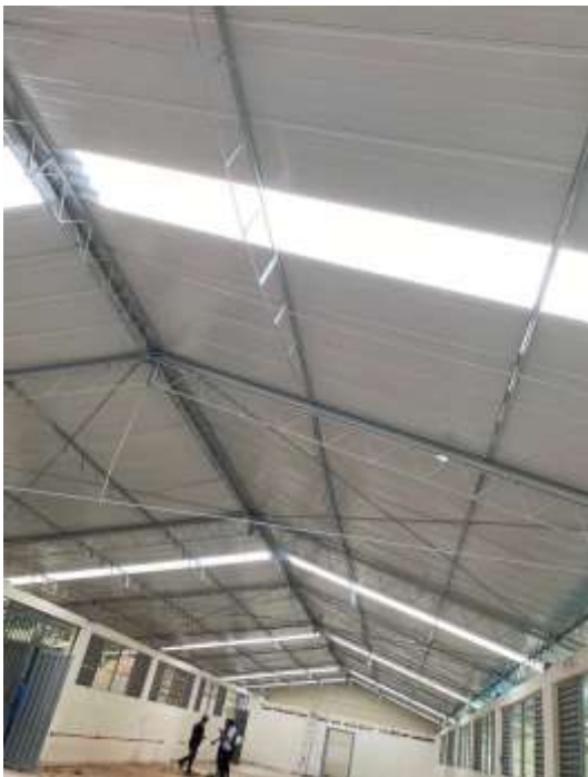
Mantenimiento de Estructura, Suministro e Instalación de Cubierta Tipo DSS
