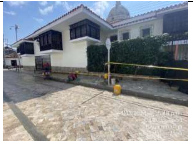
Brechado de juntas sobre piso travertino peatonal
