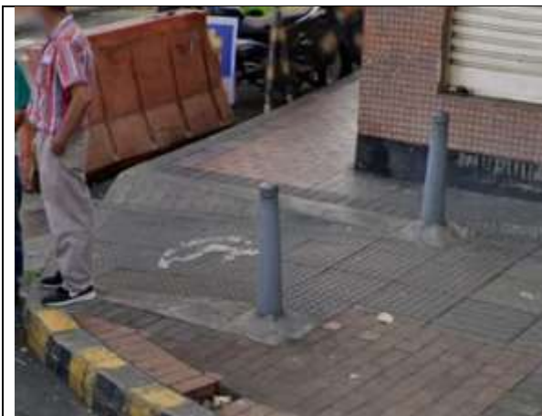
ANTES DE LA INTERVENCION RAMPAS CARRERA 15 CON CALLE 31
