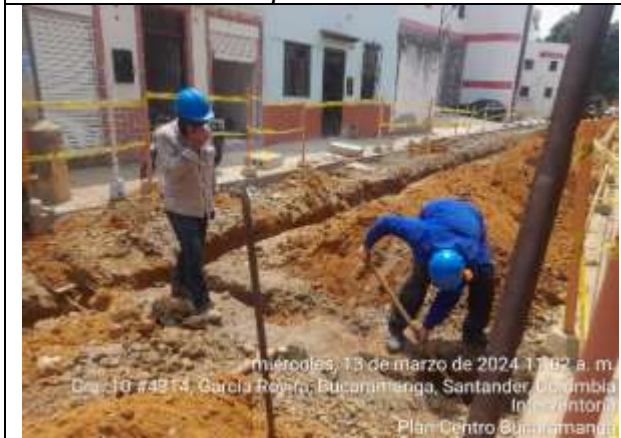
Excavaciones para acometidas domiciliarias
