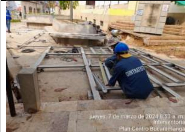
Instalación de estructura metálica de soporte para deck
