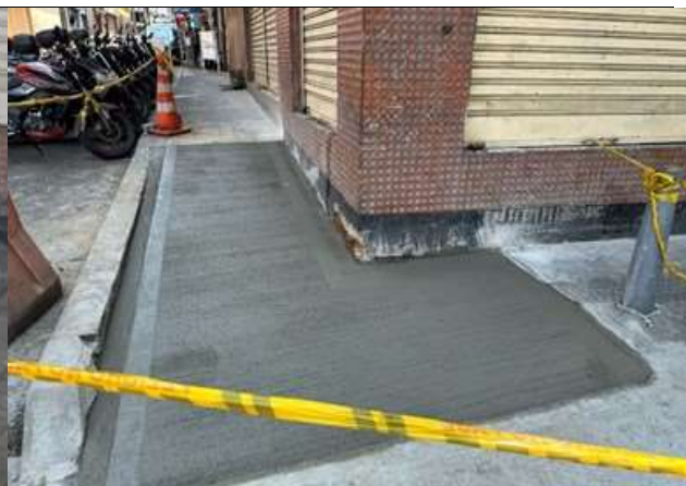
RESULTADO DE FUNDICION RAMPAS CARRERA 15 CON CALLE 31
