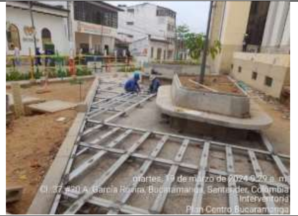
Instalación de estructura metálica de soporte para deck
