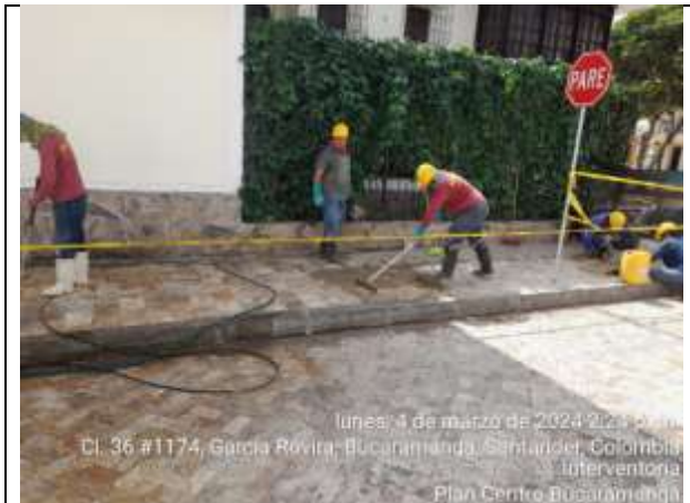
Brechado de juntas sobre piso travertino peatonal
