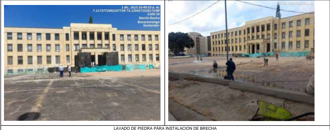
LAVADO DE PIEDRA PÁRA INSTALACION DE BRECHA
