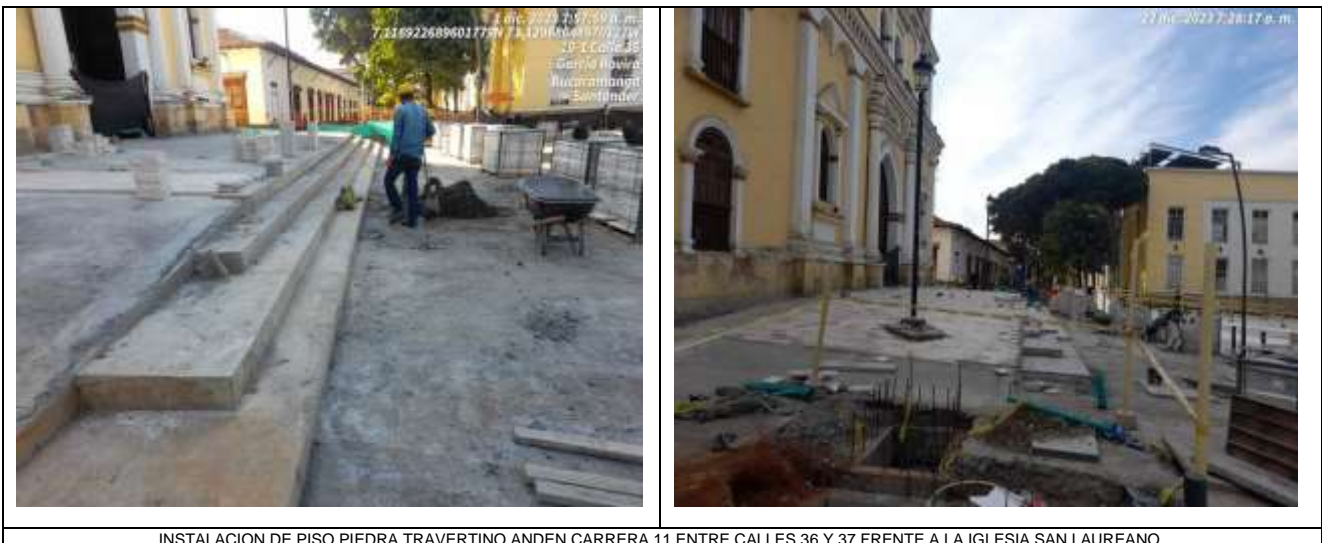
INSTALACION DE PISO PIEDRA TRAVERTINO ANDEN CARRERA 11 ENTRE CALLES 36 Y 37 FRENTE A LA IGLESIA SAN LAUREANO.
