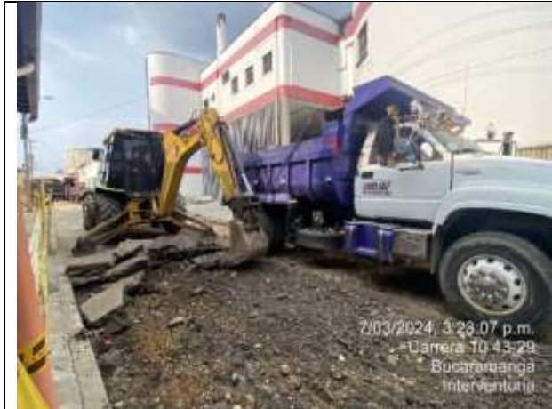
Demolición pavimento asfáltico
