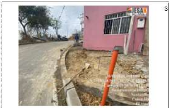
Localización: tramo # 3 Costado Oriente Cll 58N des de la Cra 20 hasta volver a encontrar la intersección con la Cra 20 Descripción: instalación de sardinel y demolición de andén
