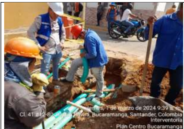
Instalación tubería redes eléctricas
