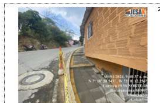
Localización: tramo # 3 Costado Oriente Cll 58N des de la Cra 20 hasta volver a encontrar la intersección con la Cra 20 Descripción: instalación de adoquin en el espacio publico
