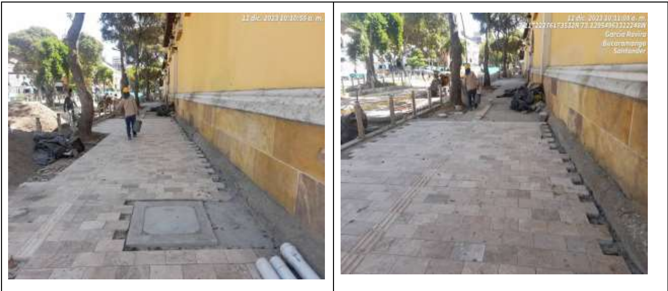
LAVADO DE PIEDRA PÁRA INSTALACION DE BRECHA
