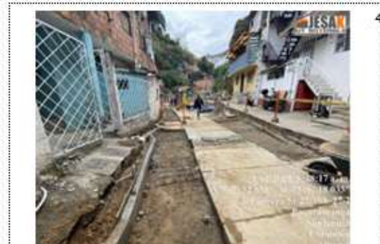
Localización: cr 51 # 19b-33 entre cr 51# 19b-47 Descripción: instalación de bas e y acero de refuerzo dovelas
