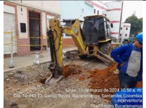
Excavaciones para red de acueducto
