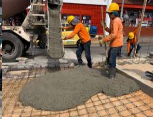
SUMINISTRO E INSTALACION DE CONCRETO PARA VADOS SOBRE SEPARADOR CARRERA 15
