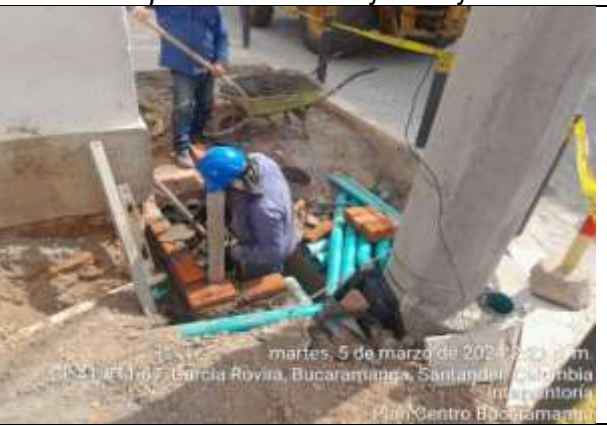
Adecuación de caja telemáticos existente
