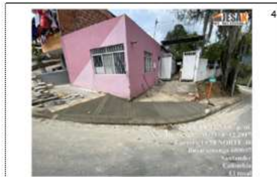
Localización: tramo # 3 Costado Oriente Cll 58N des de la Cra 20 hasta volver a encontrar la intersección con la Cra 20 Descripción: fundida de rampa vehicular
