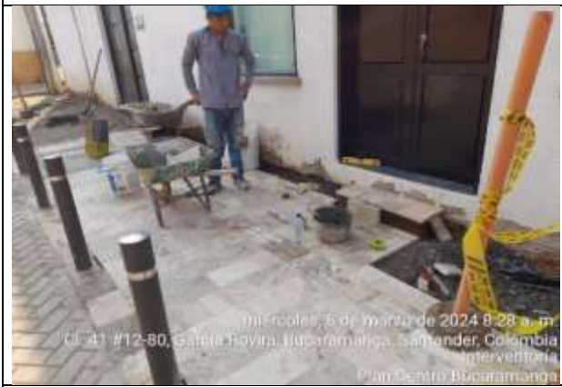
Instalación piso travertino peatonal
