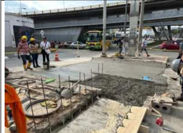
SUMINISTRO E INSTALACION DE CONCRETO PARA VADOS SOBRE SEPARADOR CARRERA 15
