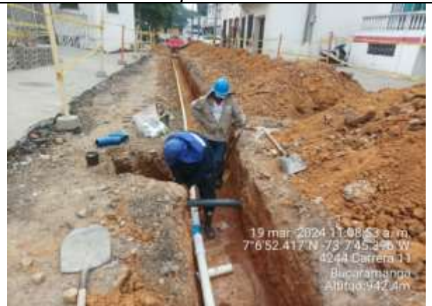
Instalación tubería de acueducto
