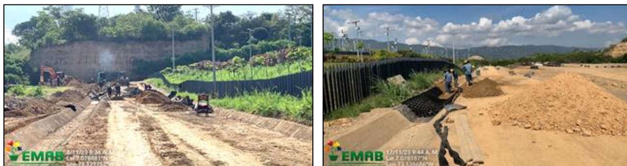
Ilustración 6 Construcción canales para manejo de aguas lluvias y escorrentía, noviembre de 2023
