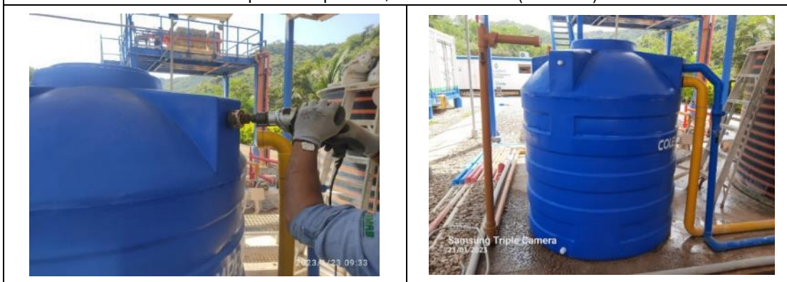
Reemplazo tanque de 2,2 m 3 salida DAF (Enero/23)
