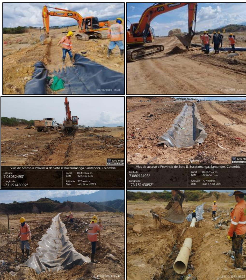
Ilustración 5 Construcción canales para manejo de aguas lluvias y escorrentía, octubre 2023
