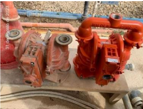
Instalación de una nueva bomba neumática de lodos (Agosto/23)
