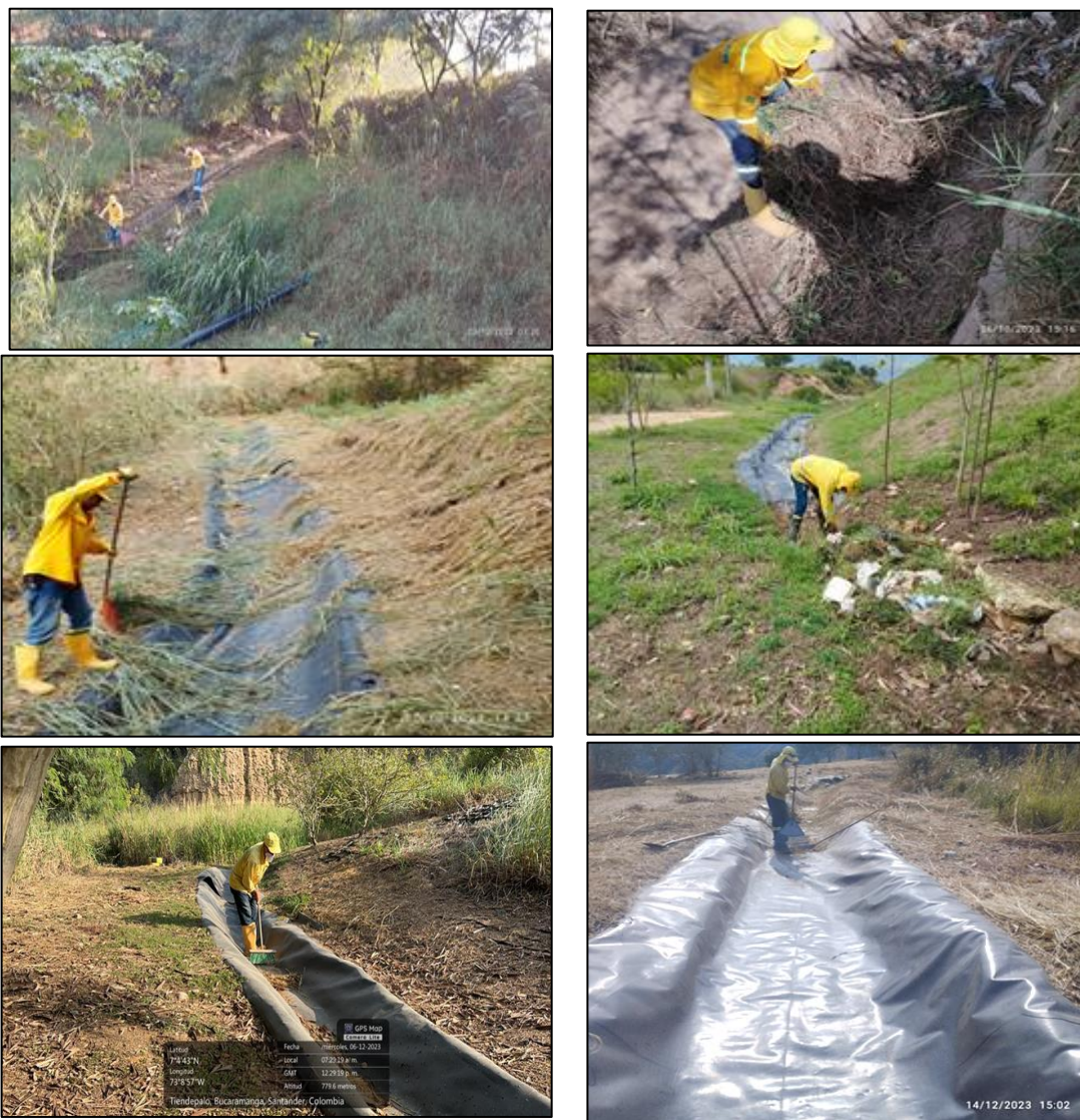
Ilustración 8 Limpieza de los canales de aguas lluvias.
