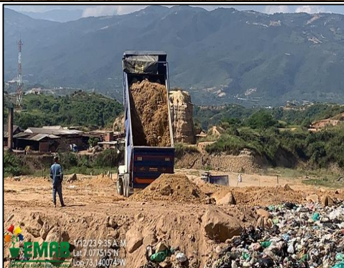
Ilustración 4 Cobertura de residuos sólidos con material terroso o granular
