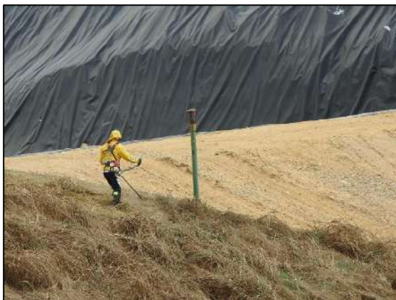
Ilustración 4 Actividades de rocería para el mantenimiento de áreas clausuradas (celda 2).
