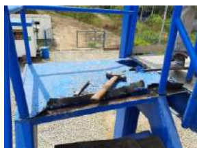
Instalación lámina de acero inox en filtro prensa
