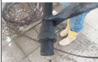
Inspección y limpieza del pie de válvula del tanque salida DAF
