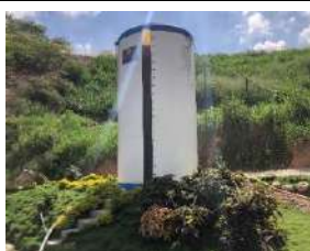
Descarga del lixiviado de la extracción forzada de las celdas del relleno
