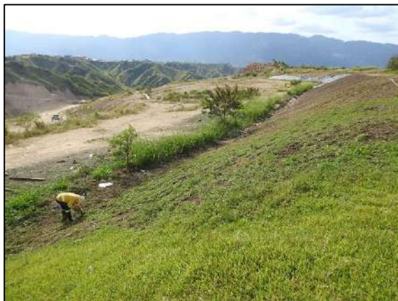
Ilustración 6 Siembra de material vegetal en talud de la celda 1.
