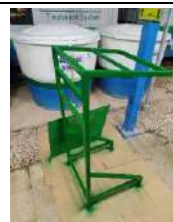
Mantenimiento al soporte de la bomba dosificadora de ácido
