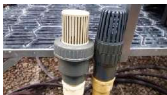
Inspección y limpieza del pie de válvula del tanque salida DAF
