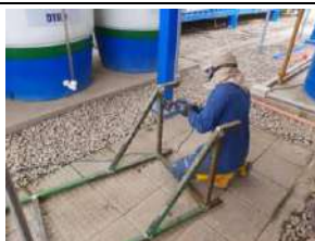
Mantenimiento al soporte de la bomba dosificadora de ácido
