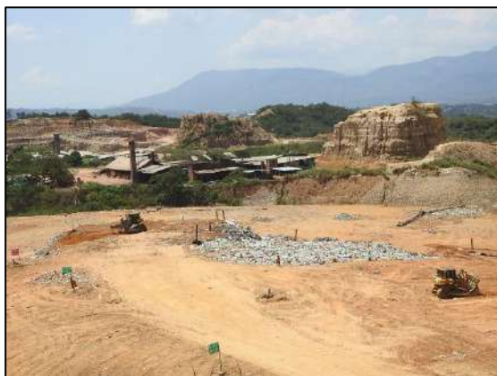
Ilustración 10 Cubrimiento de los residuos sólidos para limitar el área de atracción (celda de respaldo 1).
