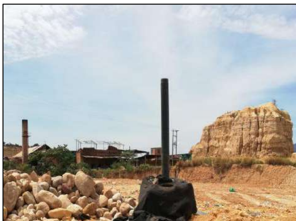
Ilustración 14 Realce de chimeneas celda de respaldo 1.
