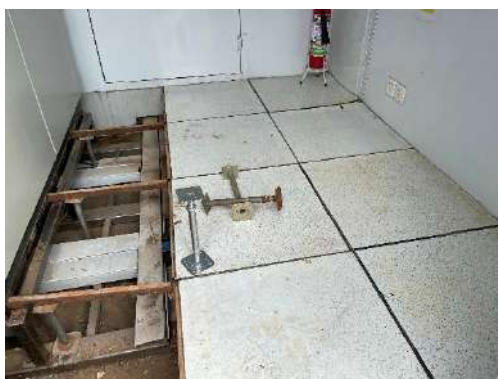
Resultado final de la instalación del piso falso DTRO
