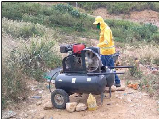
Ilustración 17 Extracción forzada de lixiviado pozo 9 celda 4.
