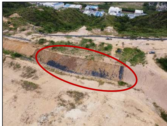
Ilustración 7 Instalación de 1780 m² de geocelda para clausura del talud de la celda 1.
