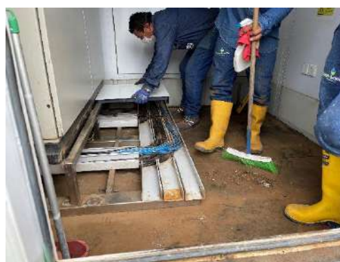
Resultado final de la instalación del piso falso DTRO
