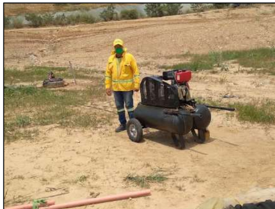
Ilustración 18 Extracción forzada de lixiviados pozos 6 celda de respaldo 1.
