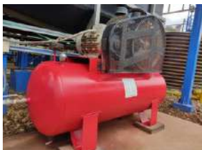
Aplicación de pintura al compresor
