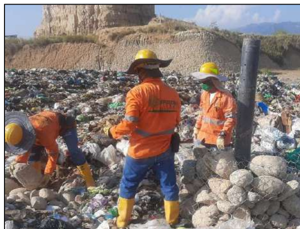
Ilustración 15 Construcción de chimeneas celda de respaldo 1
