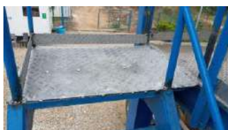
Instalación lámina de acero inox en filtro prensa
