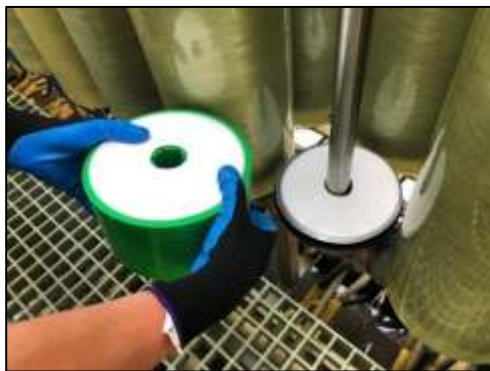
Ilustración 33 Reemplazo de membranas y discos
