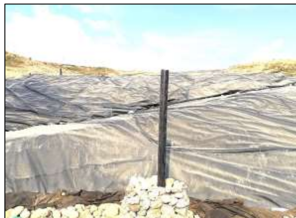
Ilustración 26 Construcción de chimeneas celda de respaldo 1.
