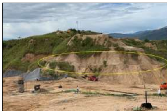
Ilustración 14 Inicios de excavación
