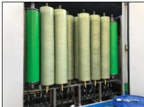
Ilustración 33 Reemplazo de membranas y discos
