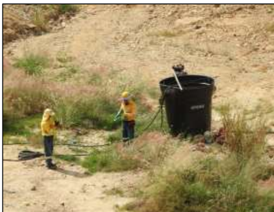
Ilustración 29 Extracción forzada de lixiviados pozos 5 celda 4.
