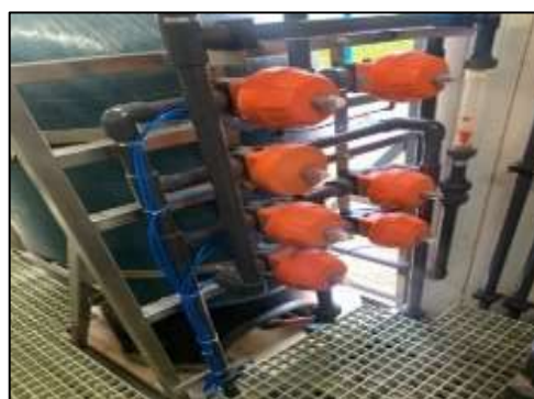
Ilustración 36 Bomba de alta presión tipo pistón
