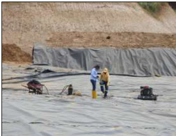
Ilustración 27 Extracción forzada de lixiviados pozos 2 celda 4.
