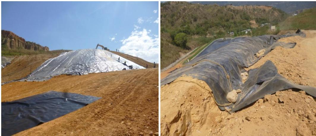
**IMAGEN 3 y 4: Instalación del Neoweb en la Celda N° 2 Cárcava 2**
