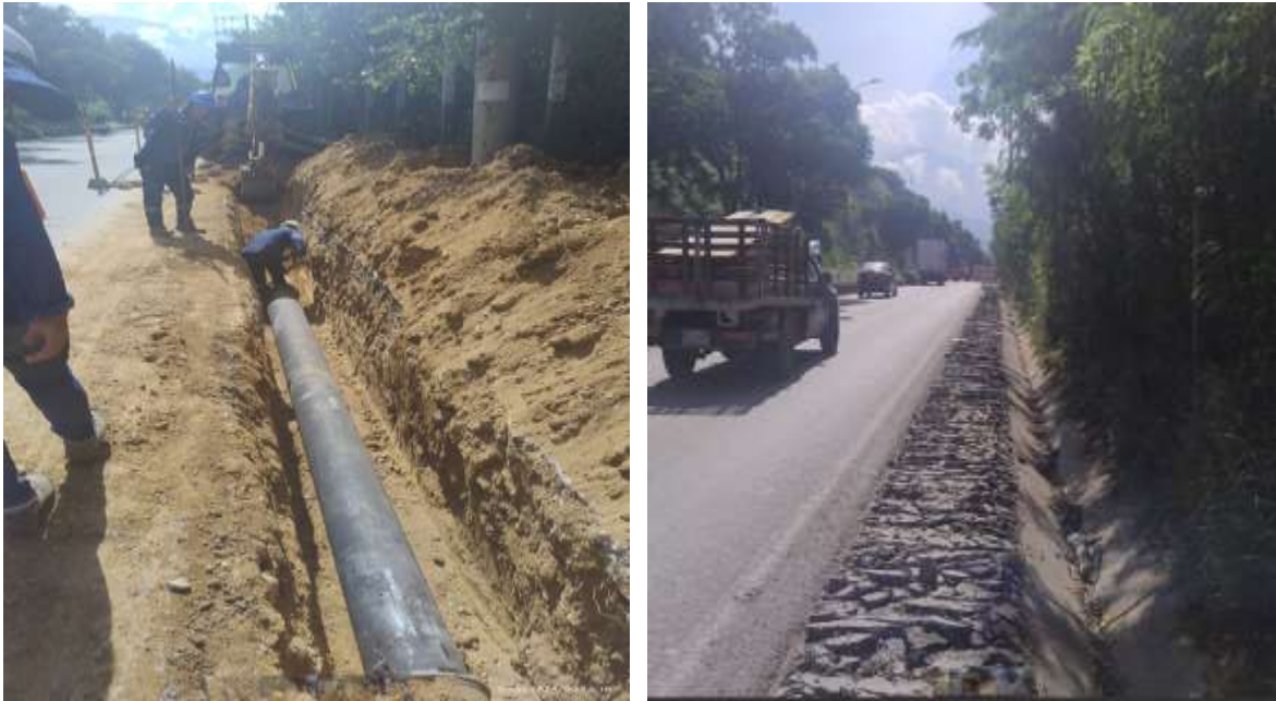
FIGURA 8 REGISTRO FOTOGRÁFICO INSTALACIÓN TUBERÍA SECTOR PIMPOLLO.
