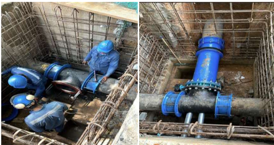
FIGURA 9 REGISTRO FOTOGRÁFICO ADECUACIÓN DE REDES TANQUE MORRO ALTO.
