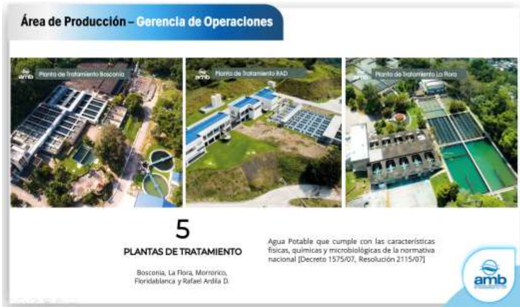
FIGURA 2. PLANTAS DE TRATAMIENTO DE AGUA POTABLE
