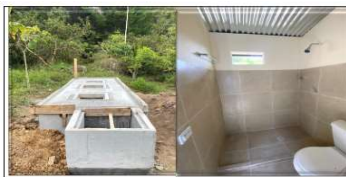
FIGURA 1. CONSTRUCCIÓN UNIDADES SANITARIAS
