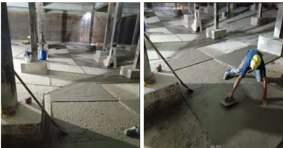
FIGURA 10 REGISTRO FOTOGRÁFICO LOSA DE FONDO TANQUE NORTE BAJO.
