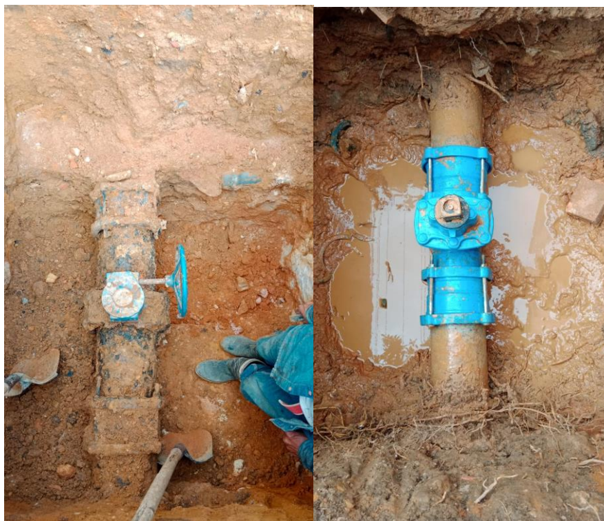
FIGURA 28. SUMINISTRO E INSTALACIÓN DE VÁLVULAS Y TAPAS DE SEGURIDAD PARA LA SECTORIZACIÓN DE LOS DISTRITOS HIDRÁULICOS NORTE, MORRO ALTO Y ESTADIO DE BUCARAMANGA (POIR 5.5)
