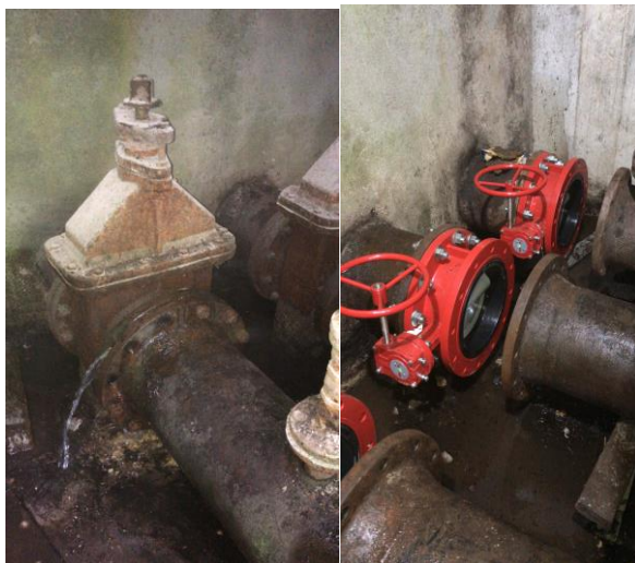
FIGURA 27. SUMINISTRO E INSTALACIÓN DE VENTOSAS Y VÁLVULAS EN LAS CONDUCCIONES DEL AMB (POIR 5.5) VÁLVULAS DE SALIDA CONDUCCIÓN PAN DE AZÚCAR
