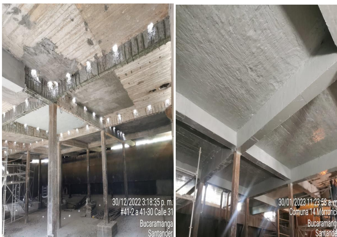
FIGURA 29. REFORZAMIENTO ESTRUCTURAL DEL TANQUE DE ALMACENAMIENTO NORTE BAJO (POIR 33.1)
