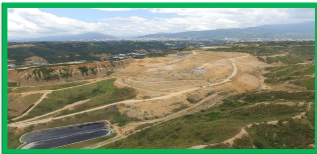
Adecuación de Terrenos.
