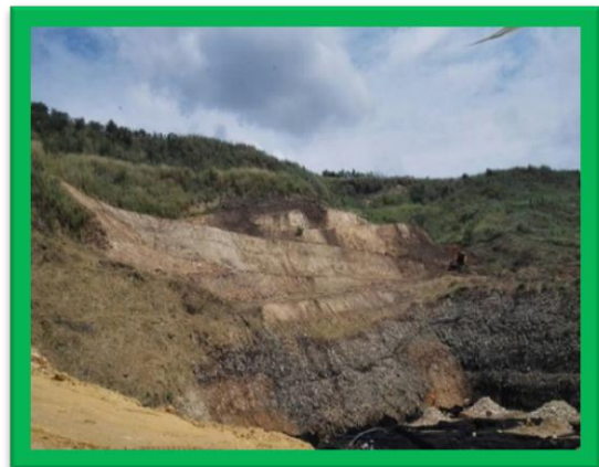
Desmante, limpieza y perfilado de taludes
