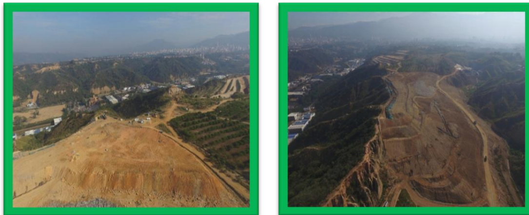
Cobertura final zonas de disposición del Meses anteriores.
