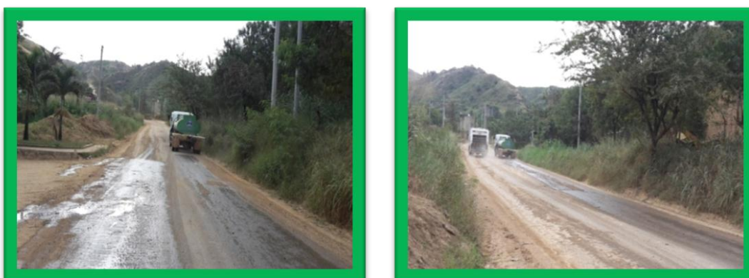
Control de material particulado cerca a los talleres de mantenimiento de la EMAB
