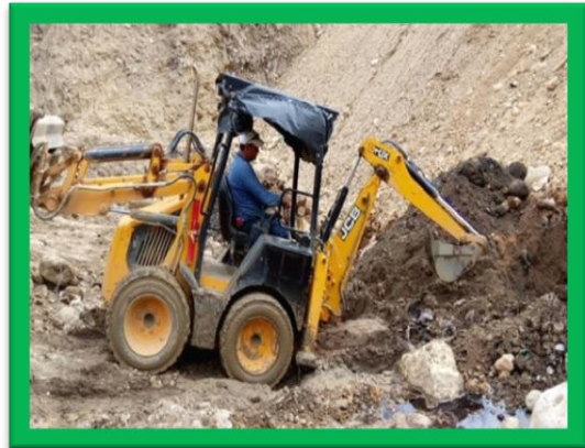
Excavaciones zanjas dren base del dique
