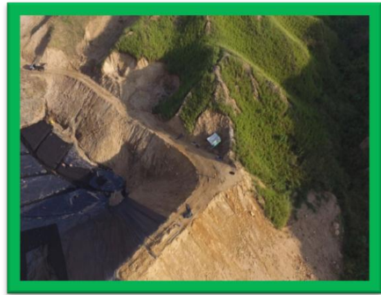
Vista actual del dique construido y de la celda
