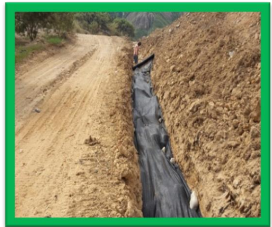
Llenado con bolo y recubrimiento con geotextil de filtro perimetral ubicado sobre la parte inferior del domo de residuos
