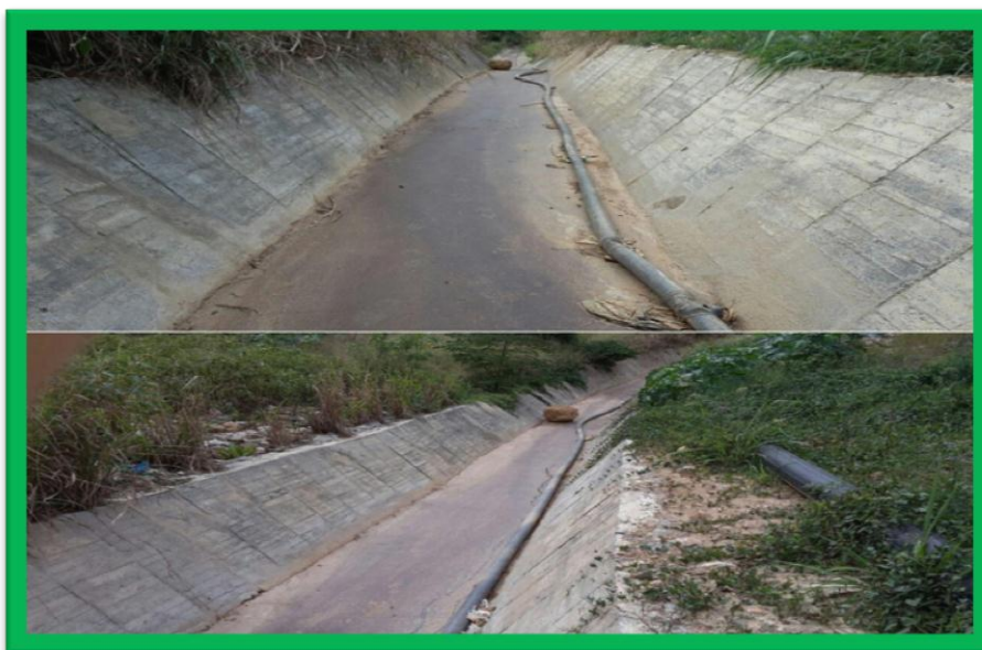
Canal de aguas lluvias
