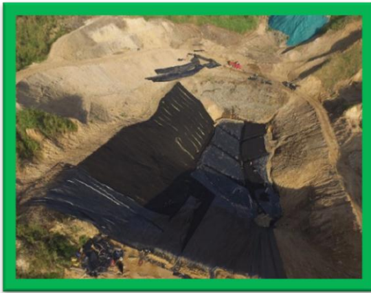
Vista actual de la celda
