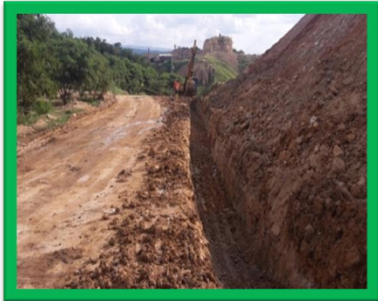
Construcción de sistemas de drenaje para la conducción de lixiviados
