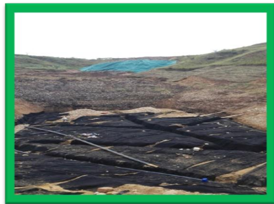
Conformación dren base del dique
