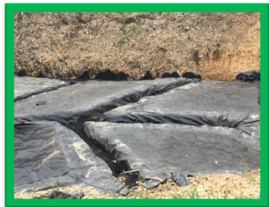
Impermeabilización dren del dique
