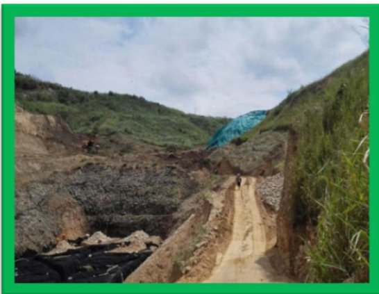
Conformación dren base del dique
