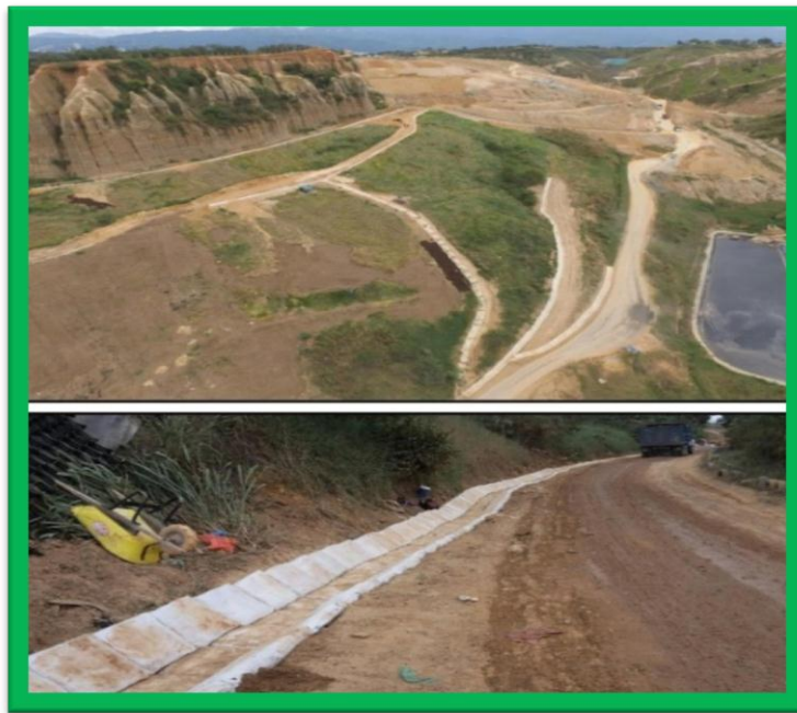
Conducción de los caudales de escorrentía provenientes de las áreas aferentes a la nueva celda 4.
