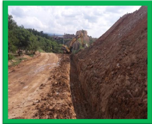
Construcción de sistemas de drenaje para la conducción de lixiviados
