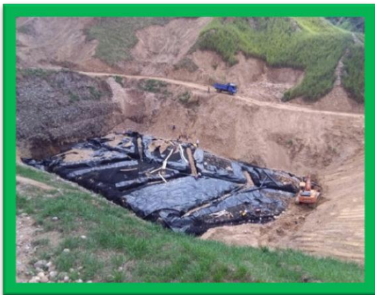
Conformación dren base del dique
