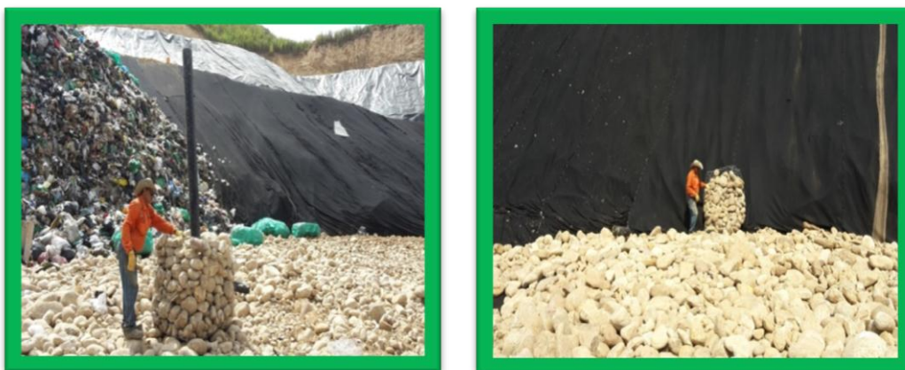
Construcción de chimeneas en la celda 4
