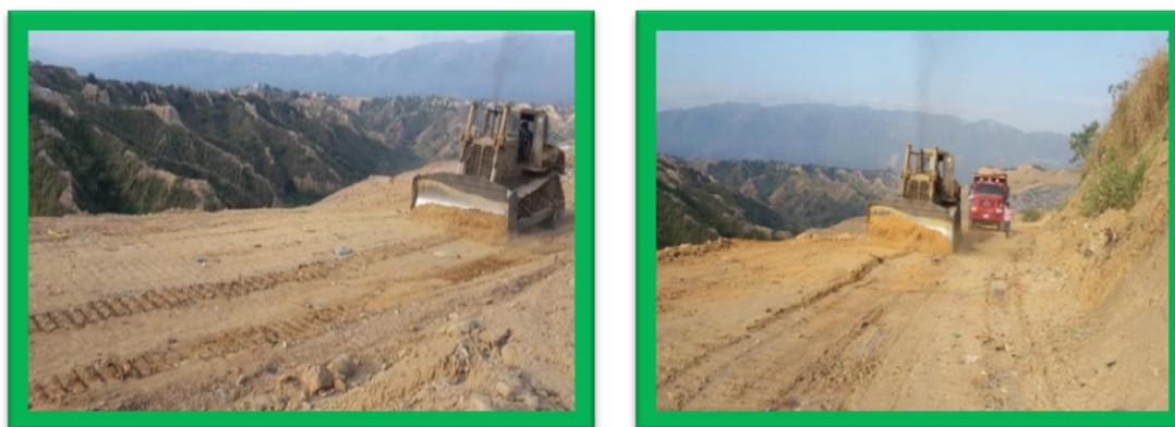
Adecuación de vías para el ingreso de vehículos a la zona de disposición
