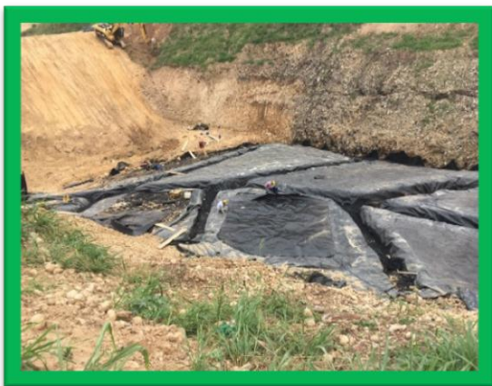
Impermeabilización dren base del dique
