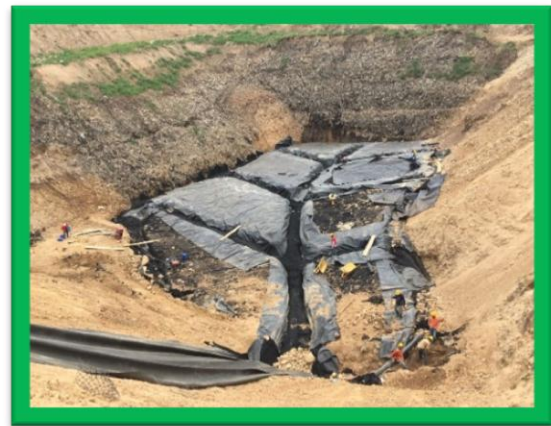
Conformación dren base del dique
