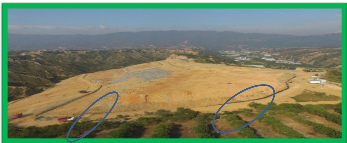
Construcción de filtro perimetral ubicado bajo la parte inferior del talud ubicado en la primera zona de disposición
