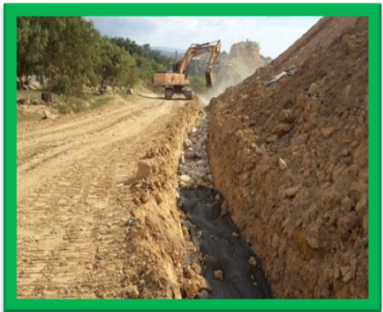
Llenado con bolo y recubrimiento con geotextil de filtro perimetral ubicado sobre la parte inferior del domo de residuos
