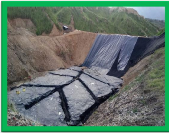
Impermeabilización dren del dique
