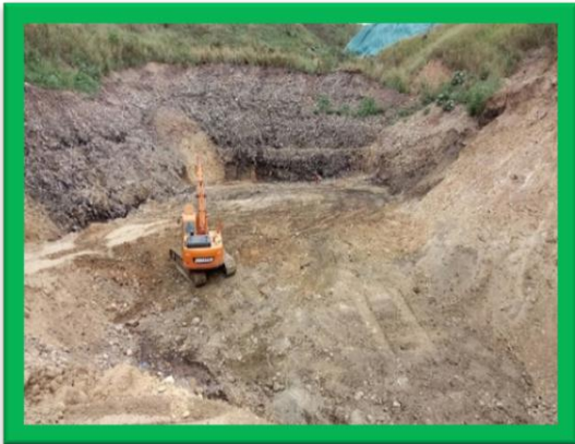
Finalización retiro de residuos sólidos
