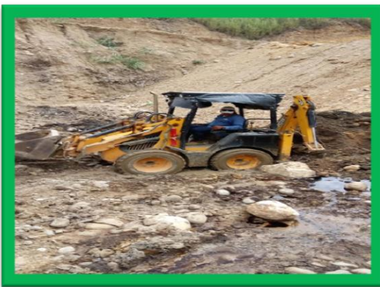
Excavaciones zanjas dren base del dique
