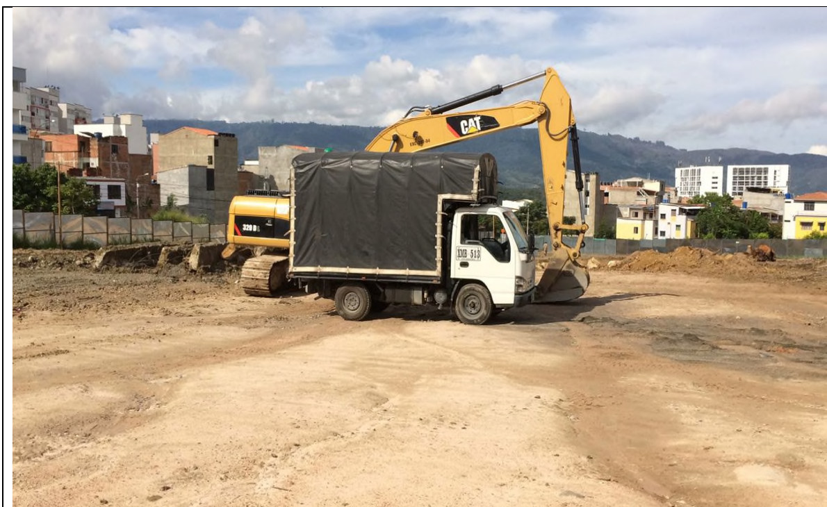
Obras de excavación y replanteo
