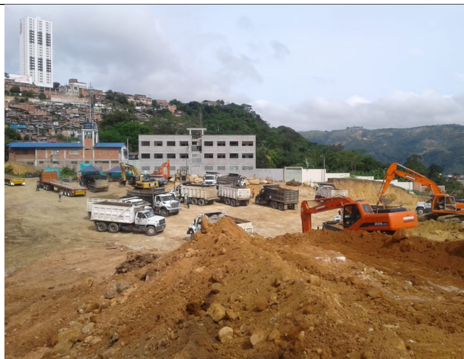
OBRAS DE EXCAVACION
