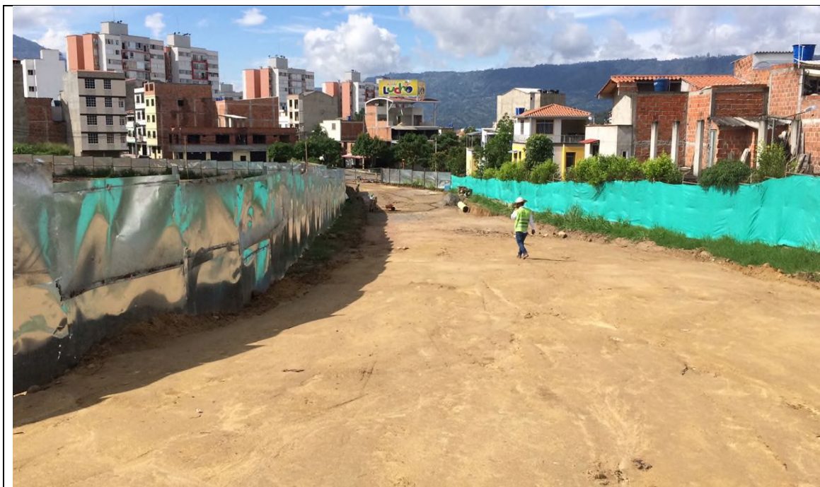
Construcción vía carrera 4ta
